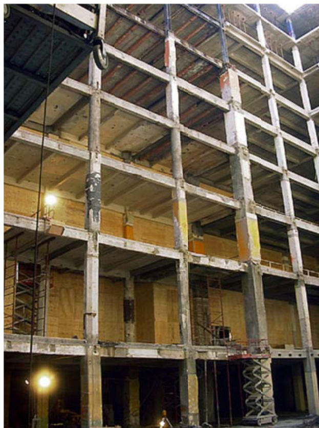
Σχήμα 2.39 Το κτίριο Eaton, κατά τη διάρκεια των εργασιών (Pasquin et al, 2004)
