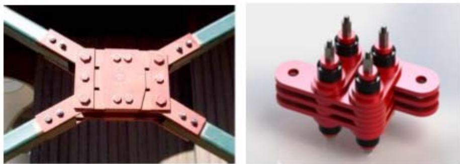
Σχήμα 3.14 Αποσβεστήρες Τριβής (Χατζιράι, 2016 από Elgamal & Fraser, 2004 & www.dampotech.com)
