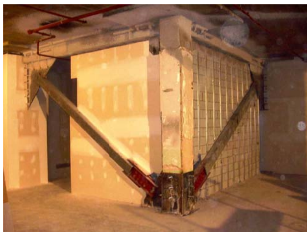
Σχήμα 2.40 Αποσβεστήρες τριβής σε μονούς διαγώνιους μεταλλικούς συνδέσμους (Pasquin et al, 2004)
