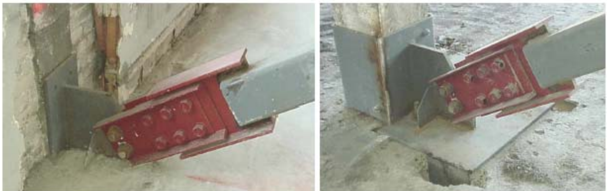
Σχήμα 2.49 Τυπικές λεπτομέρειες συνδέσεων (Vezina & Pall, 2004)
