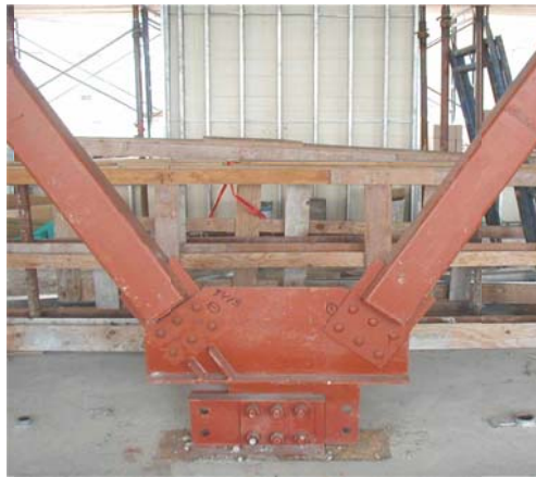
Σχήμα 2.33 Τυπικός αποσβεστήρας τριβής τύπου V (Malhotra et al, 2004)
