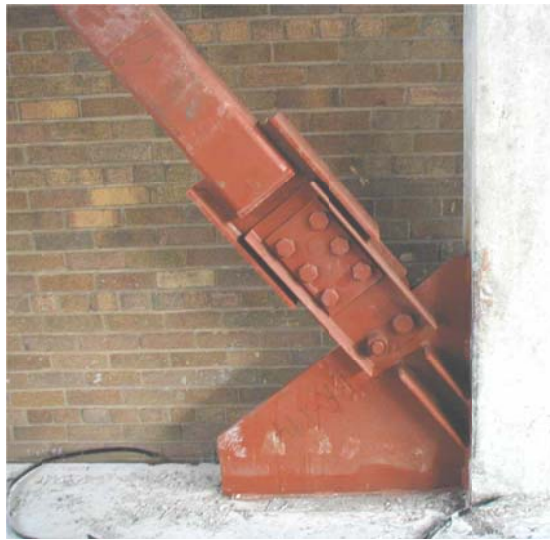
Σχήμα 2.32 Μονός διαγώνιος αποσβεστήρας τριβής (Malhotra et al, 2004)
