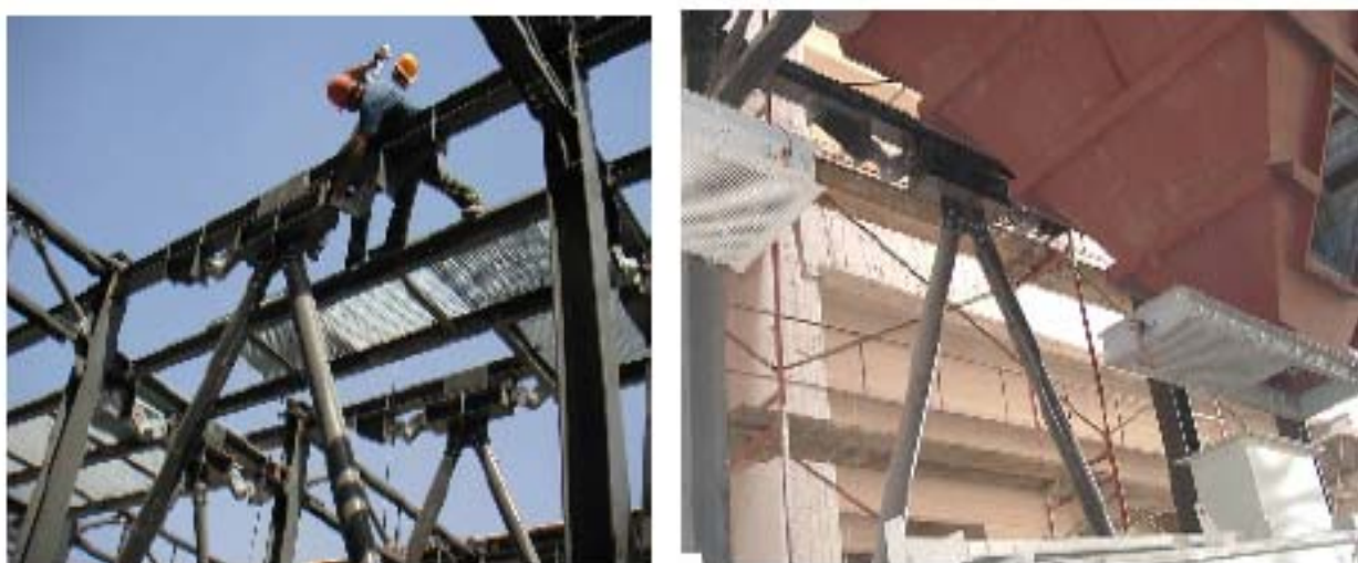
Σχήμα 2.28 Κτίριο εργοστασίου με αποσβεστήρες (Mualla, 2018)
