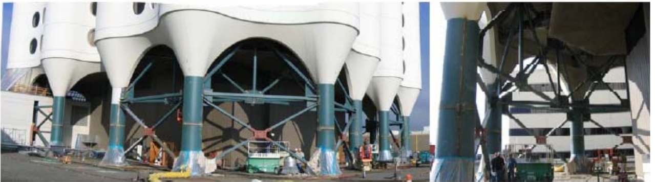
Σχήμα 2.48 Ολοκληρωμένη εγκατάσταση συστήματος απόσβεσης (Shao et al, 2004)
