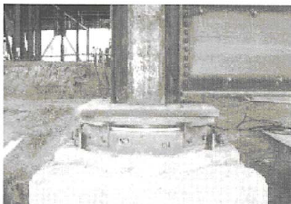
Σχήμα 3.9 Εφέδρανο ολίσθησης (FPS) (Ζιώγκα, 2008).
