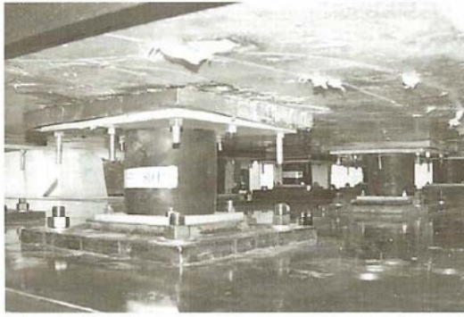
Σχήμα 3.5 Ελαστομεταλλικό εφέδρανο – ELB (Ζιώγκα, 2008).
