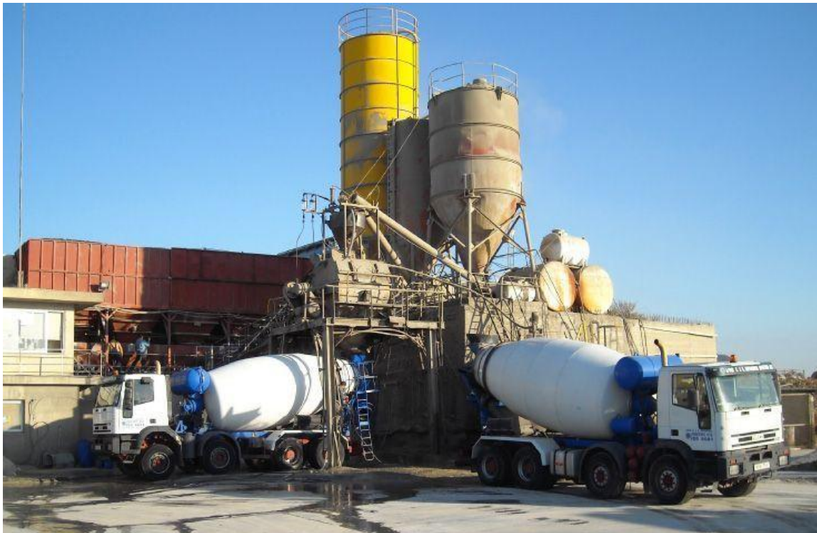
Εικόνα 2.2 Παρασκευή σκυροδέματος ( https://www.karaloucasbeton.com )
