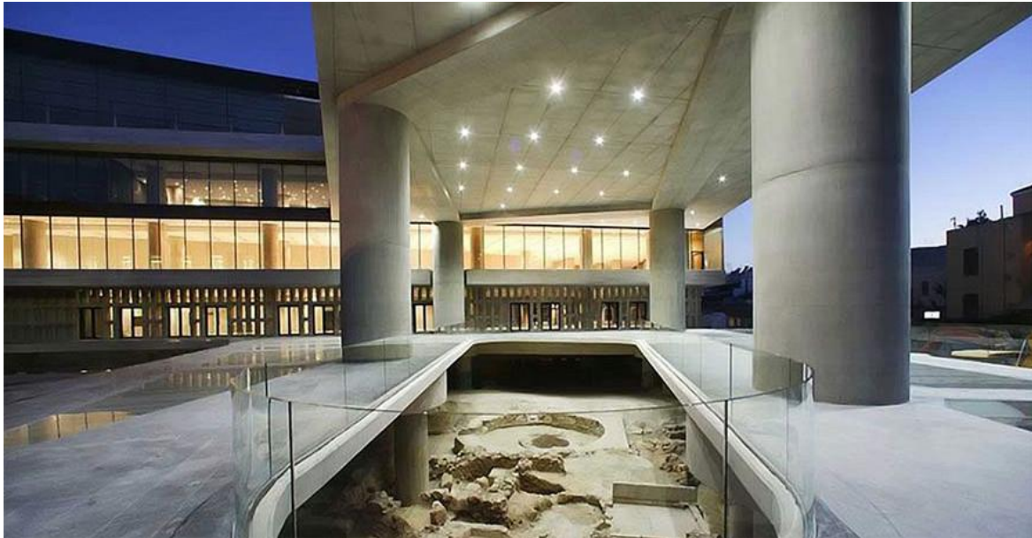
Εικόνα 2.9 Μουσείο Ακρόπολης ο φέρων οργανισμός, είναι από εμφανές Σκυρόδεμα ( https://hashmag.gr )
