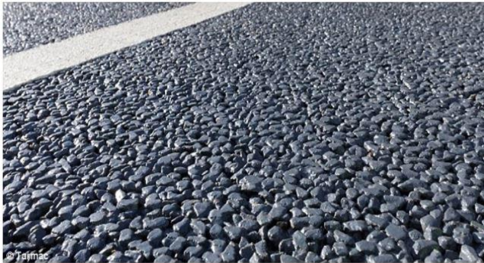
Εικόνα 2.10 χρήση διαπερατού σκυροδέματος αντί για ασφαλτό (www.fire.gr)
