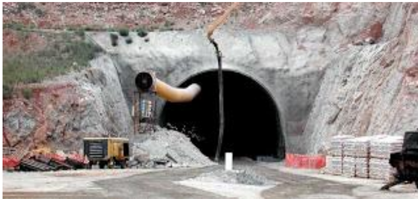
Εικόνα 2.14 Εφαρμογή Ινοπλισμένου σκυροδέματος ( http://kataskevnh.blogspot.com )
