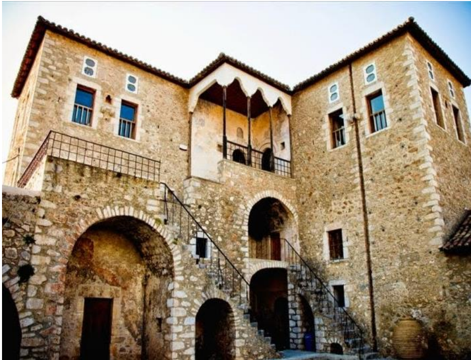
Εικόνα 16: Ο Πύργος του Τσικαλιώτη από την αυλή, πρόκειται για την εσωτερική γωνιά του κτιρίου με «ξουστάγι».
