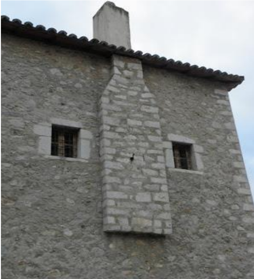
Εικόνα 80: Η καμινάδα του τζακιού στον 2 ο όροφο επειδή δέχεται και την καμινάδα του τζακιού του 1 ου ορόφου, έχει κατάσκευαστεί μεγαλύτερη εξωτερικά και είναι κατασκευασμένη από πέτρα. Πηγή: Προσωπική λήψη.
