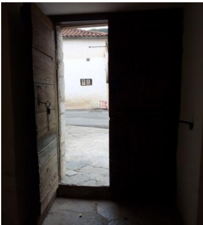
Εικόνα 55: Πύργος Τσικαλιώτη. Η είσοδος της καμάρας του ισογείου. Πηγή: Προσωπική λήψη.
