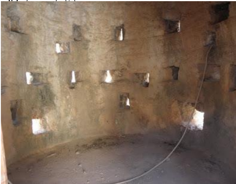
Εικόνα 45: Η εσωτερική άποψη του πυργίσκου. Πηγή: Προσωπική λήψη.
