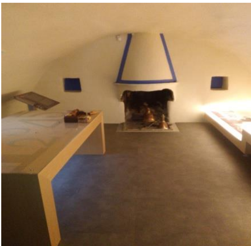
Εικόνα 79: Τζάκι το οποίο μαζί με το τζάκι του 2 ου ορόφου έχουν κοινή καπνοδόχο. Πηγή: Προσωπική λήψη.
