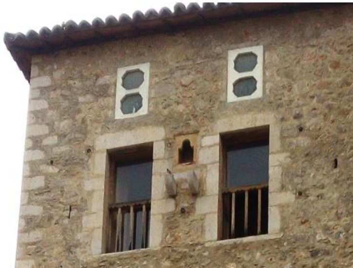
Εικόνα 17: Τα παράθυρα φέρουν ξύλινο κιγκλίδωμα και τα παντζούρια είναι εσωτερικά. Πάνω από τα παράθυρα υπάρχουν φεγγίτες, οι οποίοι είναι καμπυλωτής μορφής με ορθογωνικόκορνίζωμα. Οι κατακόρυφοι γωνιόλιθοι είναι λευκοί λαξευμένοι με εναλλάξ τοποθετημένους οριζόντιους και κατακόρυφους λίθους. Οι ποδιές των παραθύρων είναι πέτρινες πλάκες μικρού πάχους. Τα περθια των παραθύρων είναι οριζόντια από μονόλιθους που στηρίζονται στις κατακόρυφες παραστάδες.
