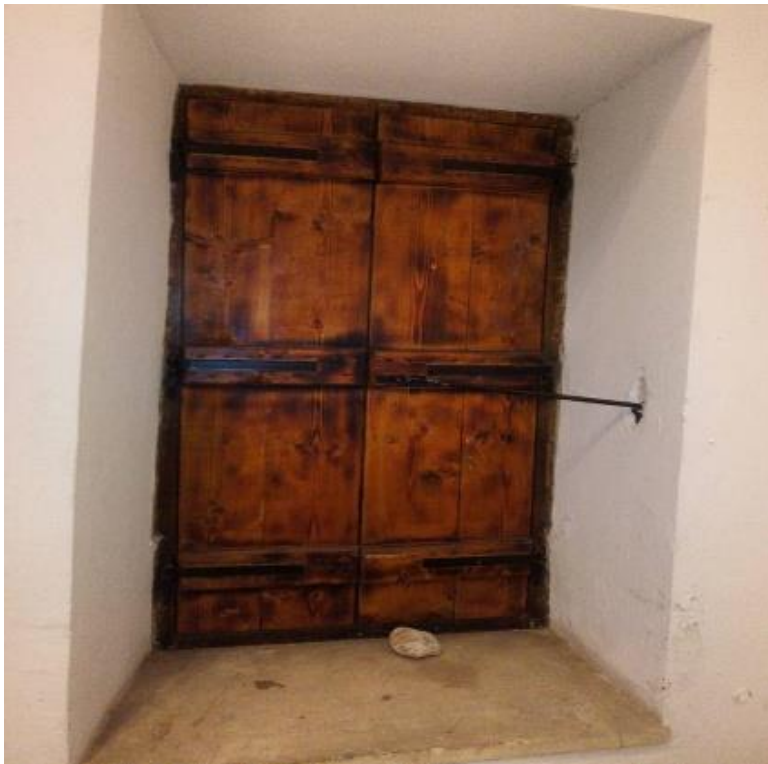
Εικόνα 56: Πυργος Τσικαλιώτη.Το παράθυρο της καμάρας στο ισόγειο. Πηγή: Προσωπική λήψη.
