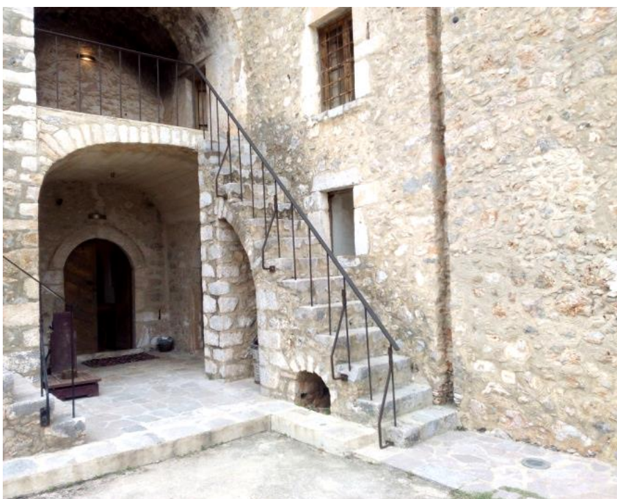
Εικόνα 34: Πύργος Τσικαλιώτη. Ο χώρος μπροστά από την αυλόπορτα της καμάρας, καλύπτεται από δύο τουφεκίστρες εκατέρωθεν της πόρτας όπως βλέπουμε στην παραπάνω εικόνα. Φαίνονται τα σκαλοπάτια που οδηγούν στο δωμάτιο με την κρύπτη. Πηγή: Προσωπική λήψη.
