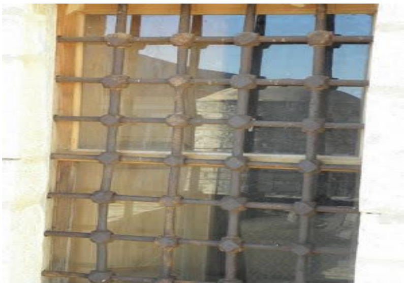
Εικόνα 41: Πύργος Τσικαλιώτη. Τα κάγκελα στο παράθυρο του 1 ου Ορόφου του Πύργου, με τους 14 γωνιακούς κόμπους. Διακρίνονται και δω επιρροές από την Ανατολή.
