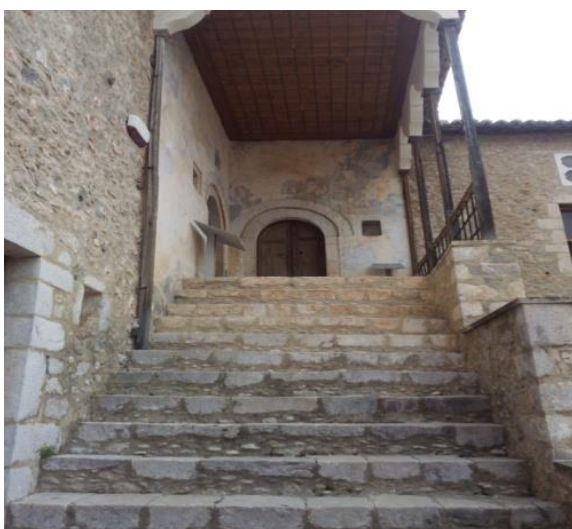
Εικόνα 42: Τα σκαλιά που οδηγούν στο Β' Όροφο (Τα τελευταία είναι ασύμμετρα)
