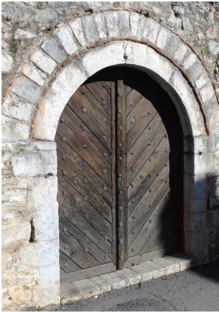
Εικόνα 30: Η αυλόθυρα. Στο υπέρθυρό της φέρει τη χρονολογία κατασκευής του Πύργου. (1808)
