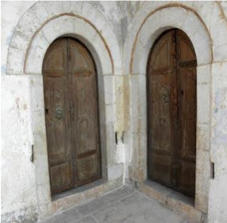
Εικόνα 18: Θύρες με τοξωτα υπέρθυρα. Τα υπέρθυρα αυτά δημιουργούνται από δύο λίθινες ζώνες και μια ενδιάμεση ζώνη από κεραμίδι. Πηγή: Προσωπική λήψη.
