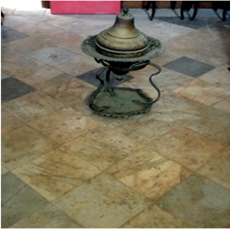
Εικόνα 108: Το δάπεδο είναι μαρμάρινο και τρίχρωμο (λευκό, μαύρο, γκρι). Σίγουρα όμως αυτό δεν είναι το αρχικό δάπεδο καθώς σε ένα σημείο φαίνεται να έχει παλιότερο υλικό. Πηγή: Προσωπική λήψη.
