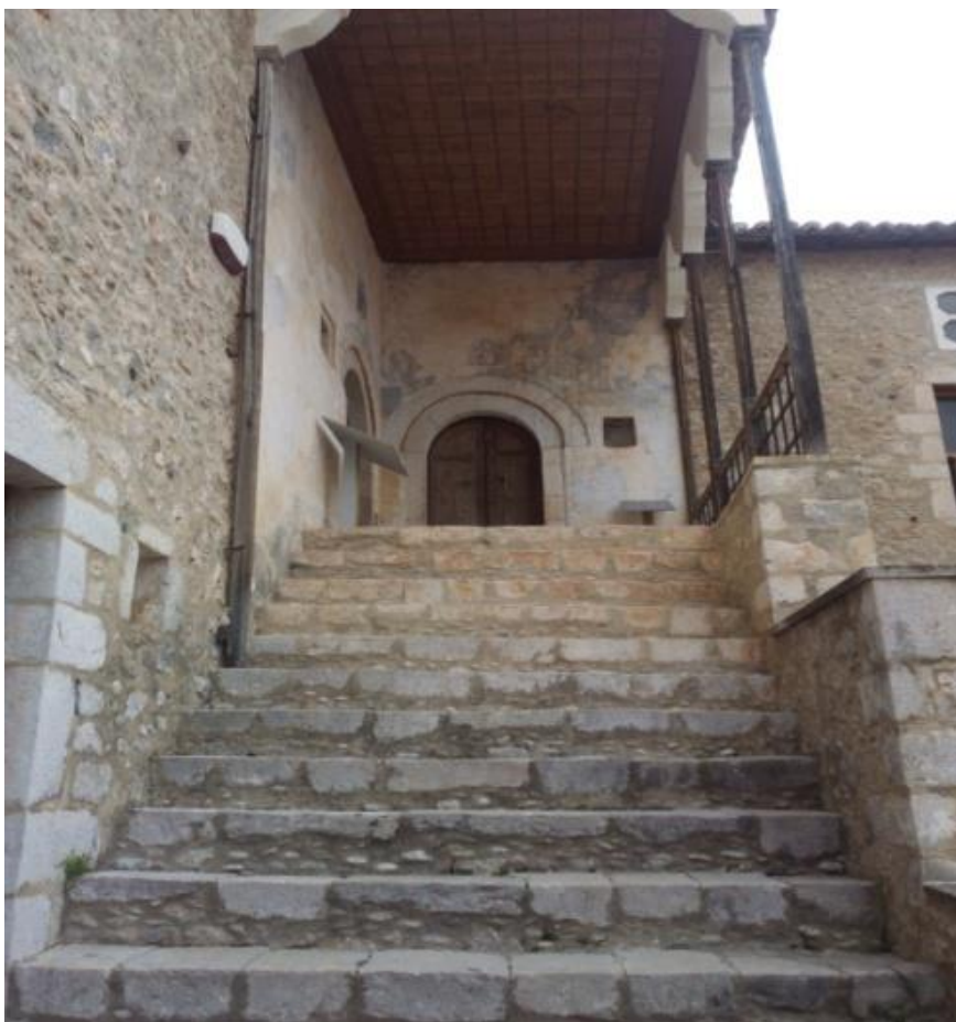
Εικόνα 81: Τα εξωτερικά σκαλοπάτια συνδέουν τον Α' Όροφο με τον Β' Όροφο Πηγή: Προσωπική λήψη.
