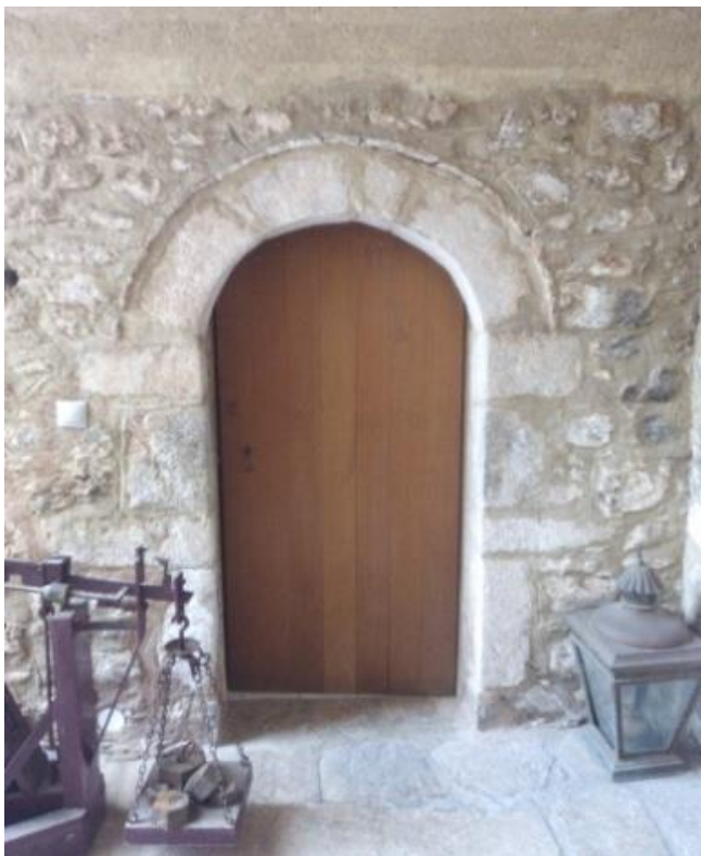
Εικόνα 59: Η πόρτα που οδηγεί σε έναν από τους βοηθητικούς χώρους του κτιρίου.
