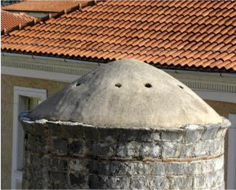
Εικόνα 46: Πυργος Τσικαλιώτη.Η οροφή του πυργίσκου από κουρασάνι. Υπάρχουν τρύπες στο πάνω μέρος του για να απομακρύνεται ο καπνός. Πηγή: Προσωπική λήψη.
