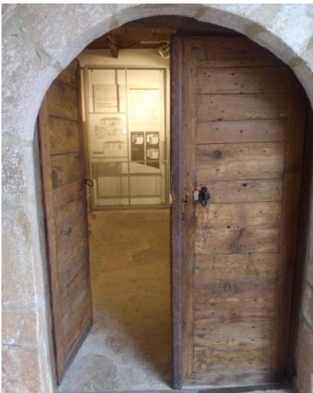
Εικόνα 60: Η πόρτα που οδηγεί σε έναν από τους βοηθητικούς χώρους του κτιρίου. Πηγή: Προσωπική λήψη.
