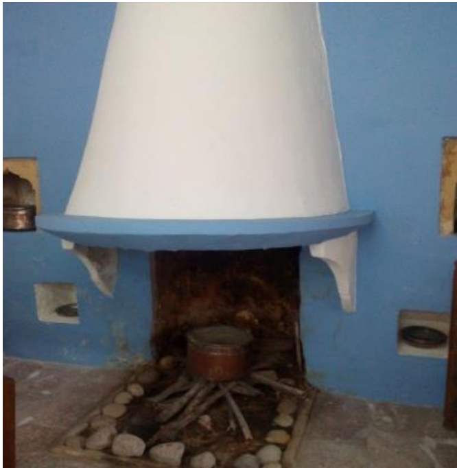
Εικόνα67: Το τζάκιπου βρίσκεται στο έναν από τους βοηθητικούς χώρους του ισογείου. Πηγή: Προσωπική λήψη.
