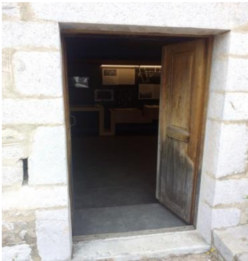
Εικόνα 72: Η πόρτα που οδηγεί στο δωμάτιο του Α' Ορόφου. Φαίνονται οι λαξευμένες πέτρες στην πόρτα. Πηγή: Προσωπική λήψη.
