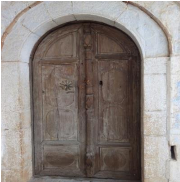
Εικόνα 19: Εξώπορτα ορόφου με τοξωτό υπέρθυρο. Φαίνονται τα περίτεχνα σχέδια και το ροπτρο. Πηγή: Προσωπική λήψη.
