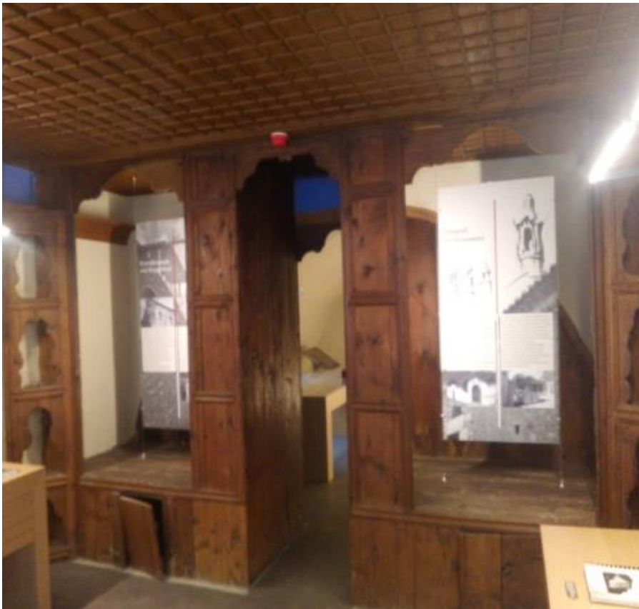
Εικόνα 74: Το ξυλόγλυπτο ταβάνι του Α' Ορόφου και η ξύλινη μεσάντρα. Πηγή: Προσωπική λήψη.
