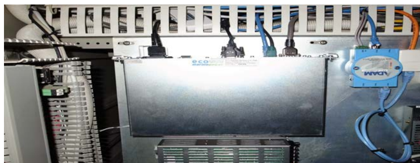
Εικόνα 35. Κεντρική μονάδα επεξεργασίας EMP Aquarius MAS CPU/AGU
