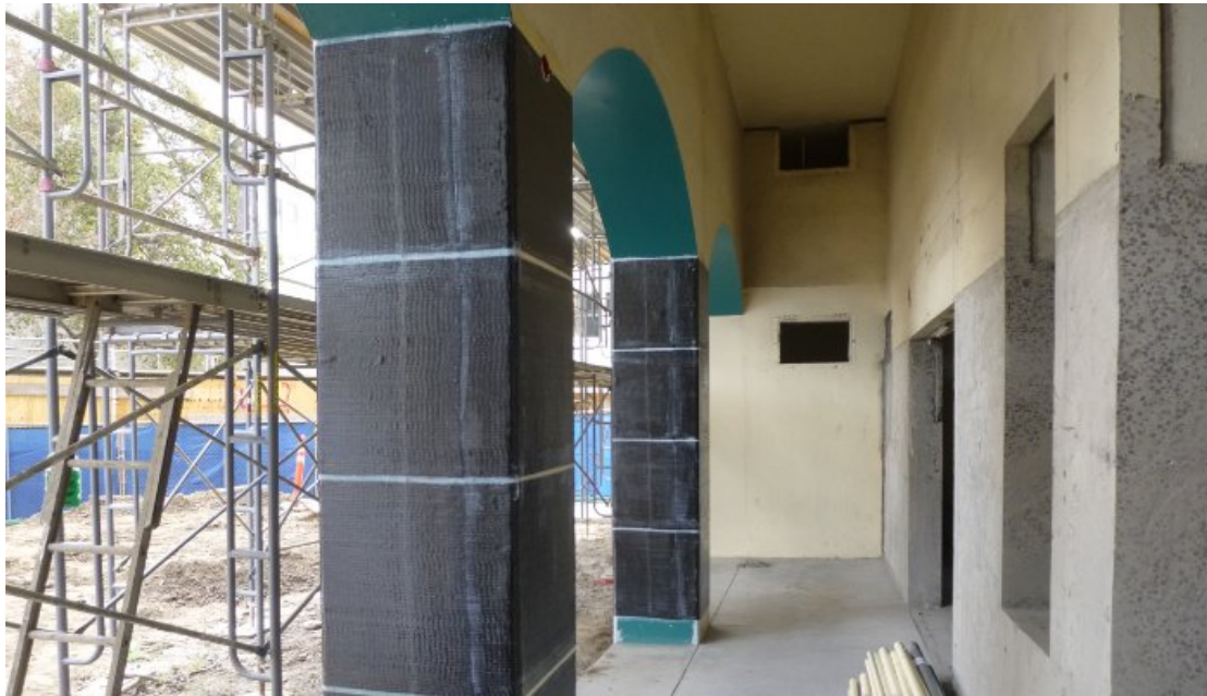
Σχήμα 5.3: Περίσφιξη υποστυλωμάτων με FRPs.
