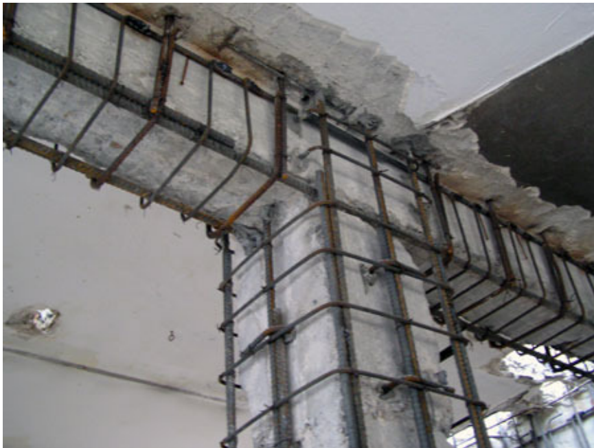
Σχήμα 5.2: Τοποθέτηση οπλισμού μανδύα περιμετρικά υποστυλώματος και δοκών
