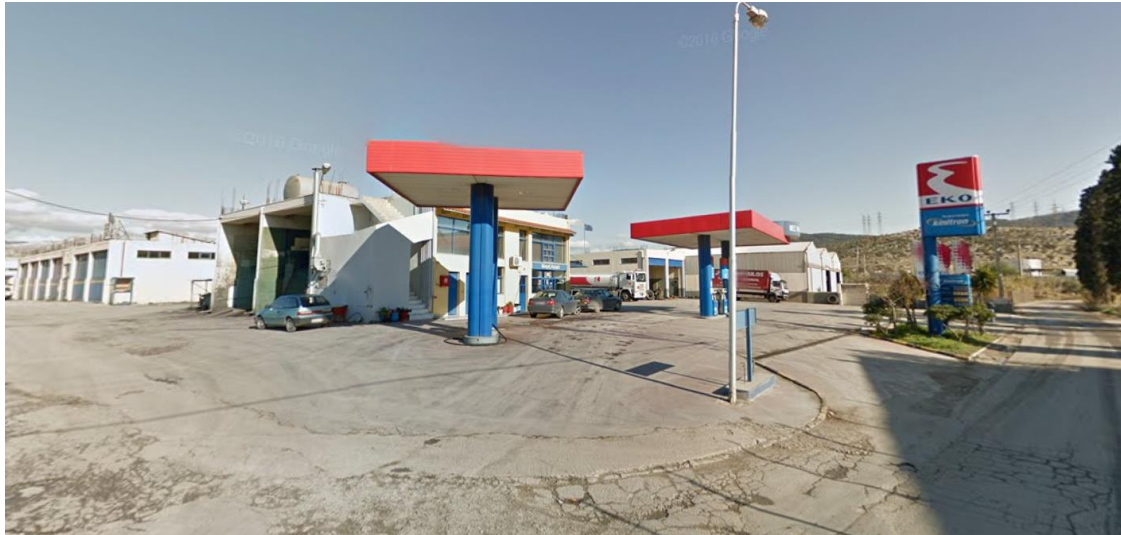
Εικόνα 30 Πρατήριο υγρών καυσίμων εντός της ΒΙΟΠΑ
