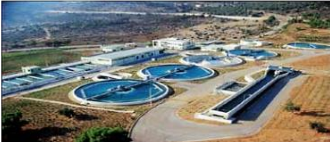
Εικόνα 96 Μονάδα Επεξεργασίας Νερού Ασπροπύργου
