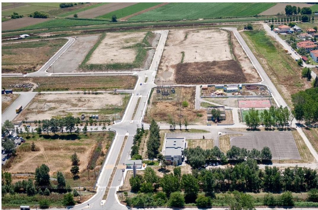
Εικόνα 22 Είσοδος Βιομηχανικό Πάρκου
