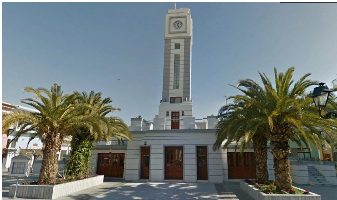
Εικόνα 90 Σημερινό ρολόι Ασπροπύργου μετά την ανακατασκευή του.
