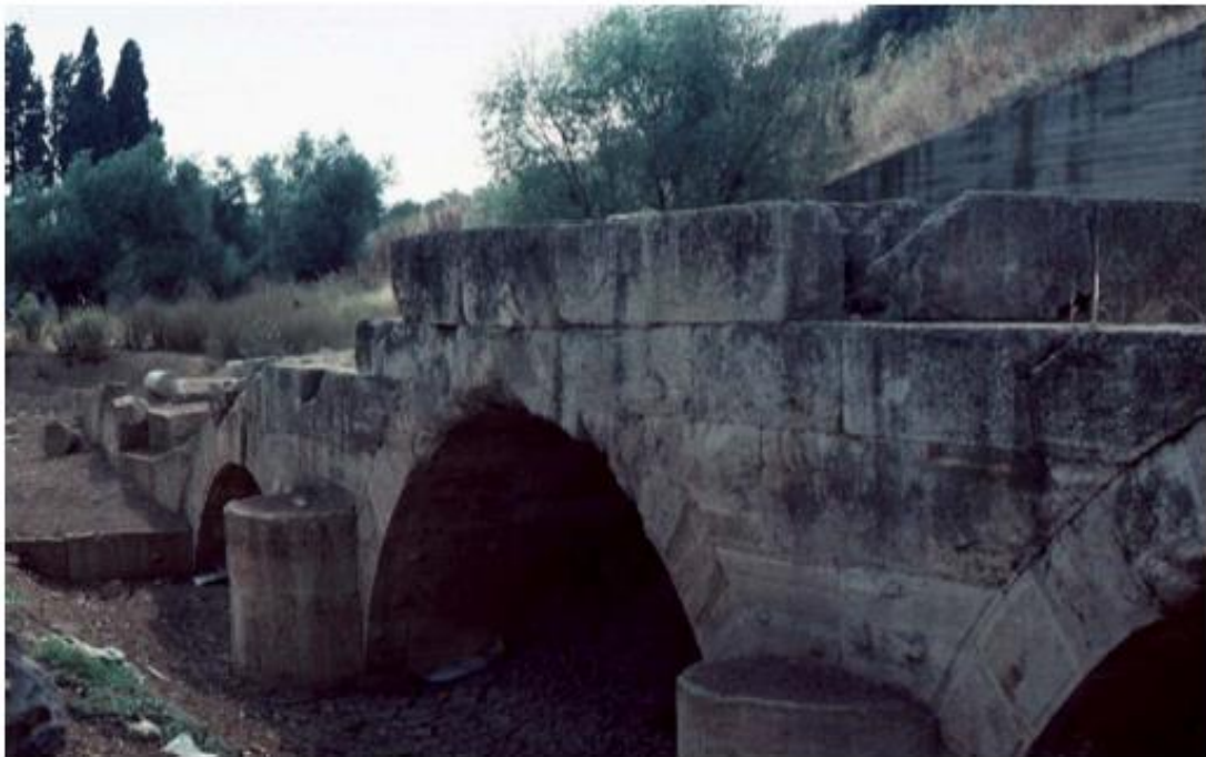
Εικόνα 85 Τμήμα της γέφυρας
