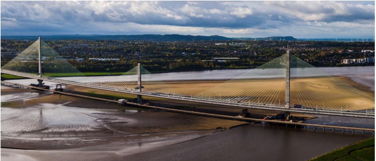
Εικόνα 8: Η Γέφυρα Mersey Gateway
