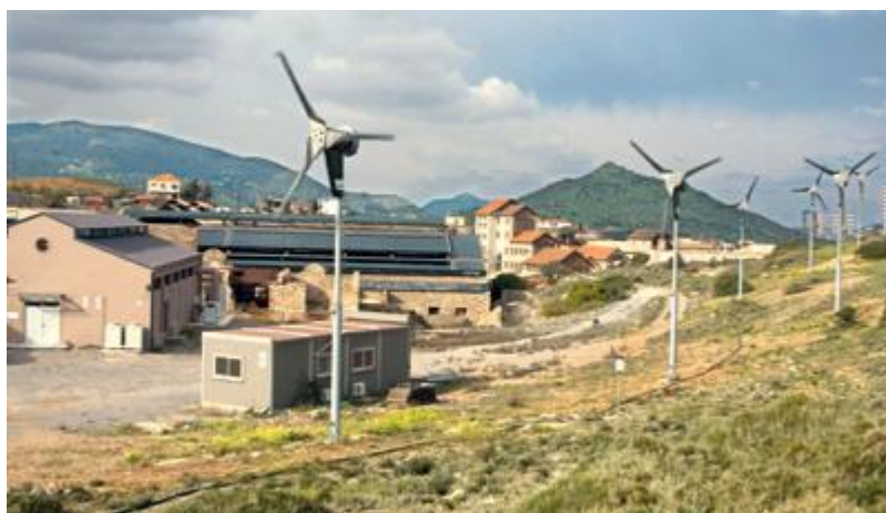
Εικόνα 3.6 Κτήριο του ΚΑΠΕ απόλυτης ενεργειακής αυτονομίας στο Λαύριο, [www.crees.gr]
