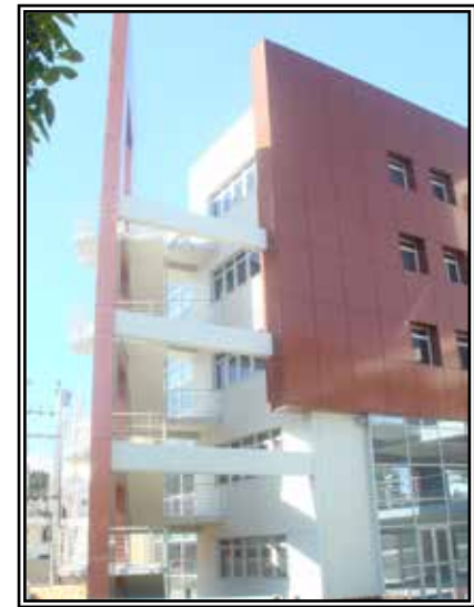
Εικ.91: Εξωτερικό κλιμακοστάσιο δημαρχείου Περιστερίου
