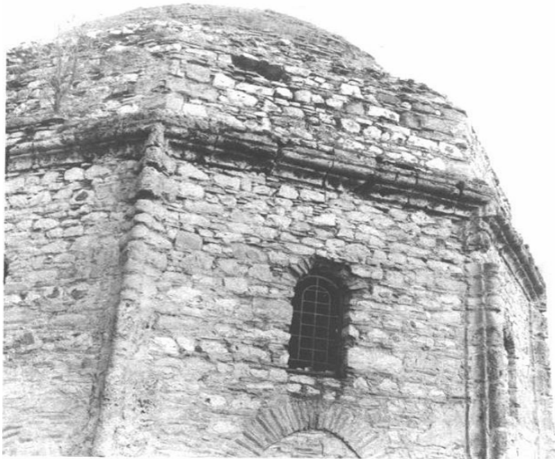
Εικόνα 1.2.23 : Λεπτομέρεια της κατασκευής των πλαισίων στις όψεις του τουρμπέ
