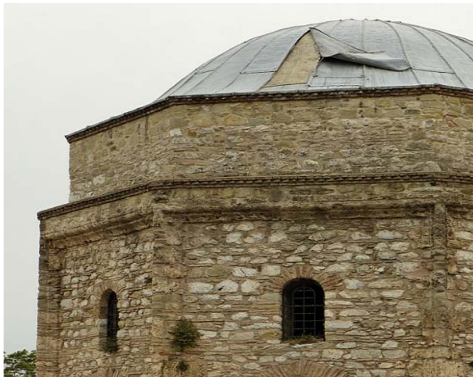
Εικόνα 1.2.24: Λεπτομέρεια της κατασκευής των πλαισίων στις όψεις του τουρμπέ. Φωτο Αλεξάνδρου Κουτσορούμπα 2005
