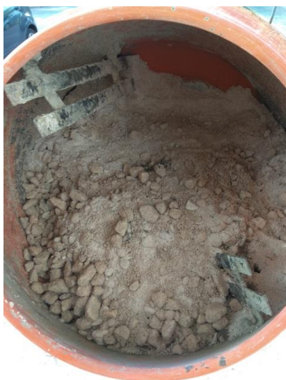
Εικόνα 4.7. Τοποθέτηση 1/3 νερό στον κάδο ανάμειξης
