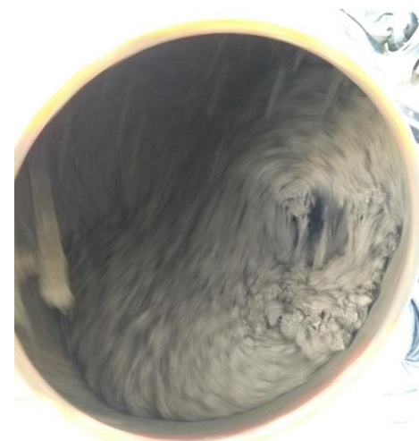
Εικόνα 4.11. Τοποθέτηση νερού και ρευστοποιητή στο μείγμα
