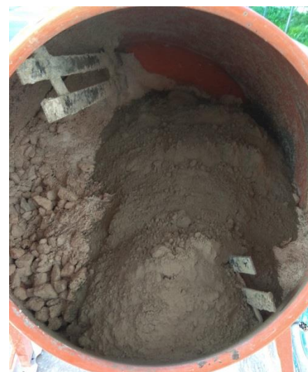
Εικόνα 4.8. Τοποθέτηση τσιμέντου στον κάδο ανάμειξης
