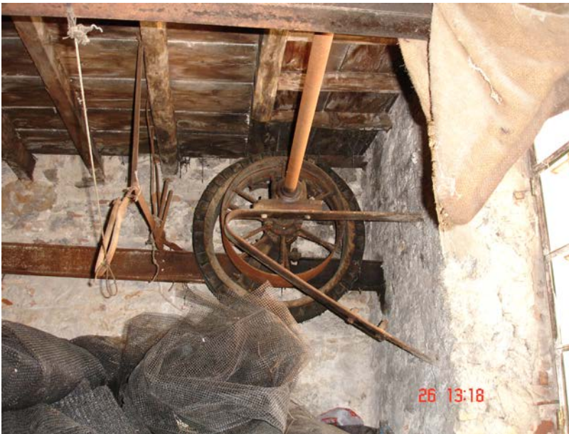
Τμήμα μεσοπατώματος και τροχαλίες στηριζόμενο σε αυτό και στον τοίχο.
