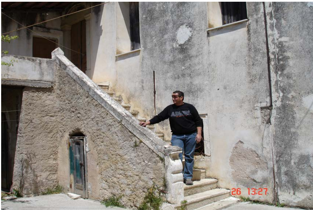
Νότια όψη κτιρίου από άλλη περιμετρική άποψη
