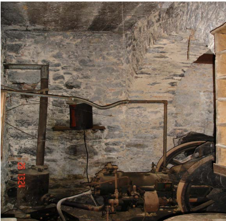
Ατμομηχανή από άλλη φωτογραφική άποψη και σύστημα παραγωγής ατμού Φωτογραφικό υλικό από ελαιοτριβείο Αρμολίων Χίου ιδιοκτησίας ΚΩΝ. Γ. ΣΑΛΙΑΡΗΣ
