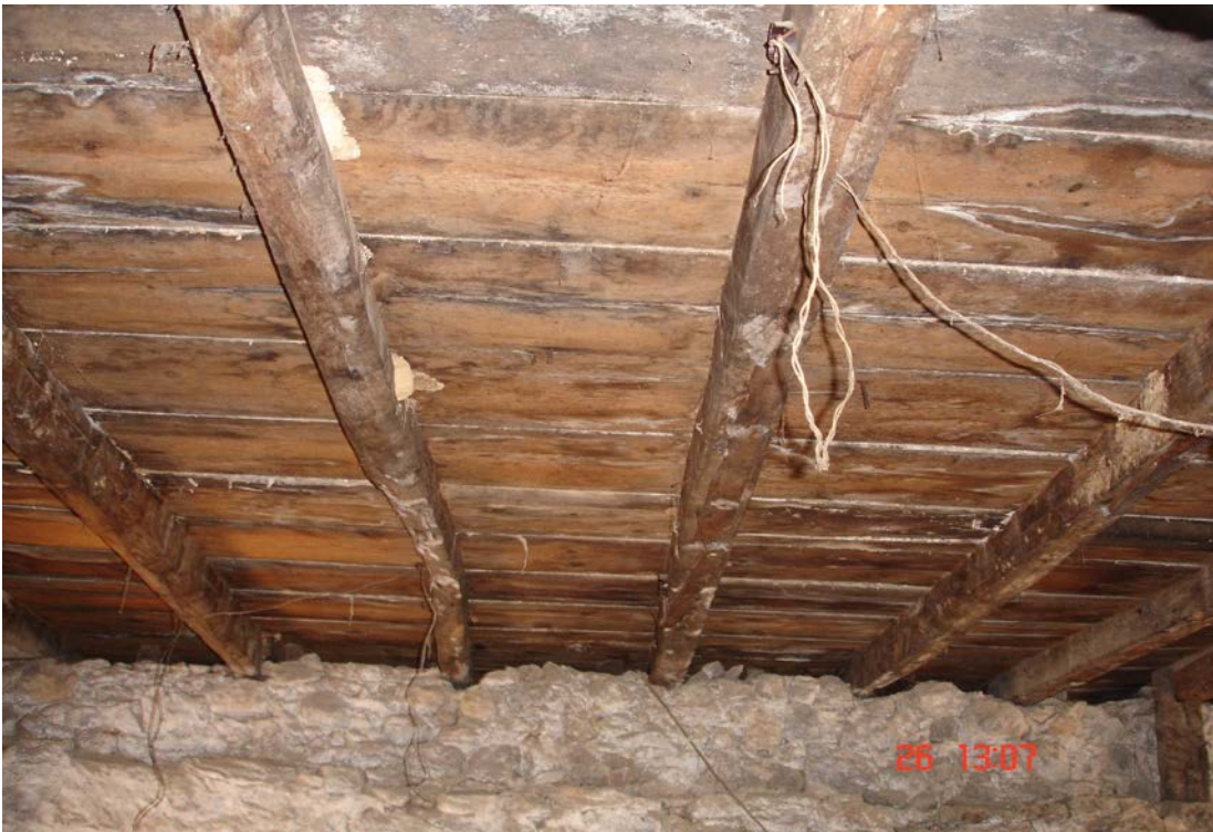
Μεγάλο τμήμα μεσοπατώματος
