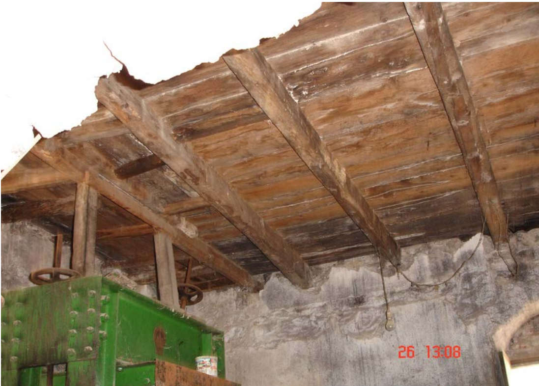
Τμήμα μεσοπατώματος και στήριξη του χειροκίνητου πιεστηρίου στο μεσοπάτωμα, από άλλη οπτική άποψη.
