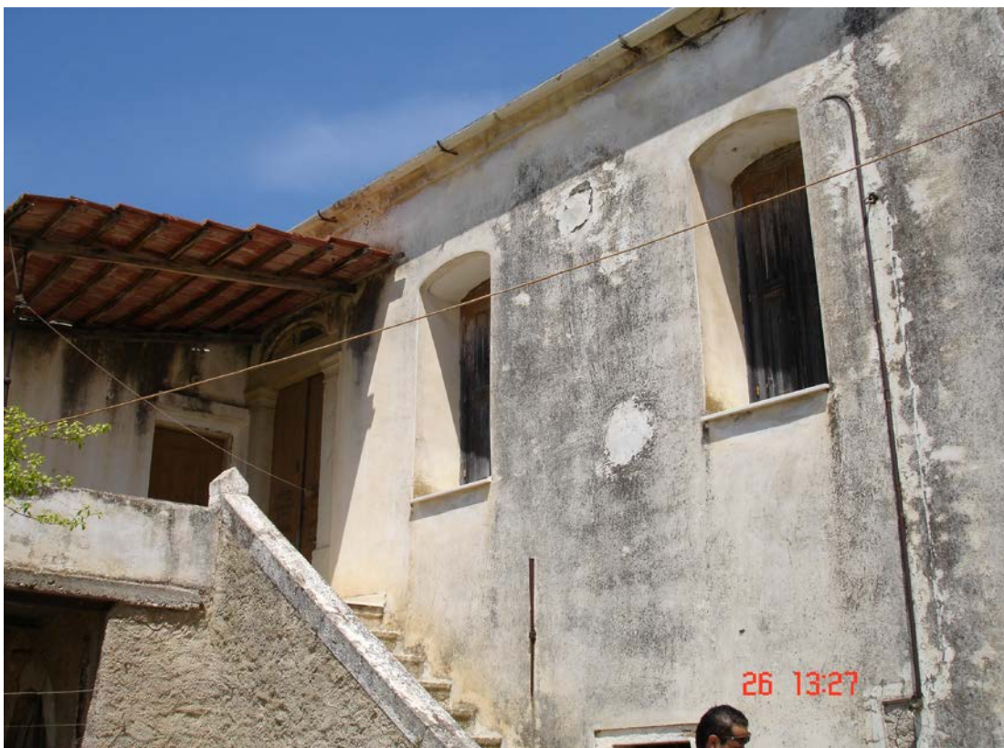
Νότια όψη κτιρίου από άλλη περιμετρική άποψη
