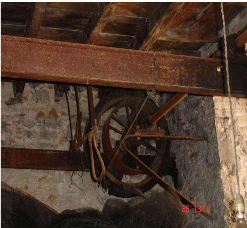
Τμήμα μεσοπατώματος και τροχαλίες στηριζόμενο σε αυτό και στον τοίχο.
