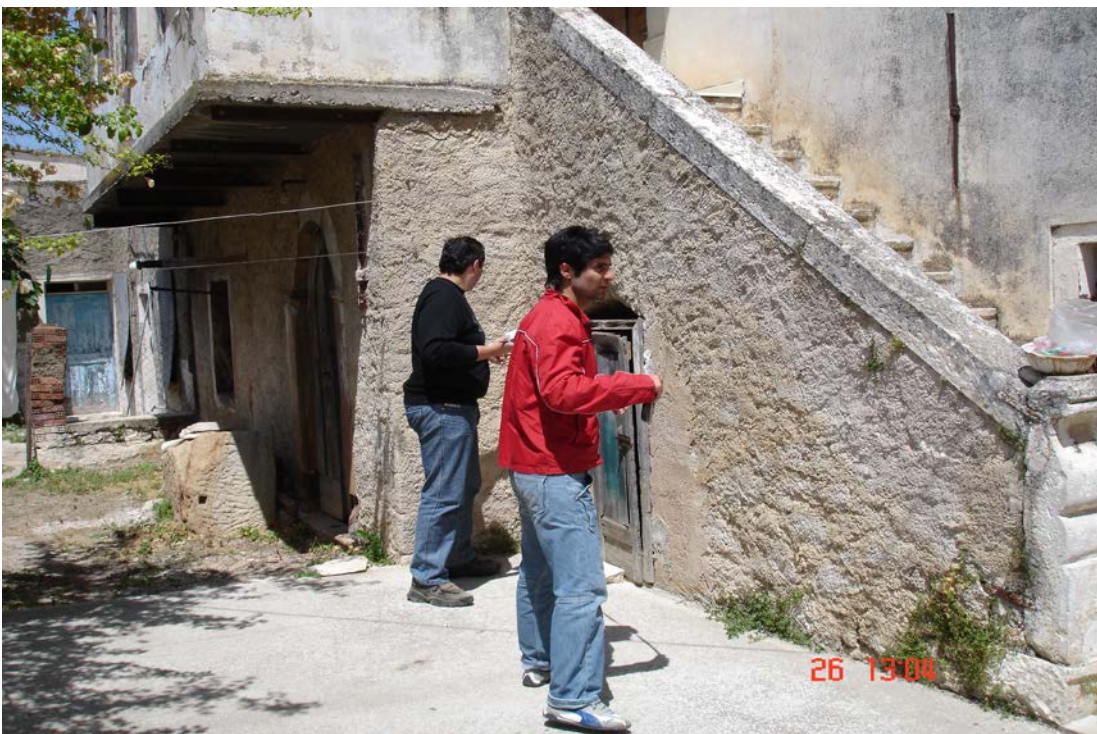
Νότια όψη κτιρίου
