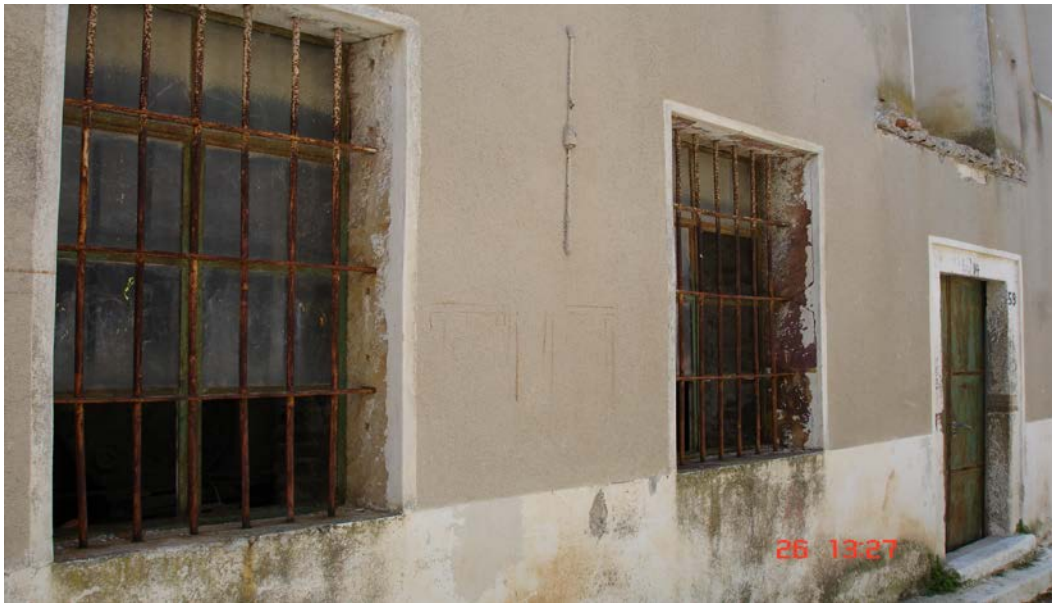
Βόρεια όψη κτιρίου από άλλη περιμετρική άποψη
