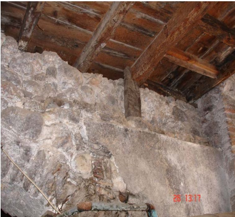
Τμήμα μεσοπατώματος
