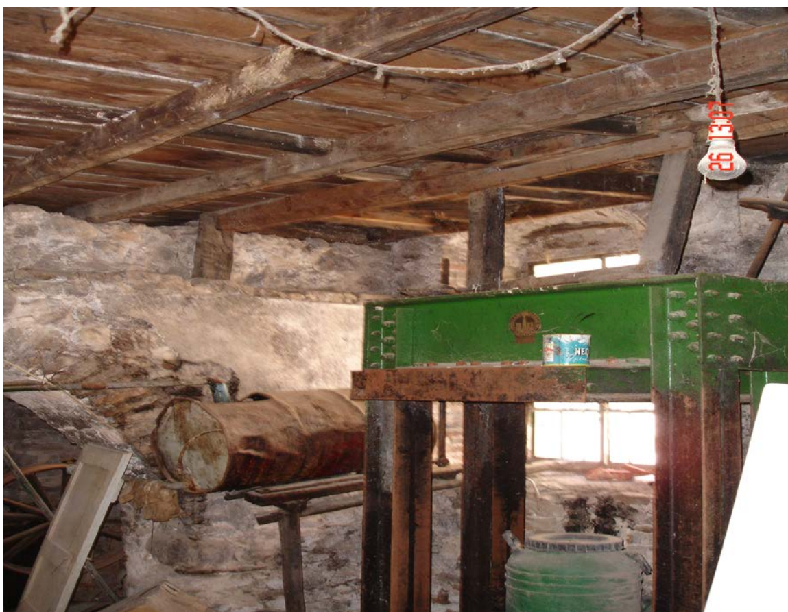
Τμήμα μεσοπατώματος και στήριξη του χειροκίνητου πιεστηρίου στο μεσοπάτωμα
