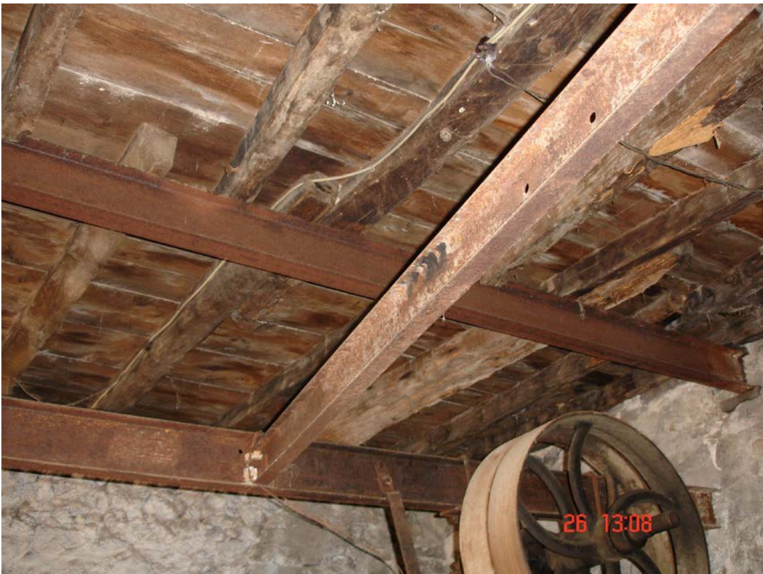
Μεγάλο τμήμα μεσοπατώματος
