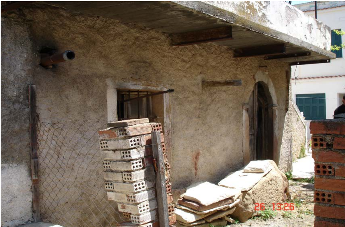
Νότια όψη κτιρίου από άλλη περιμετρική άποψη
