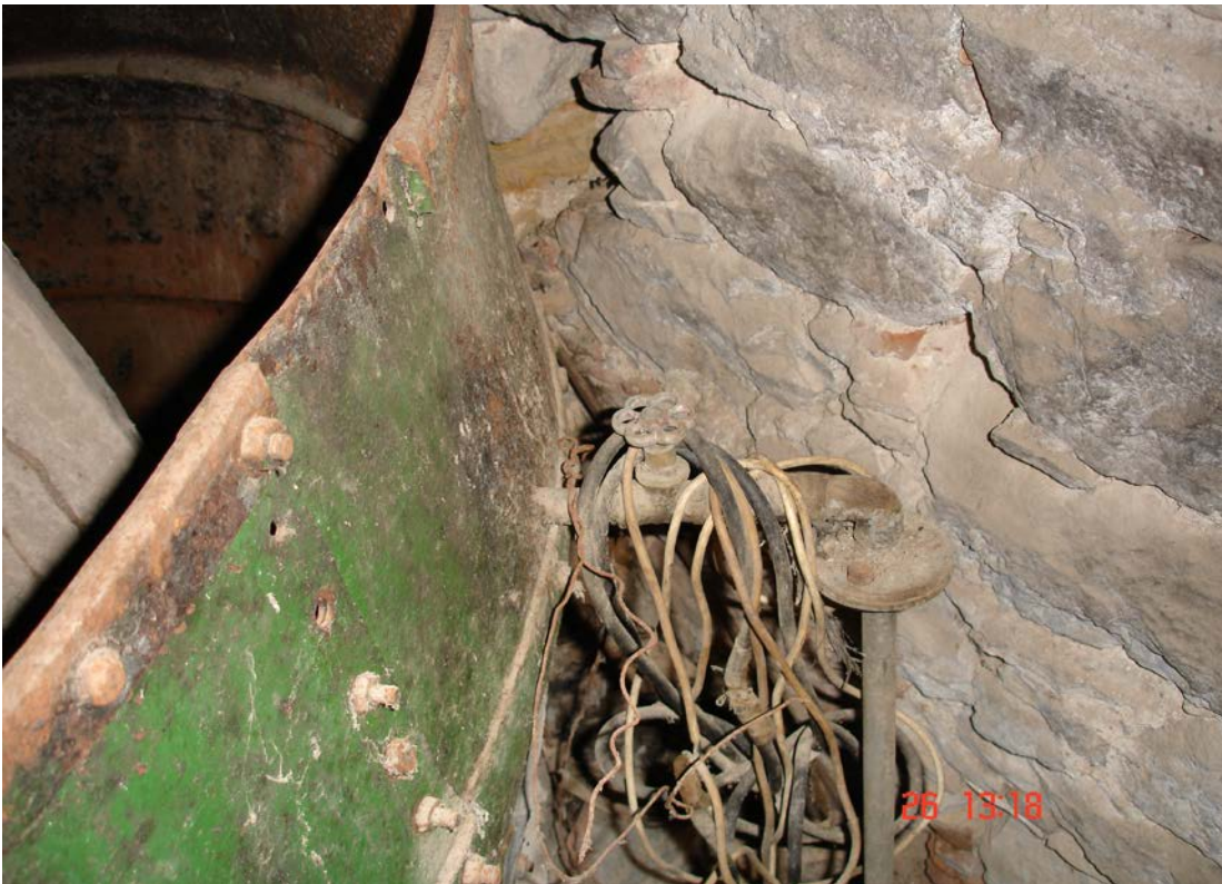
Βάνα άντλησης νερού για καθαρισμού ελαιομυλου
