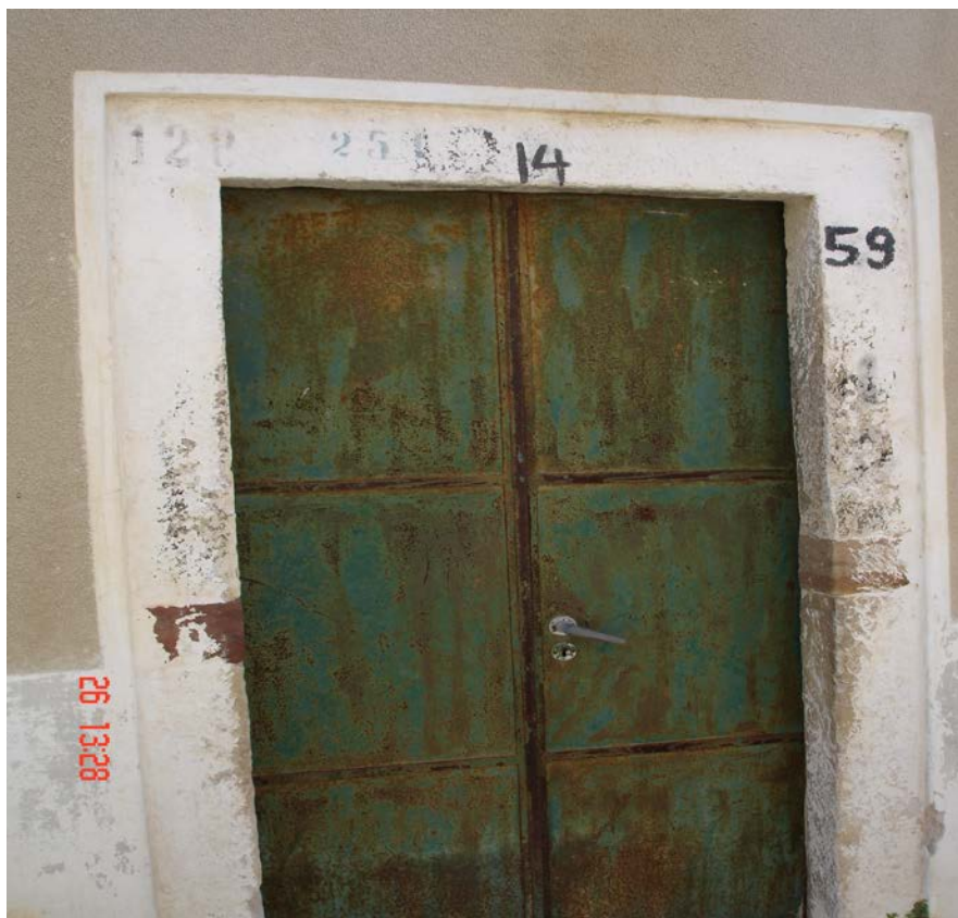
Λεπτομερής άποψη πόρτας
