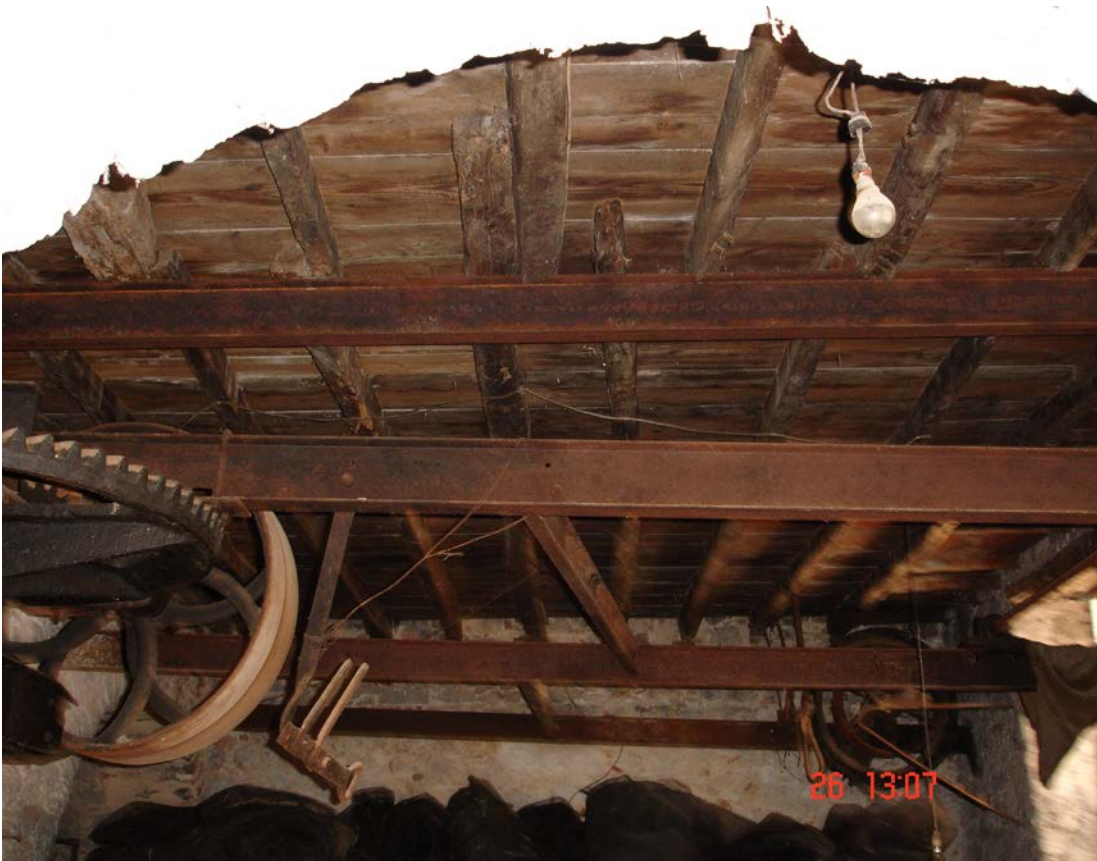
Μεγάλο τμήμα μεσοπατώματος.
