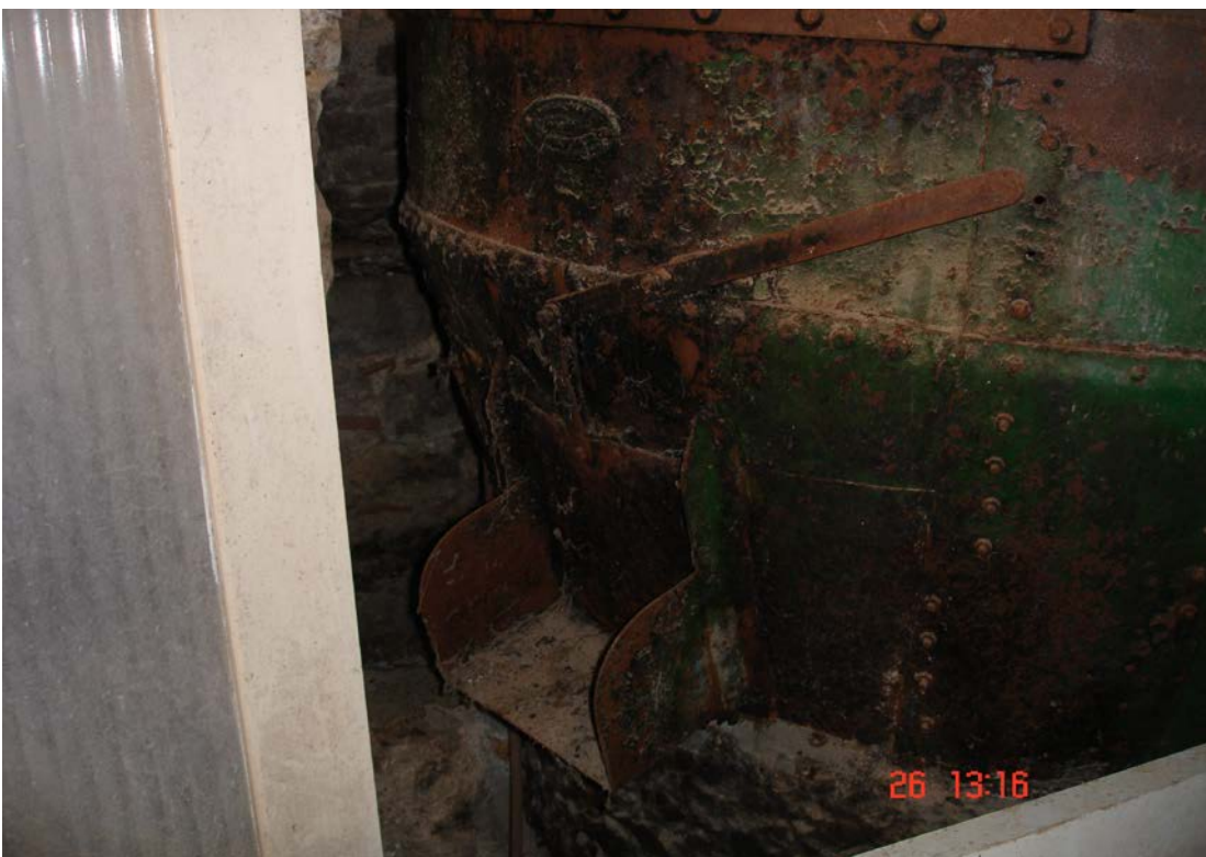
Θύρα εξαγωγής ελαιοπόλτου
