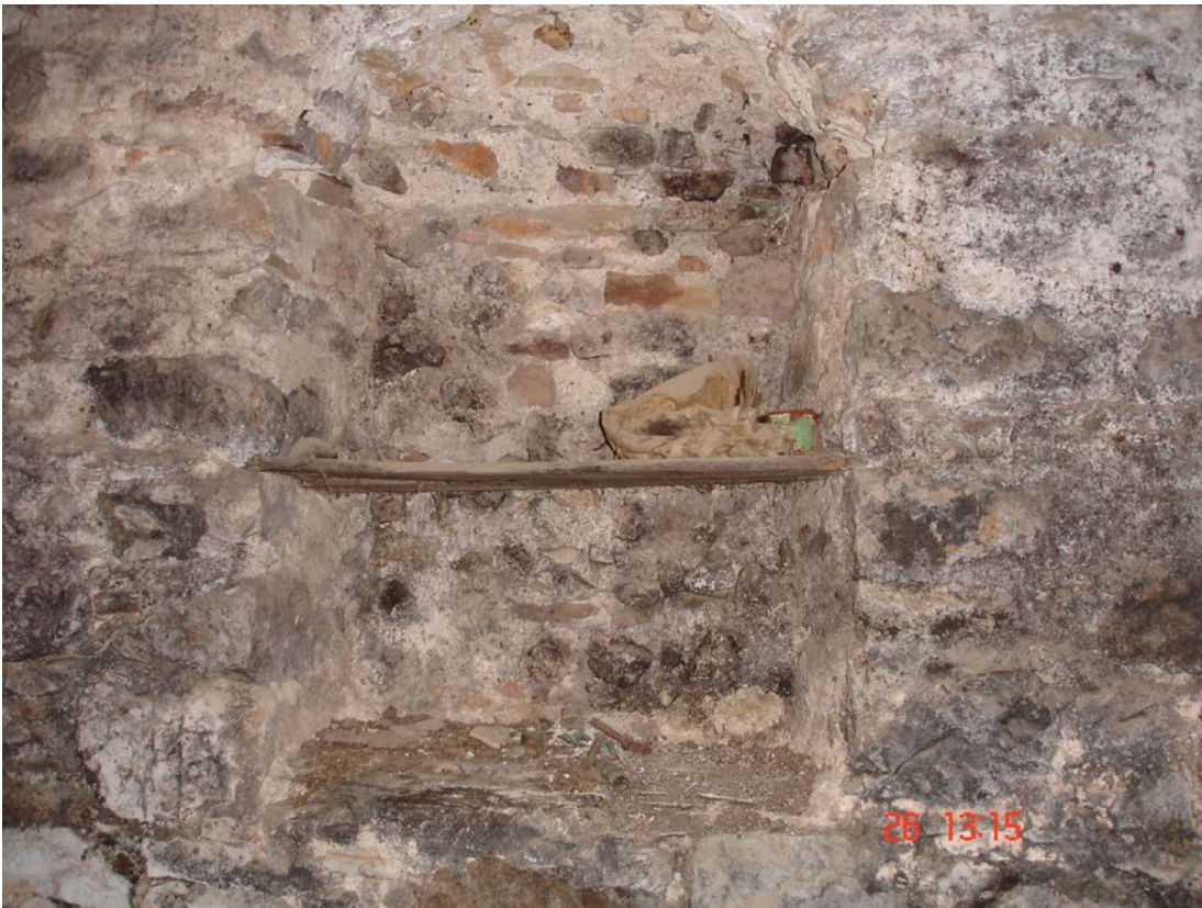
Άνοιγμα στον τοίχο και δημιουργία πλατώματος για την τοποθέτηση εργαλείων.
