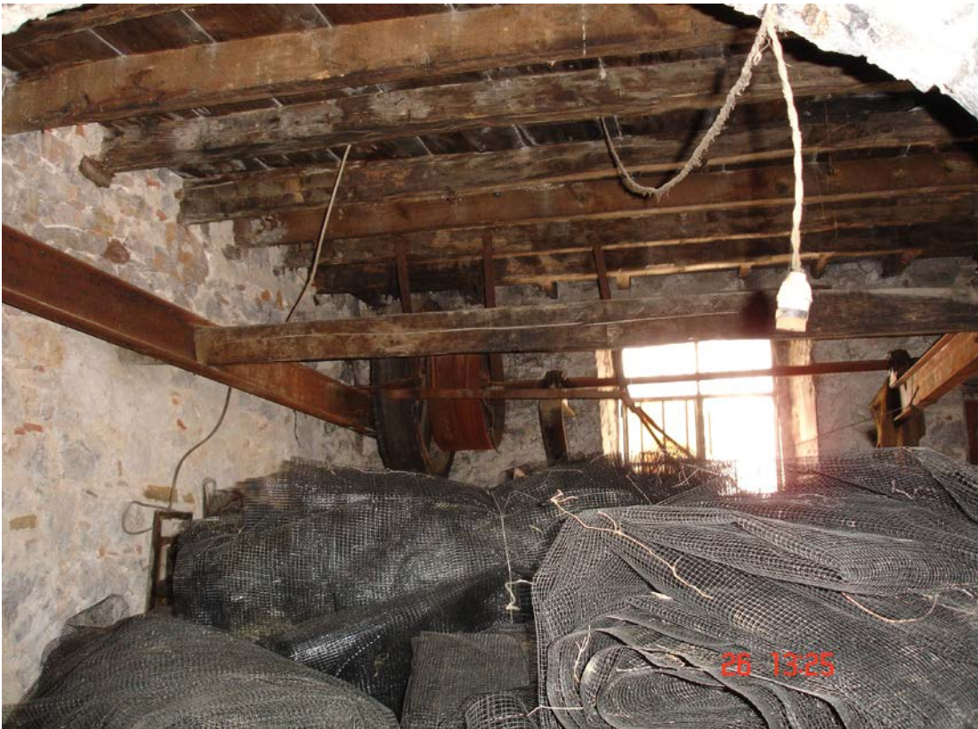
Μεγάλο τμήμα μεσοπατώματος
