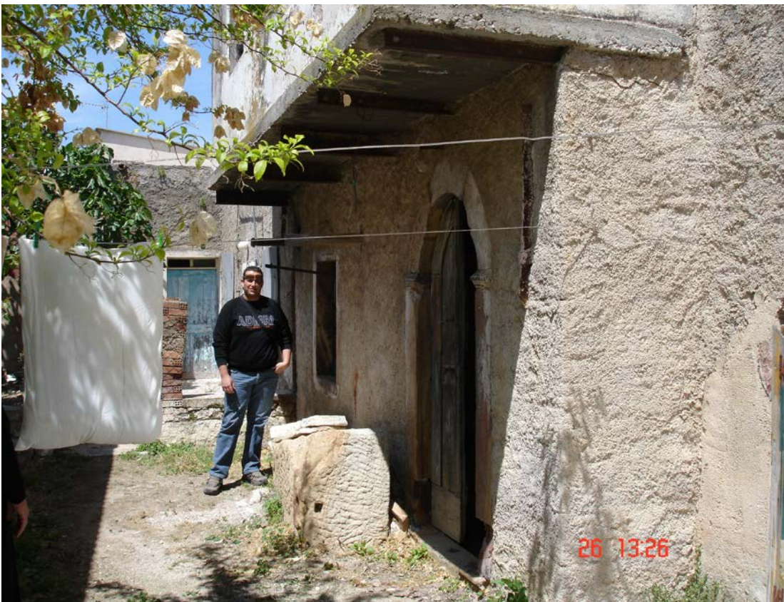
Νότια όψη κτιρίου από άλλη περιμετρική άποψη
