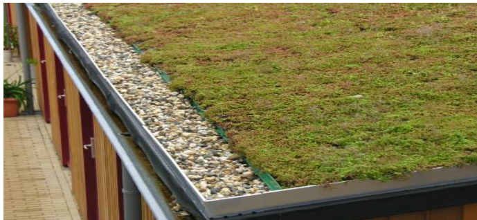
Εικόνα 31 - Τοποθέτηση σκύρων για την καλύτερη απορροή των υδάτων
