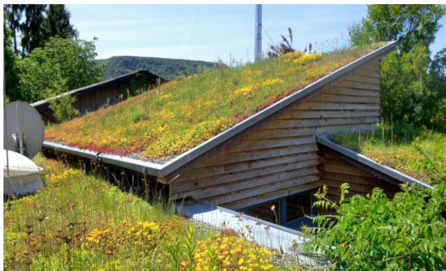
Εικόνα 33 - Φυτεμένο δώμα υπό κλίση Πηγή εικόνας:( https://zinc-greenroof.com )
