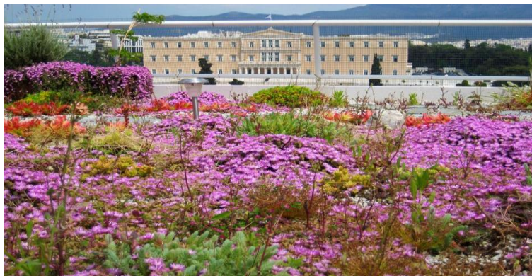
Εικόνα 20 - Φυτεμένο δώμα στο Υπουργείο Οικονομικών Πηγή εικόνων: ( https://www.greenroofs.com )
