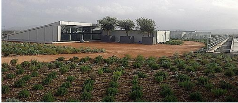
Εικόνα 23 - Το φυτεμένο δώμα στο νέο κτήριο γραφείων Καρελά Πηγή εικόνας:( https://www.egreen.gr )
