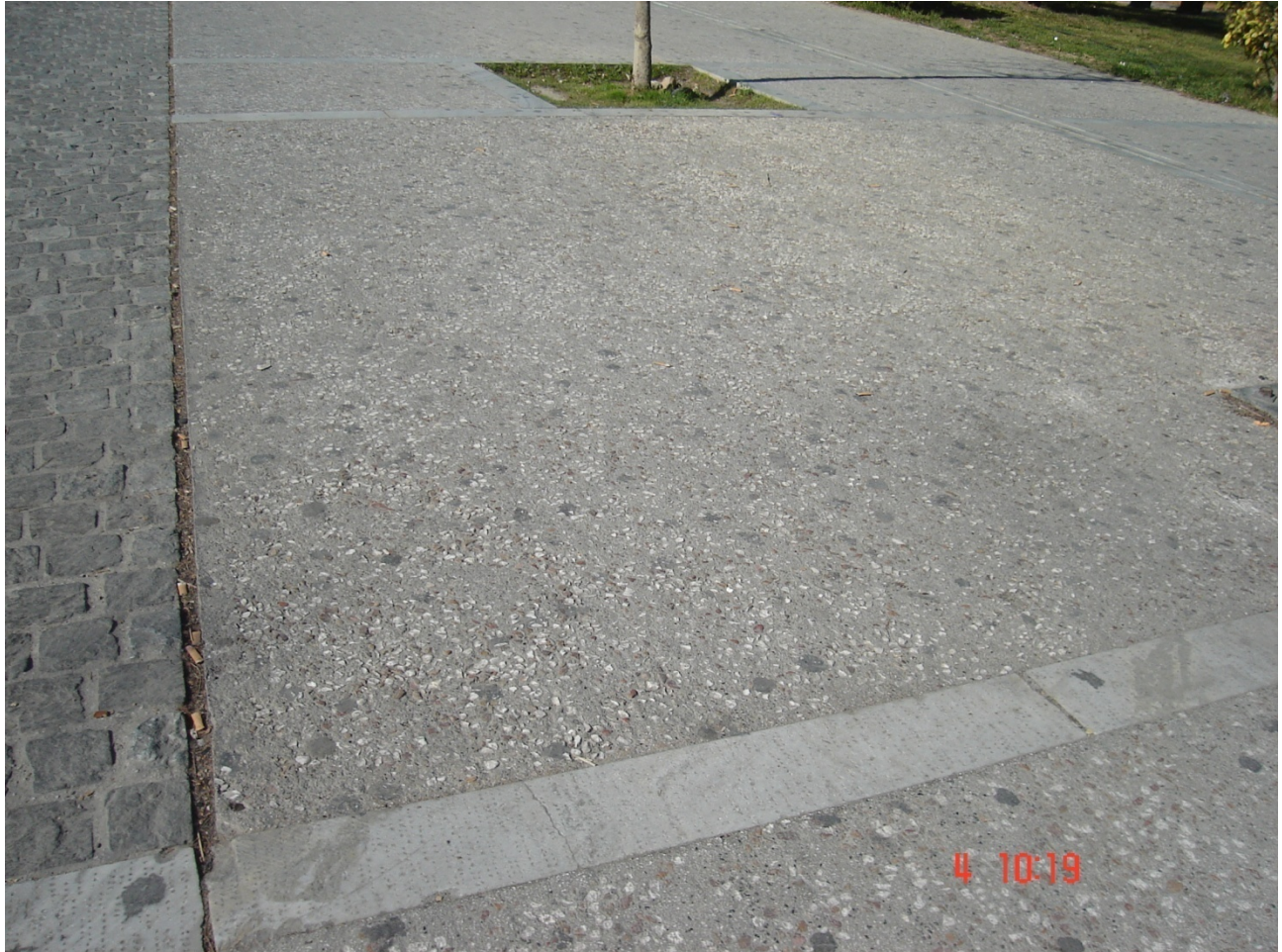
Εικόνα 26 Χυτά βιομηχανικά βοτσαλωτά δάπεδα (κουρασάνι)
