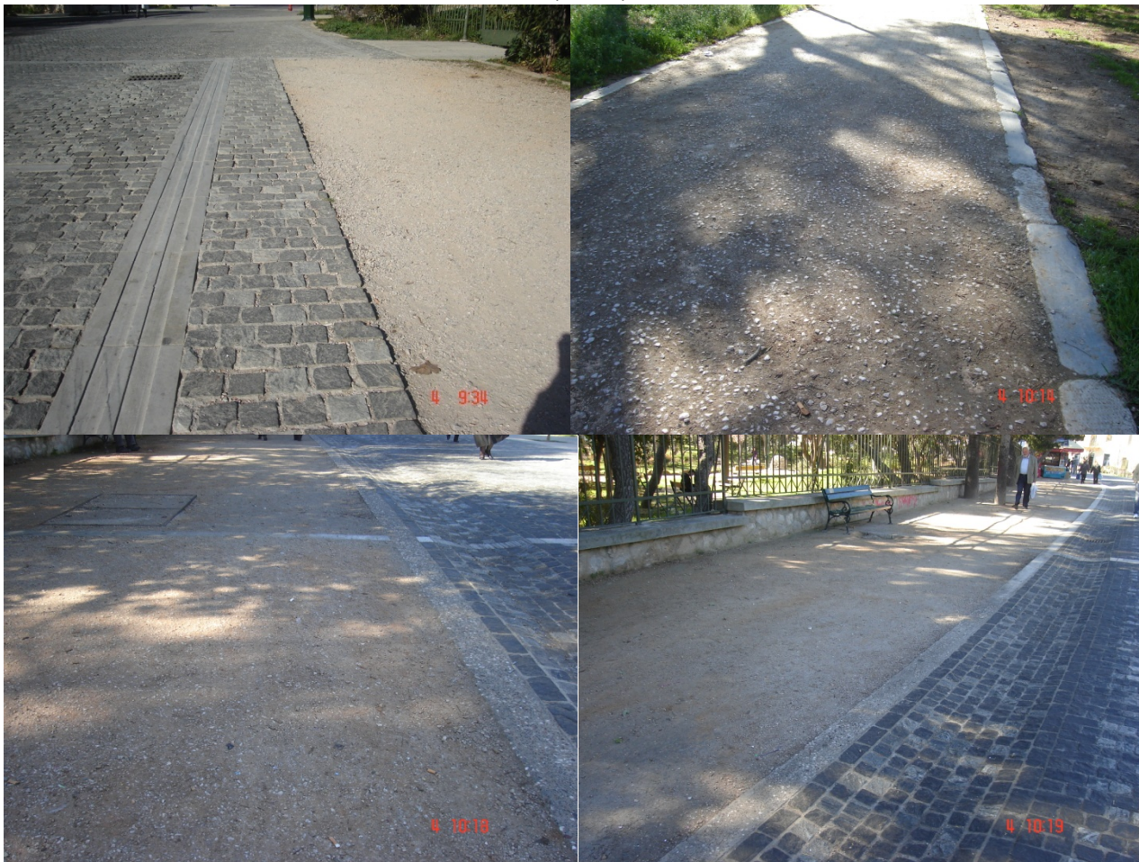
Εικόνα 28 Έτοιμα χωμάτινα σταθεροποιημένα δάπεδα.
