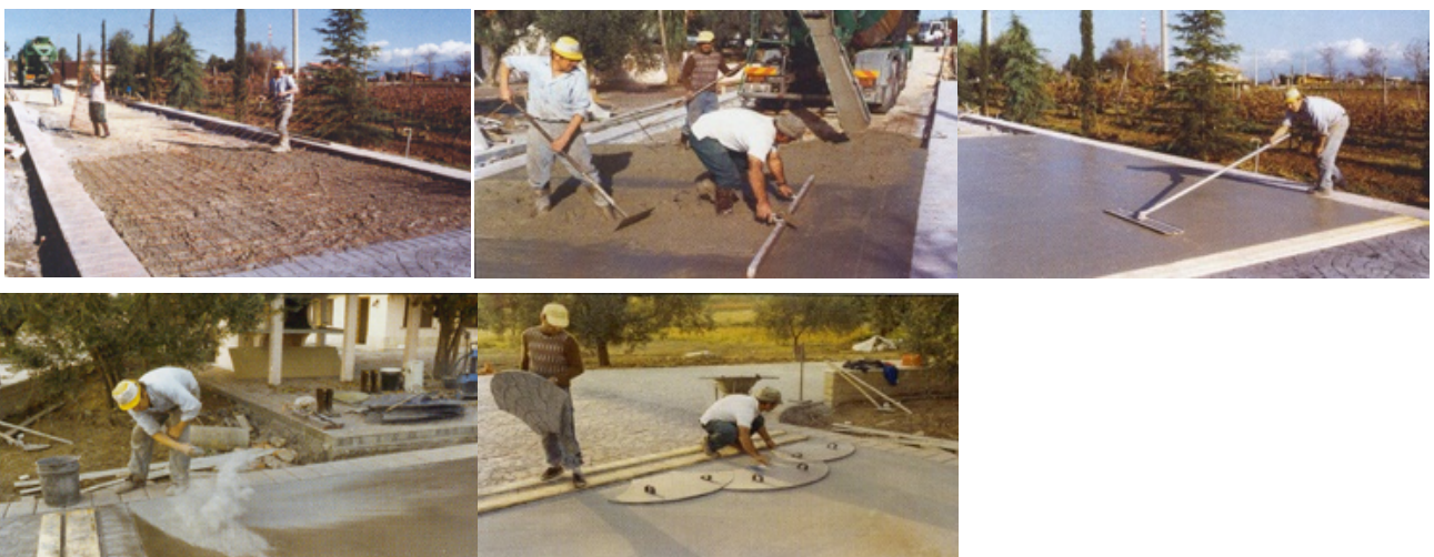
Εικόνα 20 Διαδικασία κατασκευής σταμπωτού δαπέδου
