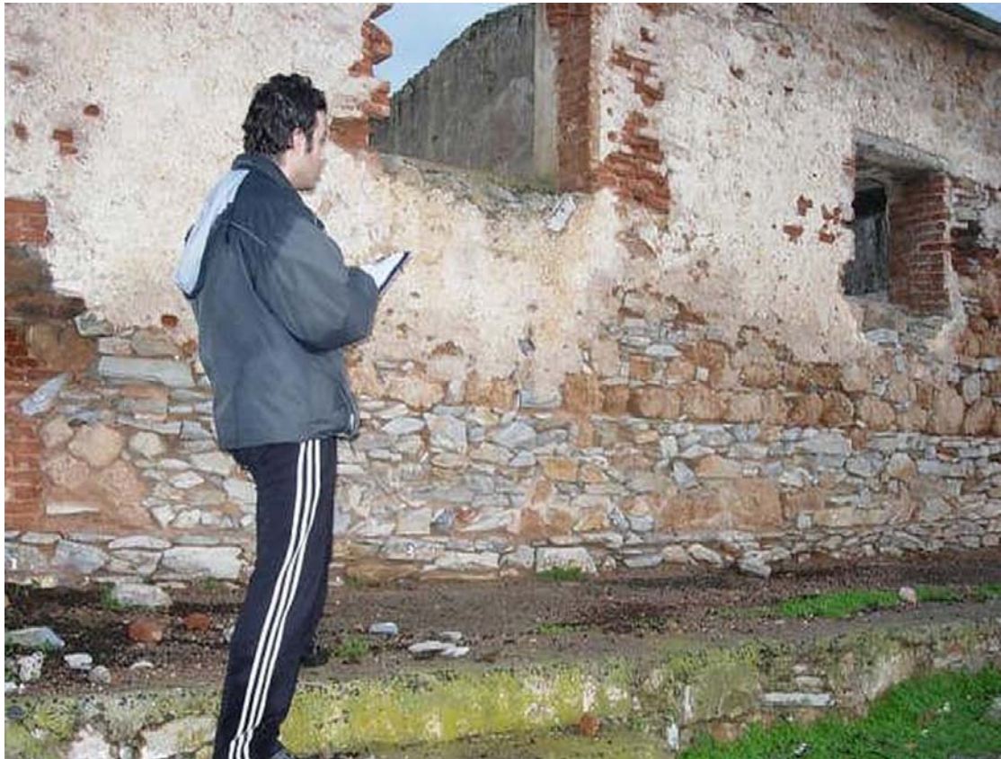
Εικόνα 41 η : Κατασκευή σκαριφημάτων και των τεσσάρων πλευρών του κτιρίου.
