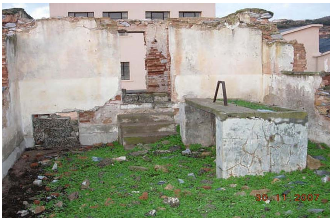
Εικόνα 37 η : Η αριστερή πλευρά στο εσωτερικό του παρασκευαστηρίου στην οποία ανεβαίνεις στο δεύτερο πάτωμα.
