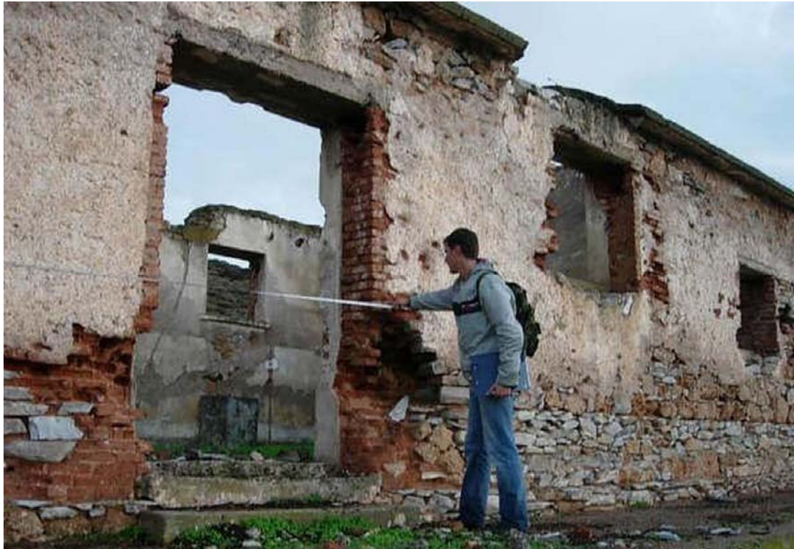
Εικόνα 40 η : Αποτύπωση του κτιρίου. Μετρήσεις διαστάσεων με μετροταινία.
