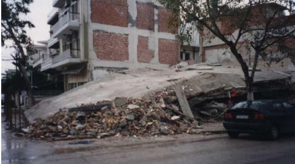
Φωτ. 2.25 Απεικόνιση κατάρρευσης κτίσματος κατοικίας, παλαιάς κατασκευής, στην επίκεντρη περιοχή του Μενιδίου. [ πηγή : ηλεκτρονική σελίδα του Οργανισμού Αντισεισμικού Σχεδιασμού και Προστασίας ]
