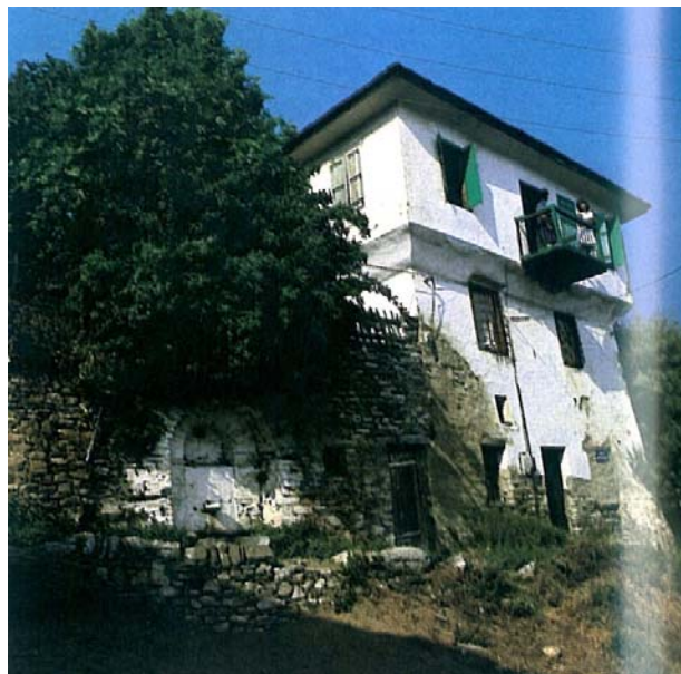
Φωτ.2.3.8 Μακρυνίτσα, Μετατροπή παράθυρου σε πόρτα και προσθήκη εξώστησε παραδοσιακή κατασκευή.
