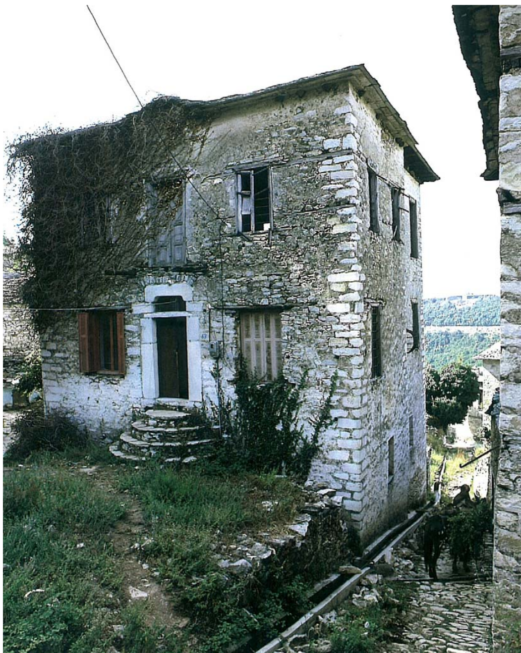
Φωτ.2.3.5 Εξ' ολοκλήρου πέτρινη κατασκευή σπιτιού.
