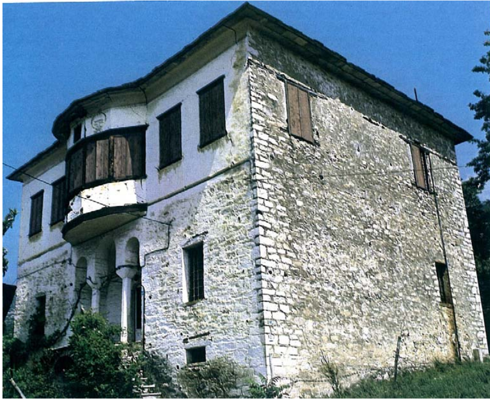
Φωτ.2.3.7 Μηλιές, το αρχοντικό Φιλιππίδη. Συνύπαρξη τρίλοβου τοξωτού προστώου και αξονικού πολυγωνικού σαχνισιού.
