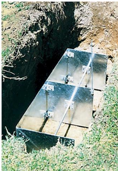
Σχήμα 3.12: Γειωτής Τύπου «Ε» [25]
