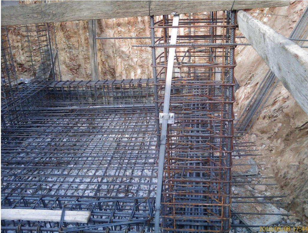
Σχήμα 3.13:Κατασκευή Θεμελιακής Γείωσης [25]
