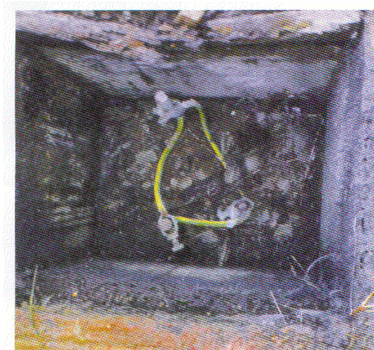
Σχήμα 3.10: Κατασκευή Τριγώνου Γείωσης [15]
