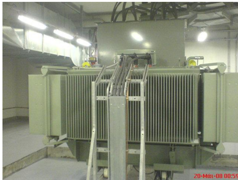
ΜΕΤΑΣΧΗΜΑΤΙΣΤΗΣ Μ.Τ. ΣΤΑΘΜΟΣ ΜΟΝΑΣΤΗΡΑΚΙ
