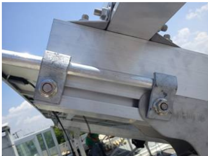
Εικόνα 73 Ειδικός σφιγκτήρας στήριξης της ακίδας
