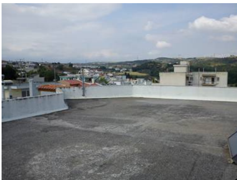
Εικόνα 19 Δυτική όψη δώματος
