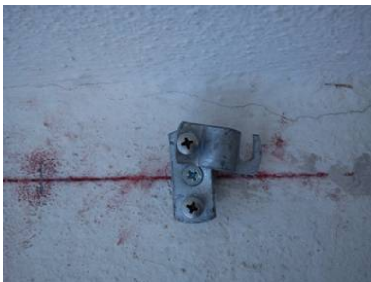
Εικόνα 69 Σύνδεσμος στήριξης αγωγών προστασίας μπετού
