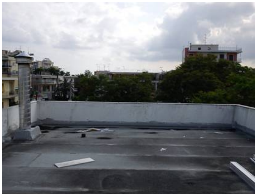
Εικόνα 22 Ανατολική όψη δώματος
