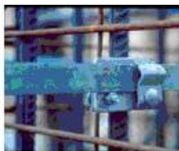
Εικόνα 62 Θεμελιακή γείωση
