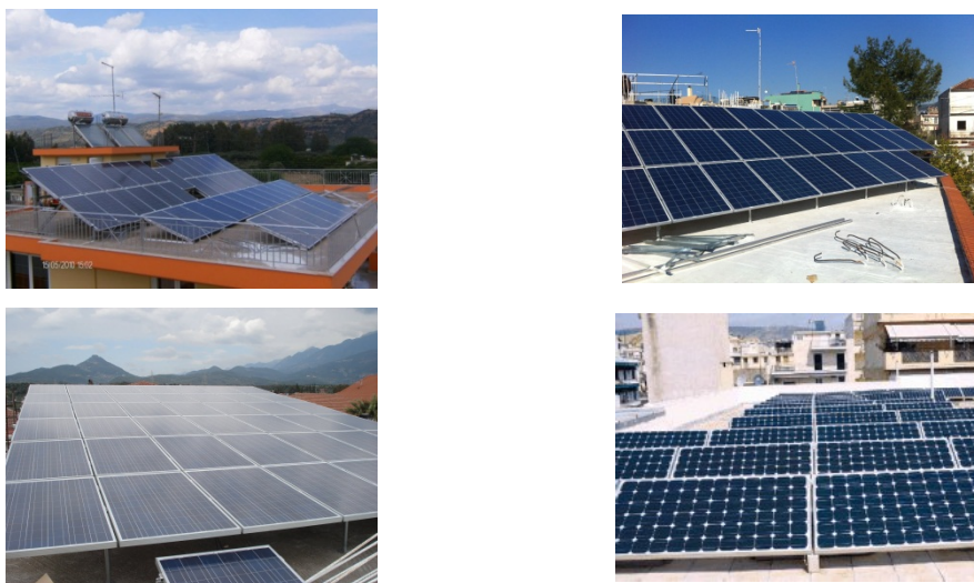
Εικόνα 35 Παραδείγματα βάσεων στήριξης φωτοβολταϊκών πλαισίων
