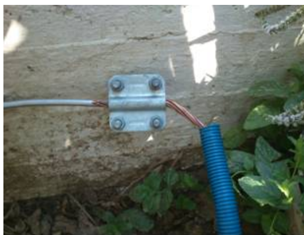
Εικόνα 70 Διμεταλλικός σύνδεσμος για ένωση αγωγού χαλκού με αλουμίνιο.
