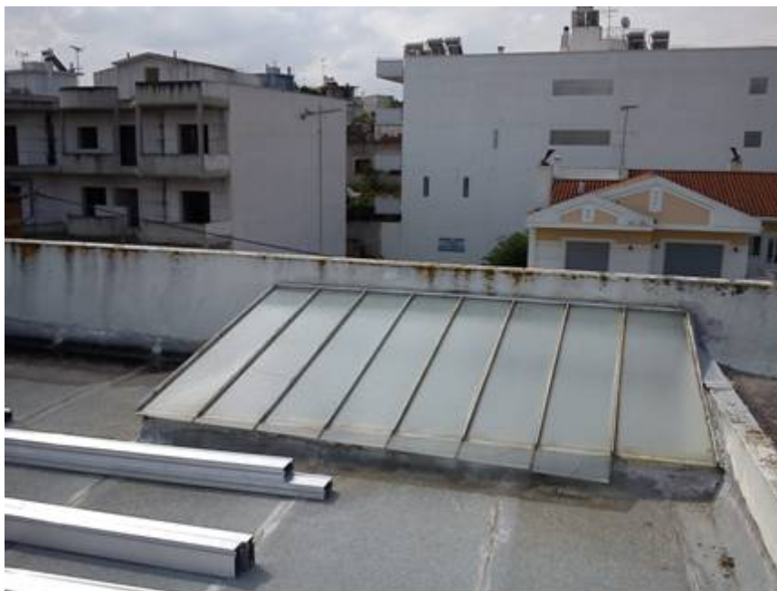
Εικόνα 21 Εμπόδια στην επιφάνεια του δώματος
