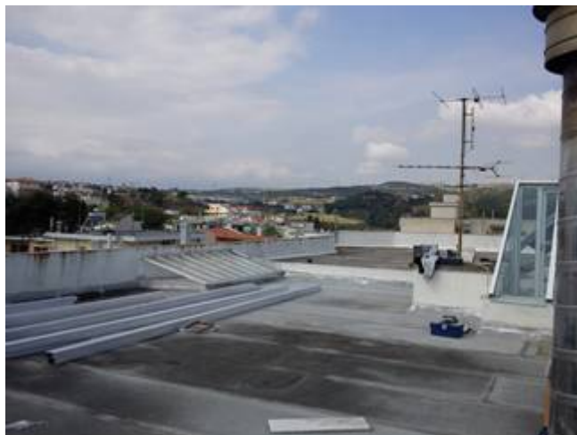
Εικόνα 20 Βόρειο-ανατολική όψη δώματος
