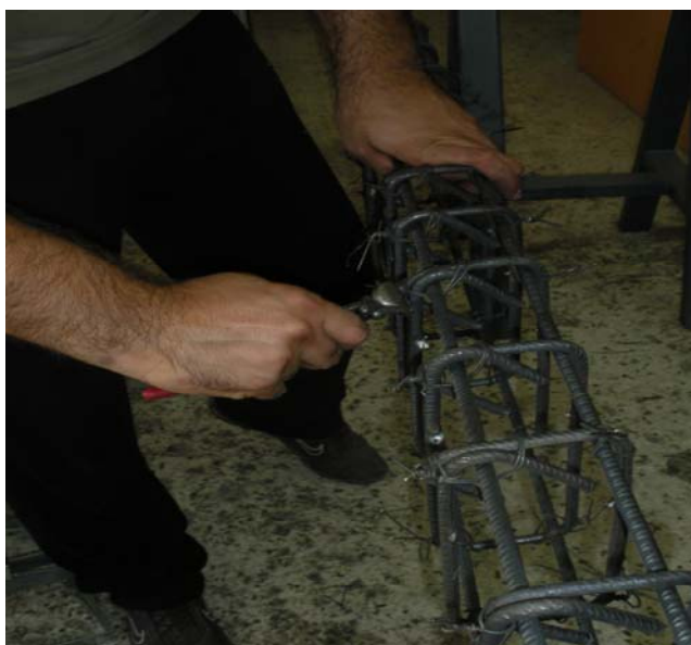
ΕΙΚ.1) Κατασκευή των κλωβών
