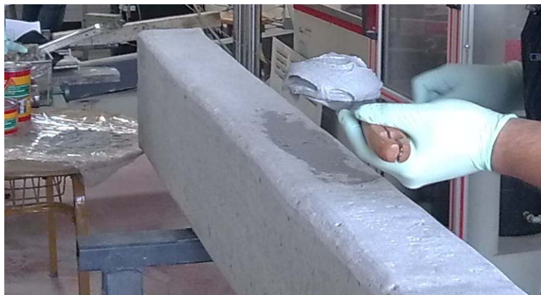
ΕΙΚ.23) Στρογγύλευμα γωνιών-επισκευή ανωμαλιών με εποξειδική πάστα
