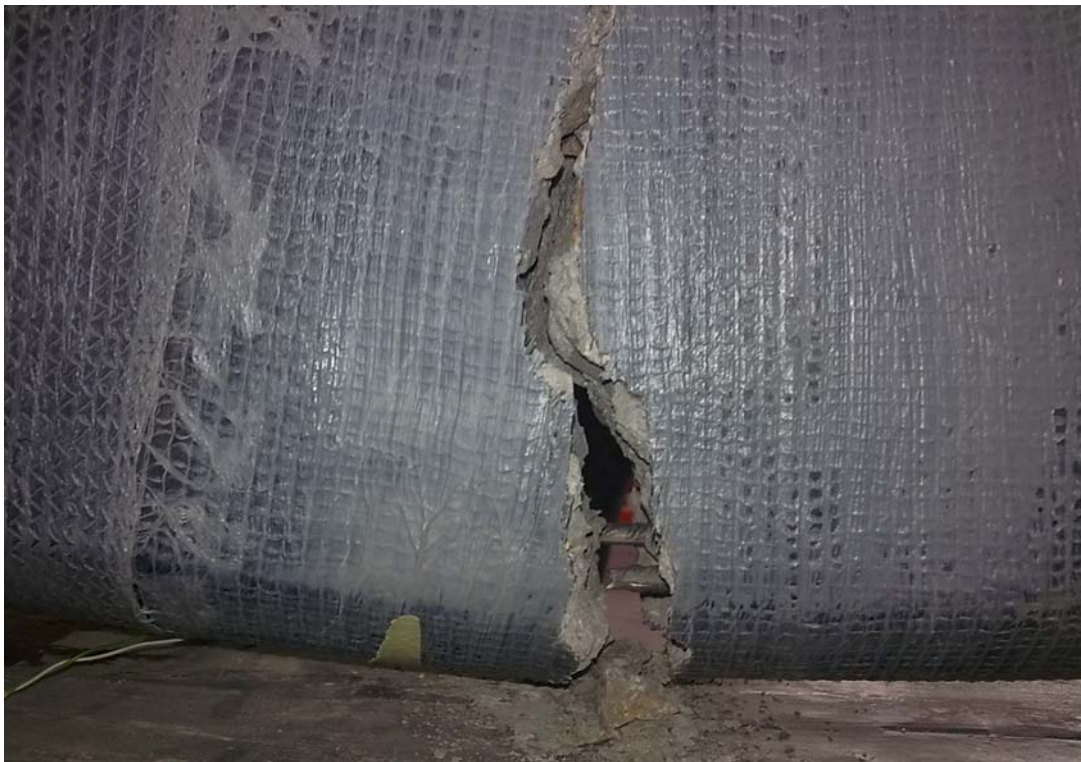
ΕΙΚ.33)Σπάσιμο σιδηρού οπλισμού μετά την αποκοπή του υφάσματος
