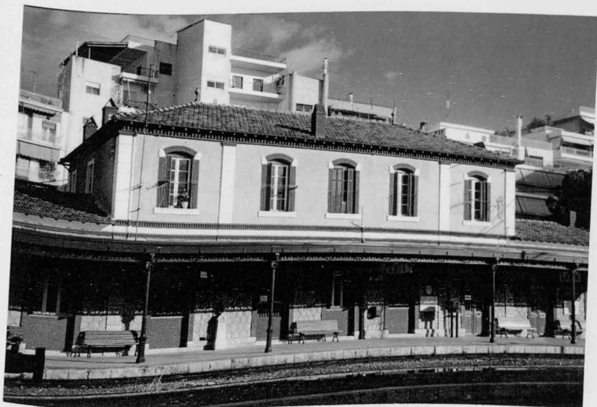
Φωτ. 2) Στη νότια πλευρά του σταθμού βρίσκεται η αποβάθρα
