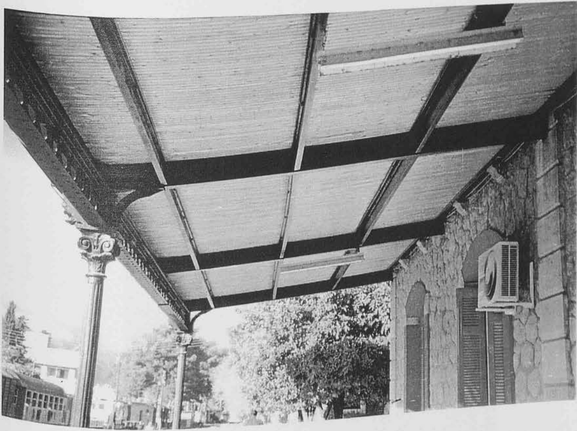
Φωτ. 15, 16) Το στέγαστρο του σταθμού
