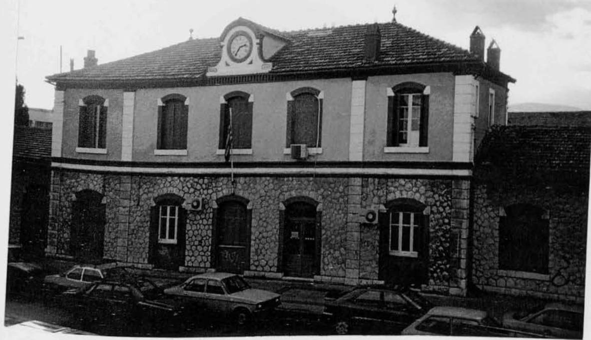
Φωτ. 1) Η πρόσοψη του σταθμού της Λαμίας
