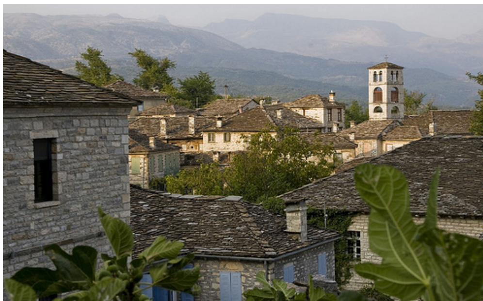
ΦΩΤΟΓΡΑΦΙΑ 23 Στέγες από σχιστολιθικές πλάκες στα Ζαγορίσια σπίτια
