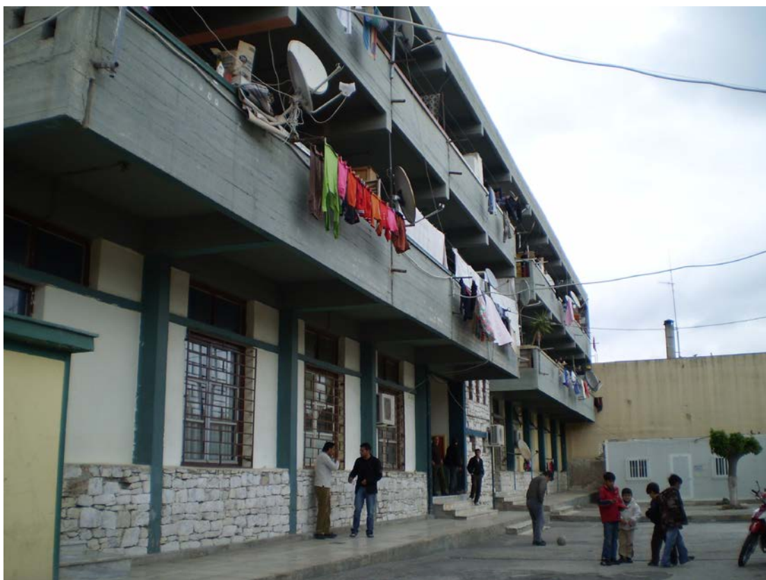
ΦΩΤ: : ΚΤΙΡΙΟ ΦΙΛΟΞΕΝΙΑΣ ΟΙΚΟΝΟΜΙΚΩΝ ΜΕΤΑΝΑΣΤΩΝ
