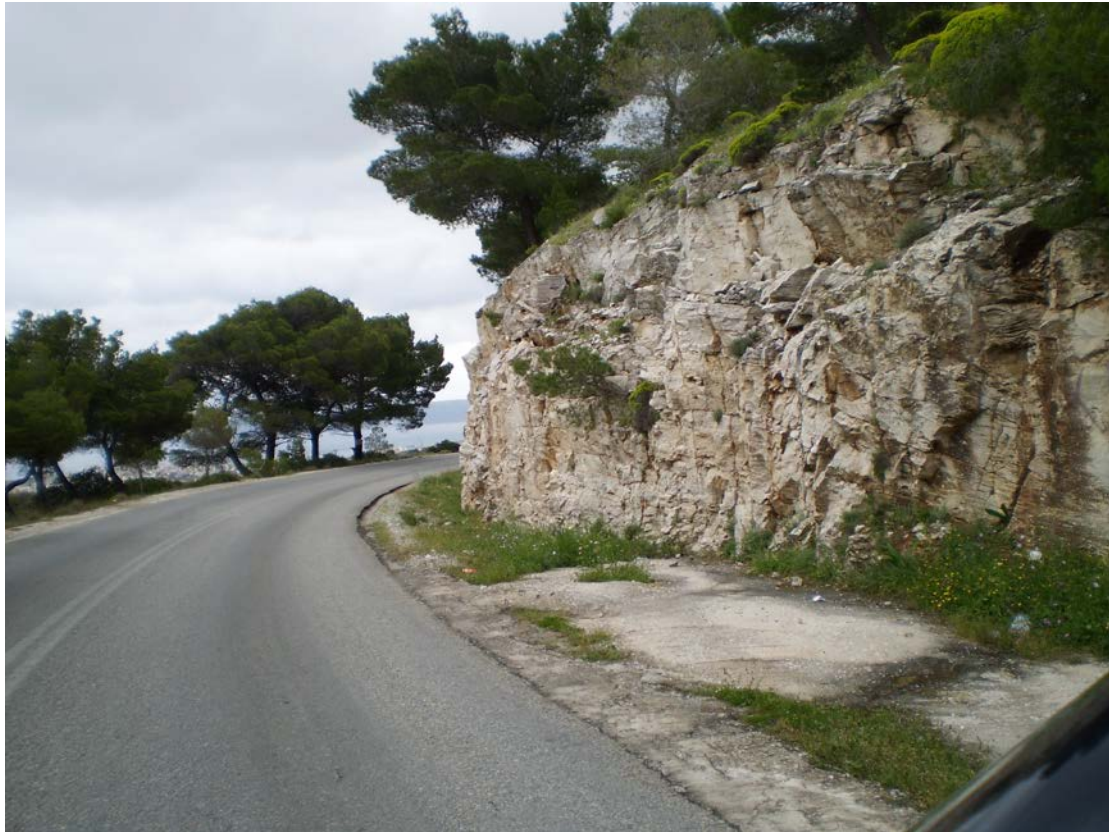
ΦΩΤ: ΔΡΟΜΟΣ ΣΥΝΔΕΣΗΣ ΑΝΑΒΥΣΣΟΥ- ΣΟΥΝΙΟΥ
