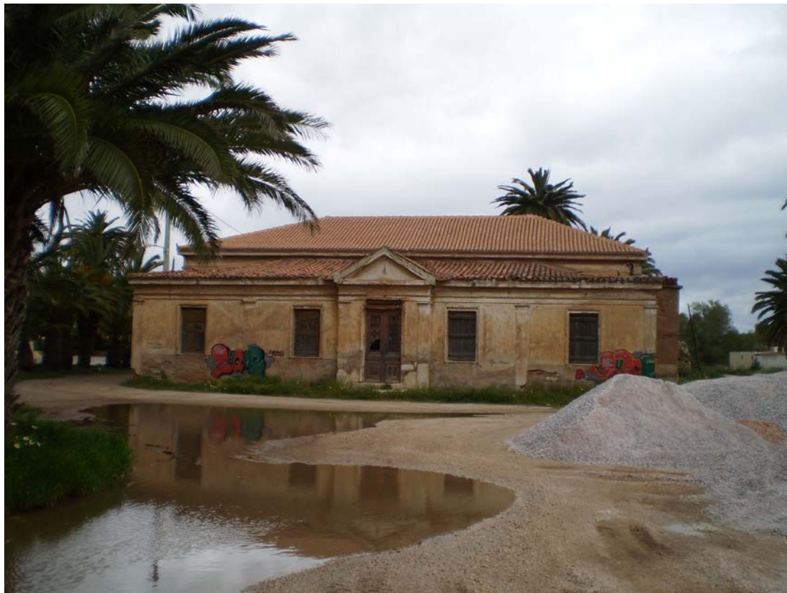
ΦΩΤ: ΑΝΕΚΜΕΤΑΛΛΕΥΤΟ ΝΕΟΚΛΑΣΙΚΟ ΚΤΙΡΙΟ
