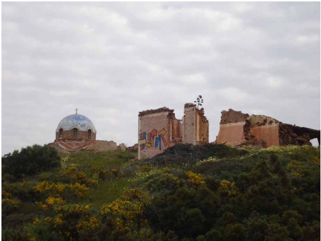
ΦΩΤ: ΒΕΒΗΛΩΜΕΝΟ ΔΙΑΤΗΡΗΤΕΟ ΚΤΙΣΜΑ
