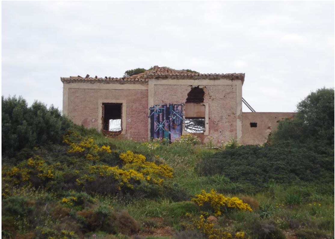
ΦΩΤ: ΒΕΒΗΛΩΜΕΝΟ ΔΙΑΤΗΡΗΤΕΟ ΚΤΙΣΜΑ
