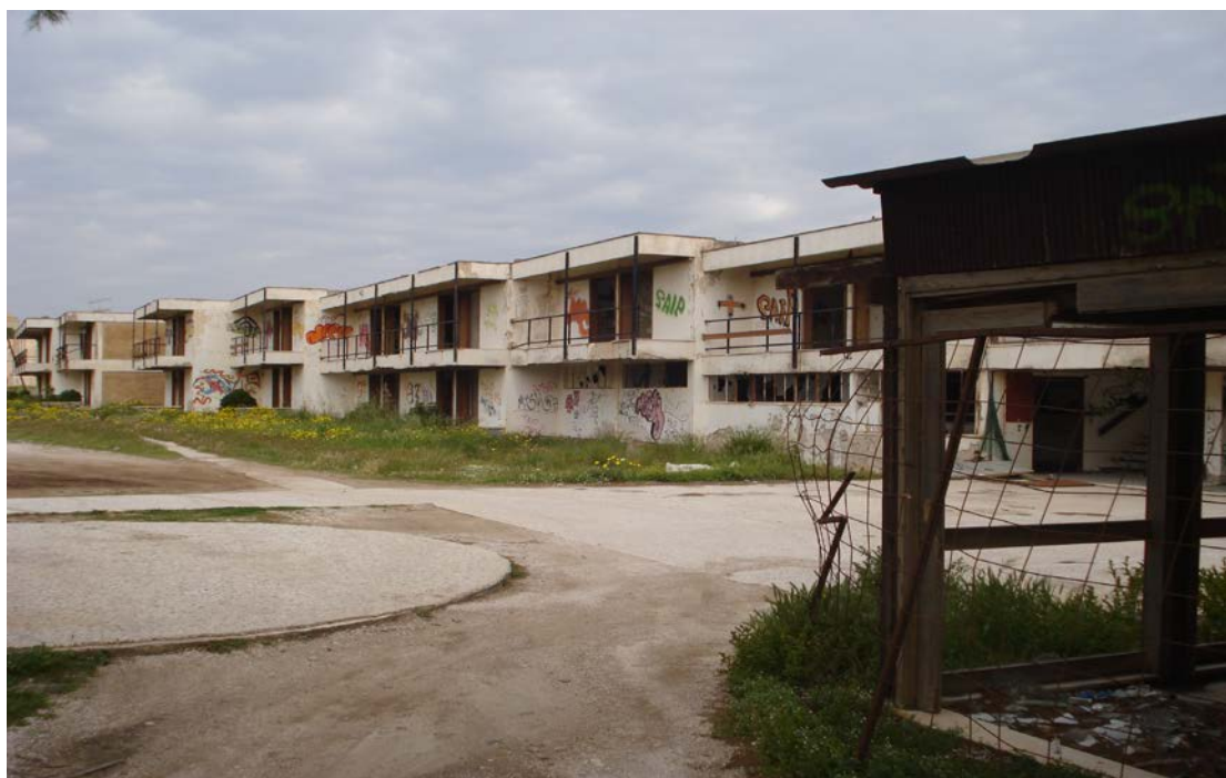
ΦΩΤ: ΑΝΕΚΜΕΤΑΛΛΕΥΤΟ ΚΤΙΡΙΟ
