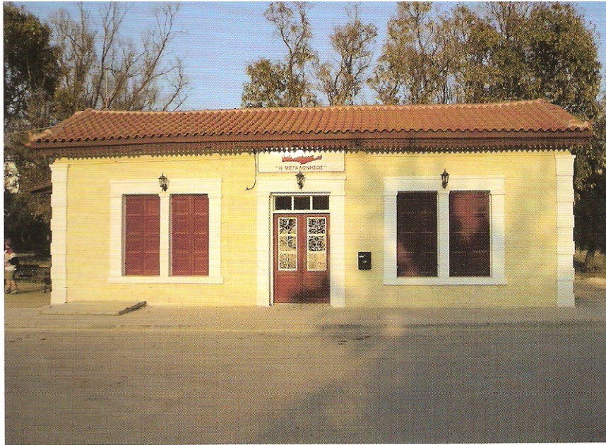
ΦΩΤ: ΚΤΙΡΙΟ ΑΤΤΙΚΟΥ ΣΙΔΗΡΟΔΡΟΜΟΥ
