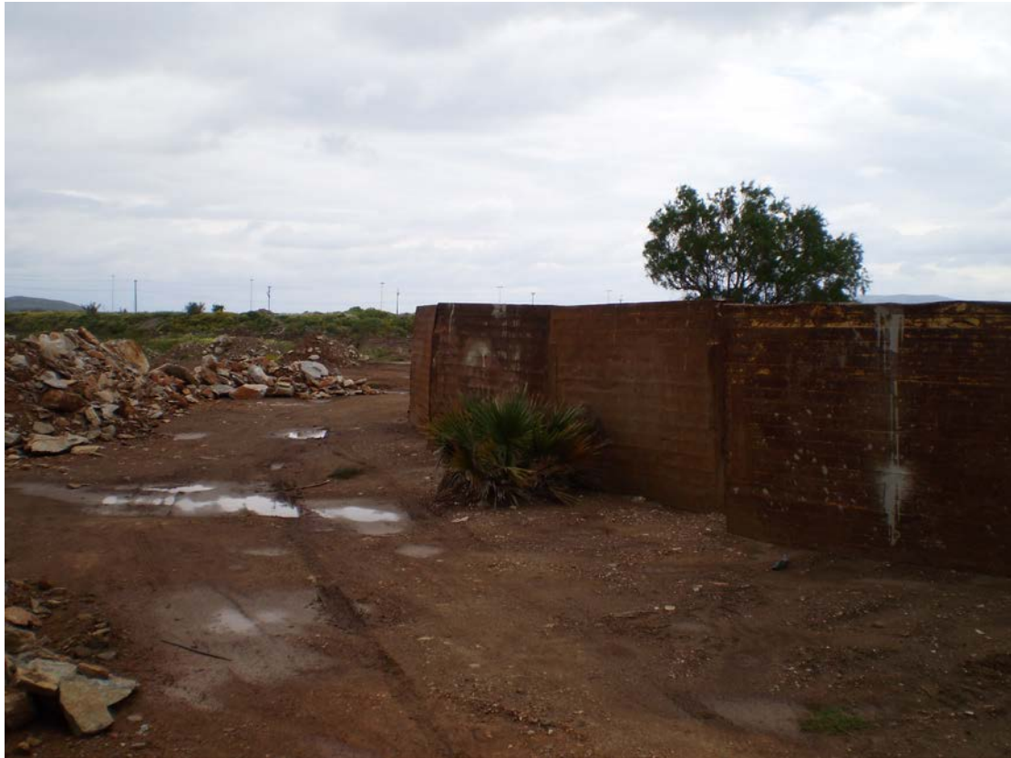
ΦΩΤ: ΑΝΕΚΜΕΤΑΛΛΕΥΤΗ ΔΗΜΟΤΙΚΗ ΕΚΤΑΣΗ
