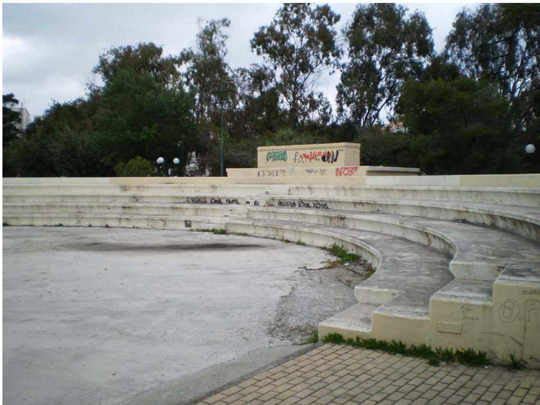
ΦΩΤ: ΘΕΑΤΡΑΚΙ ΠΙΣΩ ΑΠΟ ΚΤΙΡΙΟ ΑΤΤΙΚΟΥ ΣΙΔΗΡΟΔΡΟΜΟΥ
