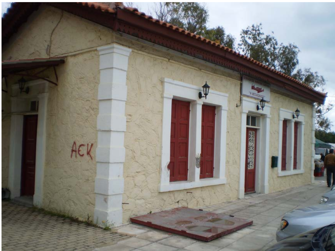
ΦΩΤ: ΚΤΙΡΙΟ ΑΤΤΙΚΟΥ ΣΙΔΗΡΟΔΡΟΜΟΥ
