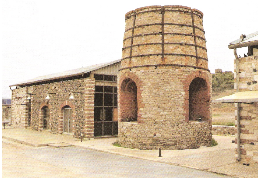
ΦΩΤ: ΚΑΜΙΝΟΣ ΠΥΡΩΣΗΣ
