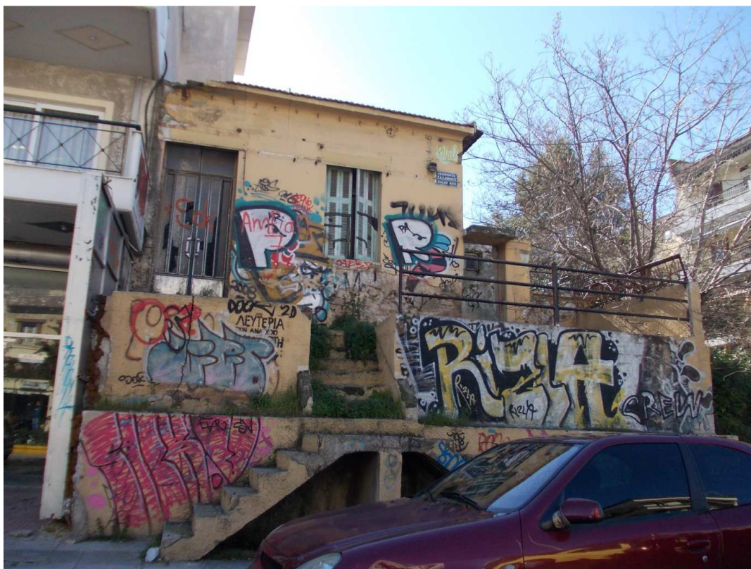
Εικόνα 31 Άποψη ενός εγκαταλελειμμένου κτίσματος στη Δραπετσώνα
