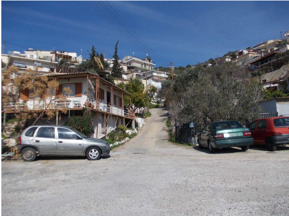
Εικόνα 52 Άποψη αυθαιρεσιών στο Άνω Πέραμα. Οικίες χτισμένες χωρίς πολεοδομικό ή στατικό σχεδιασμό
