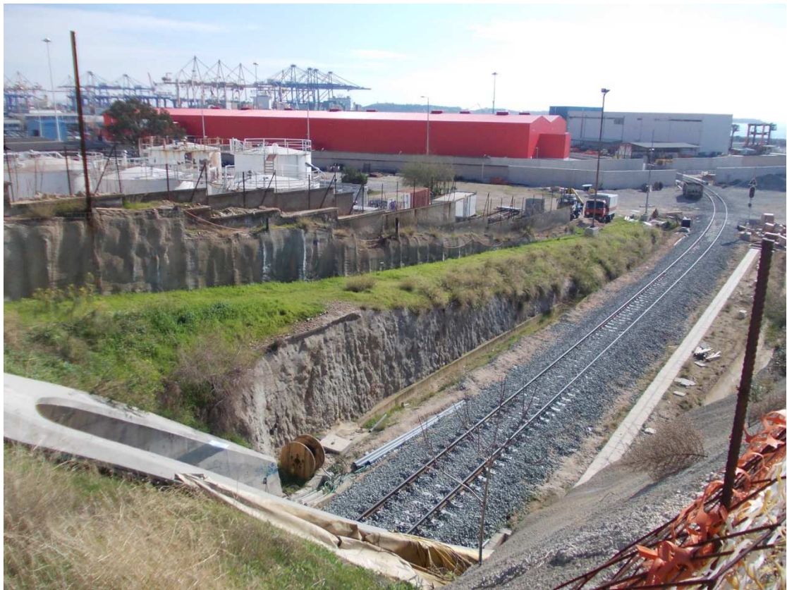
Εικόνα 62 Άποψη του εργοταξίου κατασκευής της νέας σιδηροδρομικής γραμμής Σ.ΕΜΠΟ - Θριάσιο Πεδίο
