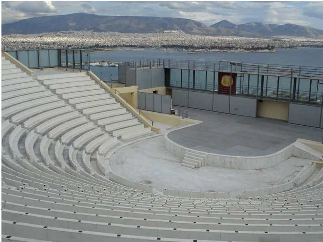
Εικόνα 20 Εσωτερική άποψη του Βεάκειου Θεάτρου (Πηγή: http://el.wikipedia.org )
