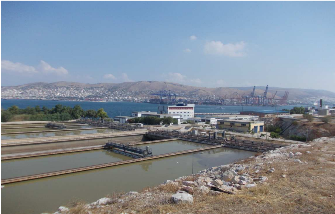
Εικόνα 14 Άποψη των 6 δεξαμενών πρωτοβάθμιας επεξεργασίας
