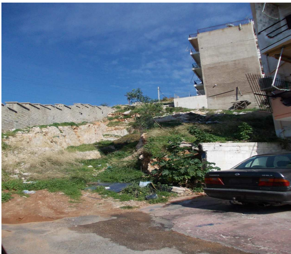
Εικόνα 53 Παραρεμάτια δόμηση στο δυτικό Άνω Πέραμα Εγκαταλελειμμένα Κτίρια
