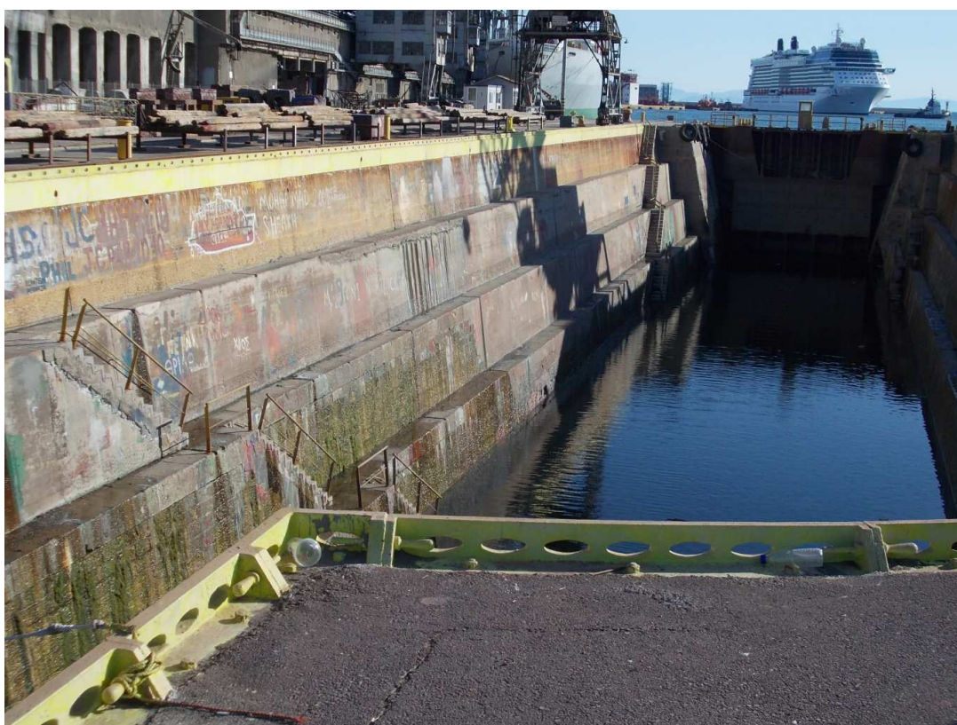
Εικόνα 37 Άποψη της μιας εκ' των δύο δεξαμενών (μικρή)
