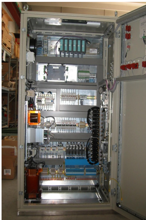
Εικόνα 66. Κεντρικός ηλεκτρολογικός πίνακας.
