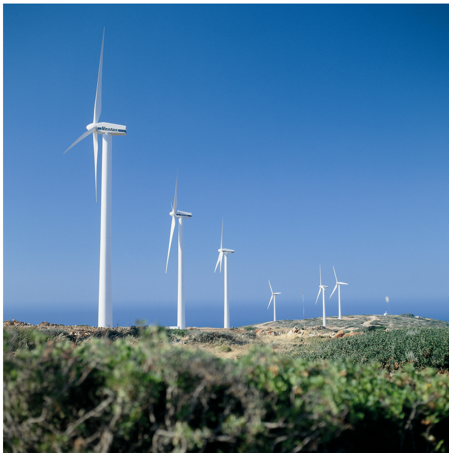
Εικόνα 49: Εγκατάσταση Α/Γ οριζόντιου άξονα της εταιρείας Vestas στην Κρήτη.
