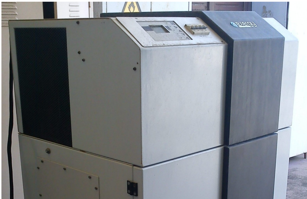
Εικόνα 67. Η κυψέλη καυσίμου μεμβράνης ανταλλαγής πρωτονίων της εταιρείας Exergy στις εγκαταστάσεις του ΚΑΠΕ στο Λαύριο.
