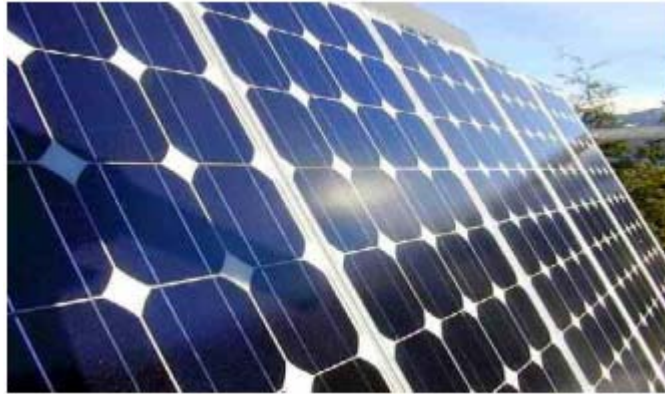
Σχήμα 3.9: Πλαίσια μονοκρυσταλλικού πυριτίου σε λειτουργία
