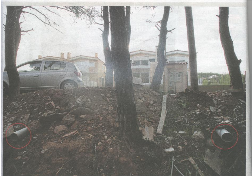
Εικόνα 1. Σωλήνες αποχέτευσης σημειωμένοι με κύκλους καταλήγουν στο ρέμα Βρυσάκι (Άγιος Στέφανος Αττικής) [2].
