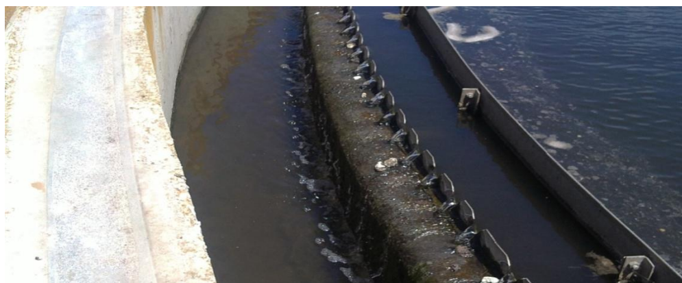
Εικόνα 27. Υπερχείλιση διευγασμένης εκροής από την δεξαμενή δευτεροβάθμιας καθίζησης. Η εσωτερική στεφάνη συγκρατεί τα επιπλέοντα σωματίδια ενώ η εξωτερική οδοντωτή στεφάνη προωθεί την εκροή προς την δεξαμενή χλωρίωσης.
