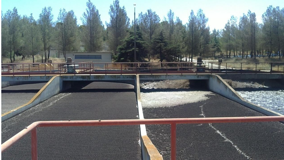
Εικόνα 24. Δεξιά η διάταξη αερισμού ευρίσκεται σε λειτουργία και αερίζει το ανάμικτο υγρό ενώ αριστερά επικρατεί ηρεμία η οποία οφείλεται στην εντολή που έχει δοθεί από τα αισθητήρια διαλυμένου οξυγόνου.
