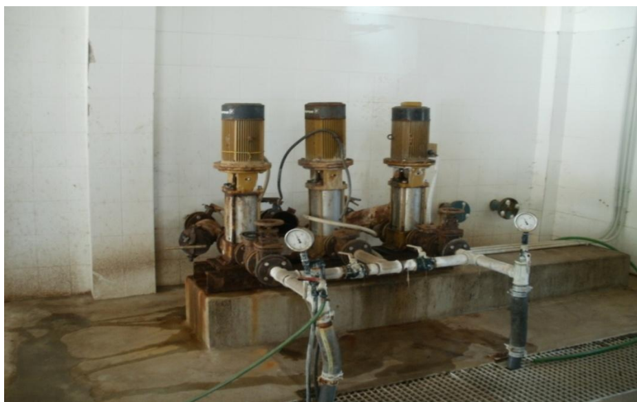
Εικόνα 38. Οι αντλίες πλύσης ταινιοφιλτροπρεσών και τράπεζα παχυντής.
