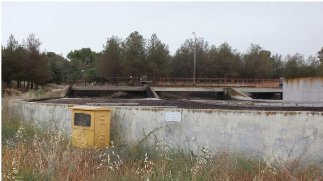
Εικόνα 25. Δεξαμενή αερισμού. Το κίτρινο κυτίο περιέχει τα συστήματα αυτοματισμού καταγραφής ποιοτικών χαρακτηριστικών (Διαλυμένο οξυγόνο, ΡΗ, κλπ.) τα οποίου ρυθμίζουν την λειτουργία των συστημάτων αερισμού και του υπερχειλιστή.
