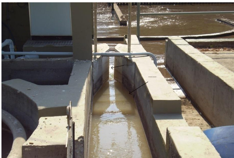
Εικόνα 20. Μέτρηση παροχής των λυμάτων της διάταξης Venturi στο στάδιο εισόδου των λυμάτων στην δεξαμενή αερισμού.
