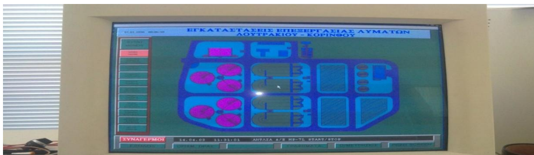
Εικόνα 56. Η/Υ με πρόγραμμα SCADA ελέγχου της εγκατάστασης.
