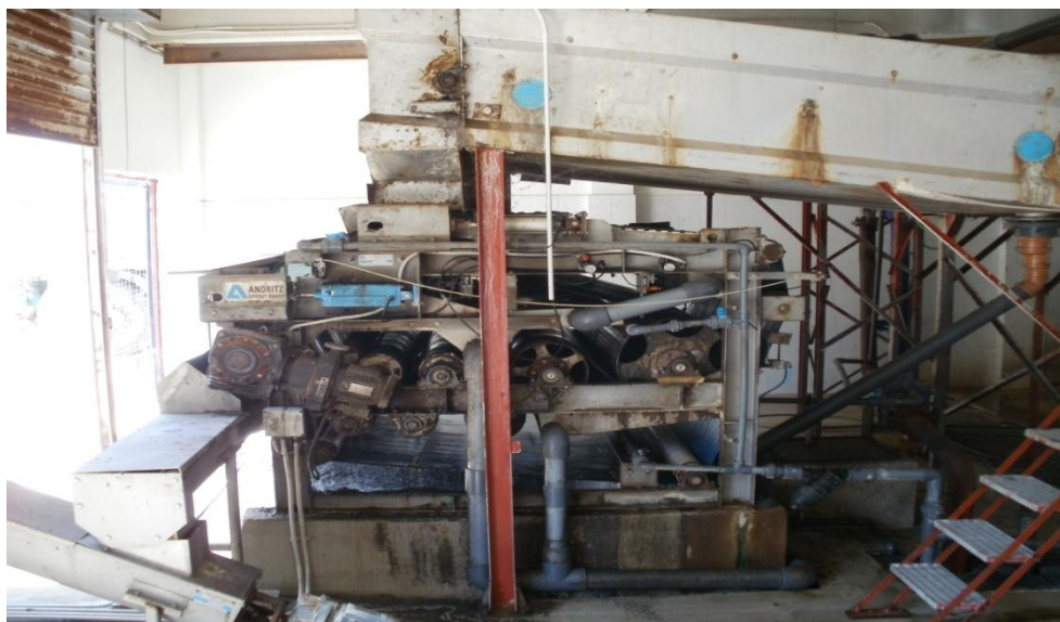
Εικόνα 39. Πρέσα και τράπεζα πάχυνσης. Τελικό στάδιο επεξεργασίας και συμπίκνωσης της ιλύος.
