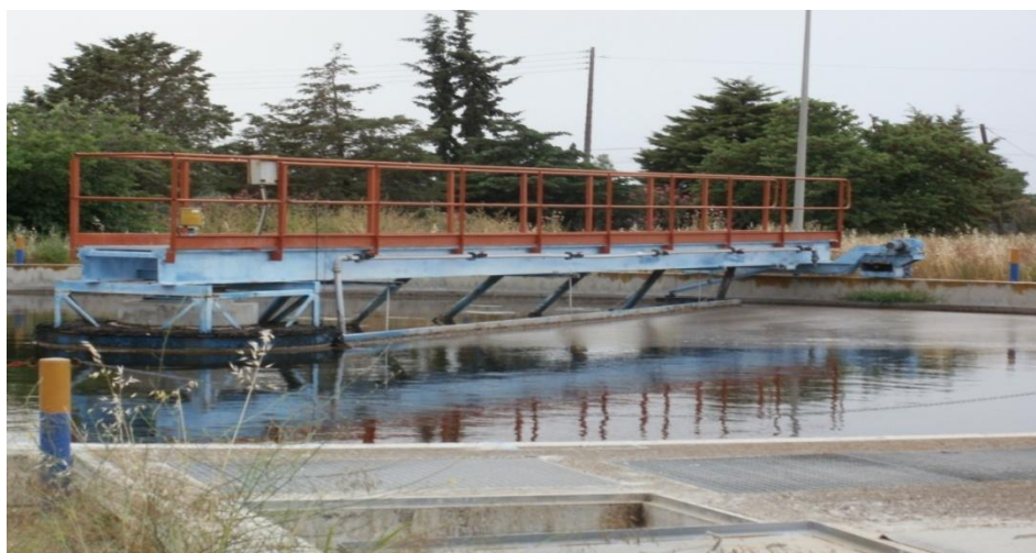
Εικόνα 28. Επιφανειακό ξέστρο καθίζησης. Υπάρχει και το βυθισμένο ξέστρο το οποίο αναμοχλεύει την ίλυ. Κινείται με σταθερή ταχύτητα.
