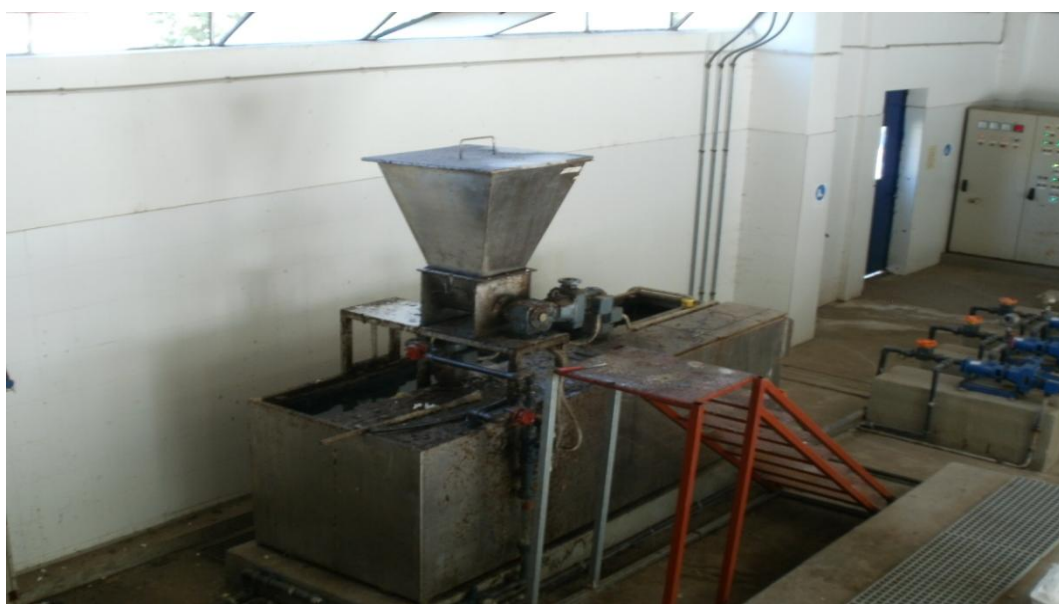
Εικόνα 35. Διάταξη πολυηλεκτρολύτη.
