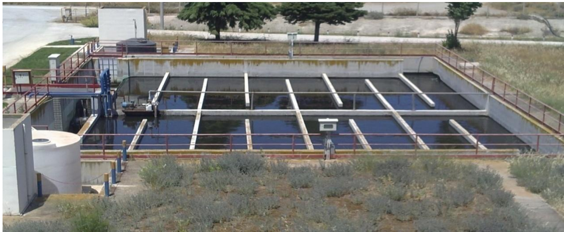
Εικόνα 30. Διάταξη( μαϊανδρος) δεξαμενής χλωρίωσης.
