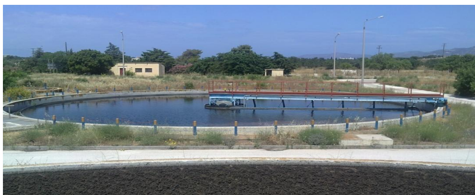
Εικόνα 26. Δεξαμενή δευτεροβάθμιας καθίζησης. Διακρίνεται καθαρά το επιφανειακό ξέστρο το οποίο συσσωματώνει και προσανατολίζει τα επιπλέοντα στερεά.
