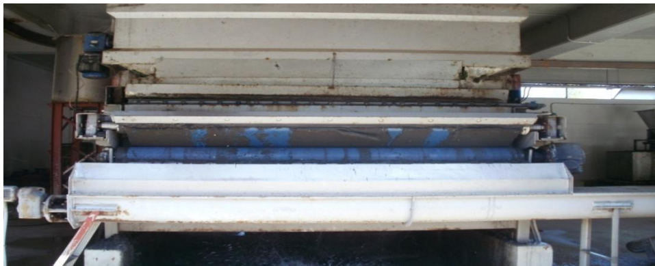
Εικόνα 44. Οριζόντιος κοχλίας αφυδατωμένης ιλύος.
