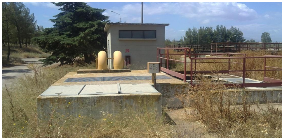
Εικόνα 51. Η δεξαμενή περίσσειας διοχετεύει την περισσευούμενη ίλυ στην δεξαμενή πάχυνσης
