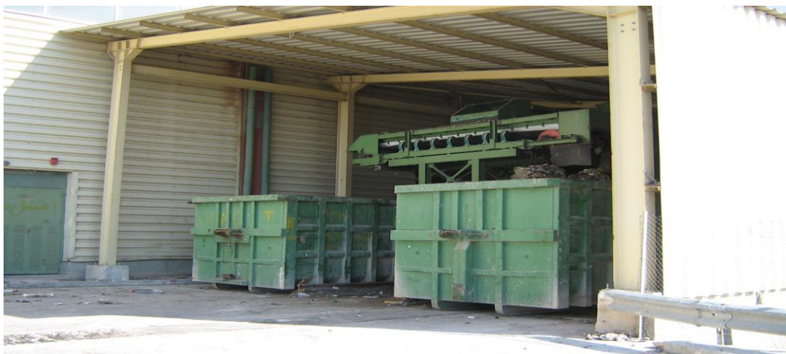
Εικόνα 28: Κάδοι προσωρινής αποθήκευσης λεπτόκοκκων αχρήστων.
