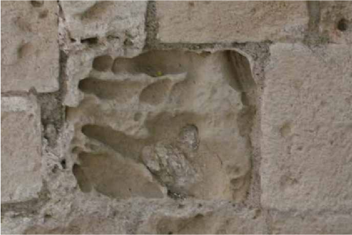
Εικόνα 99: Διάβρωση λίθου στο εξωτερικό μέρος του δυτικού τείχους του κάστρου της Λεμεσού που οφείλεται κυρίως στην εναλλαγή στις περιβαλλοντικές συνθήκες στο πέρασμα των χρόνων
