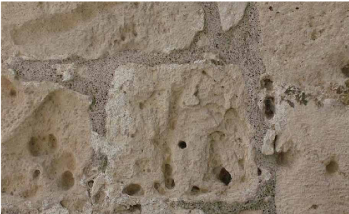
Εικόνα 107: Εμποτισμός με ενέματα σε λίθους στην δυτική εξωτερική πλευρά του τείχους του κάστρου της Λεμεσού. (Προσωπική λήψη 19/3/09)
