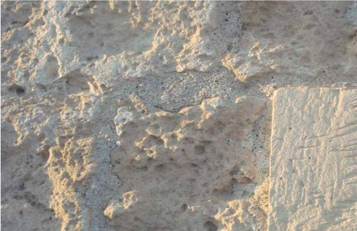
Εικόνα 101: Διάβρωση λίθων σε μέρος του νοτίου εξωτερικού τείχους του κάστρου της Λάρνακας λόγω της επίδρασης στους λίθους διαλυτών αλάτων που προέρχονται από την θάλασσα με την οποία γειτνιάζει το κάστρο. (Προσωπική λήψη 20/3/09).
