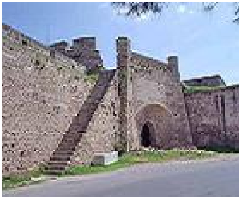
Εικόνα 62: Εσωτερική μεριά της πόρτας της θάλασσας.(Φωτογραφία από Google.gr)
