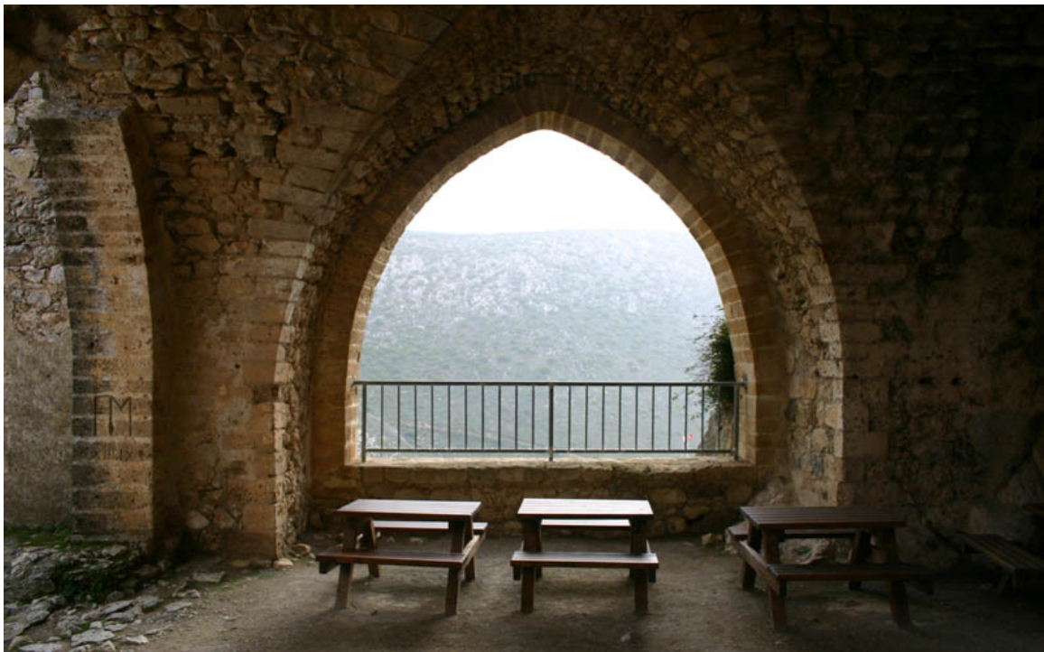
Εικόνα 22: Εσωτερική άποψη του belvedere (κτήριο με ωραία θέα). (Φωτογραφικό αρχείο Ζάκ Ιακωβίδη).
