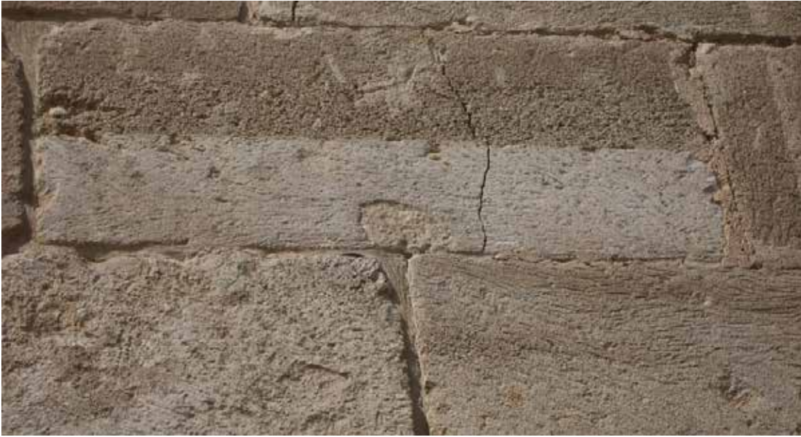
Εικόνα 97: Μικρορογμές σε λίθο στην πρόσοψη του κάστρου του Κολοσσίου που πιθανόν να προέρχεται στην παρουσία μαλακών και σκληρών τμημάτων στο εσωτερικό του λίθου. (Προσωπική λήψη 22/3/09).
