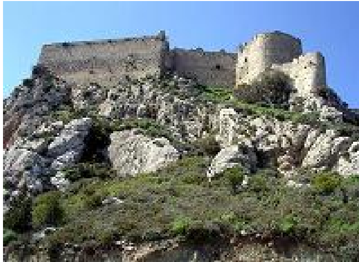
Εικόνα 15: Μέρος του Ανατολικού εξωτερικού τείχους που σώζεται σήμερα. (Φωτογραφικό αρχείο Ζάκ Ιακωβίδη).
