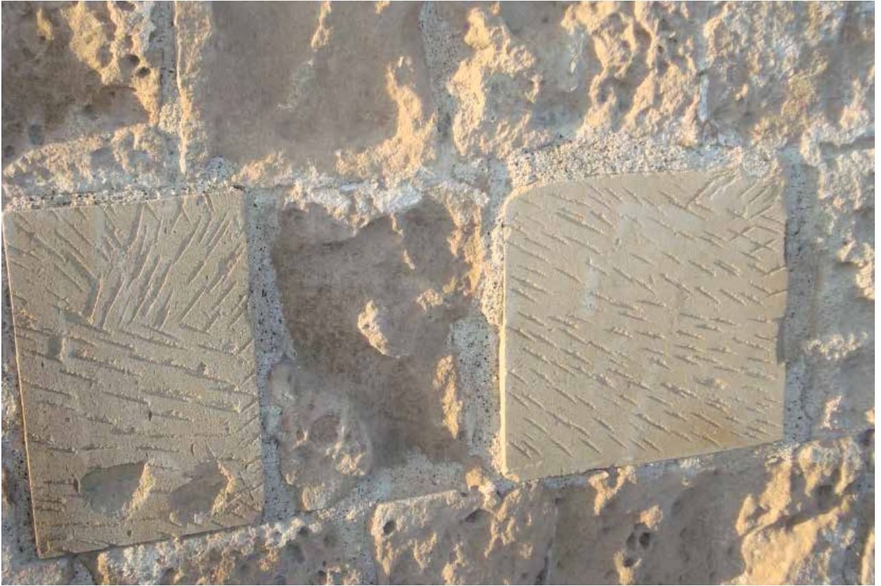
Εικόνα 103: Επανακτίσιμο κατεστραμμένων λόγω φθοράς από το πέρασμα των χρόνων λίθων και εφαρμογή νέων κονιαμάτων για οριζοντίωση και ενίσχυση του τείχους-Ανατολική εξωτερική πλευρά τείχους κάστρου Λάρνακας. (Προσωπική λήψη 20/3/09)
