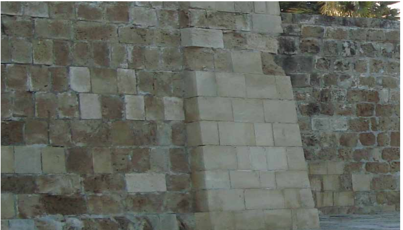
Εικόνα 104: Ενίσχυση της εξωτερικής πλευράς του ανατολικού τείχους του κάστρου της Λάρνακας. (Προσωπική λήψη 20/3/09).
