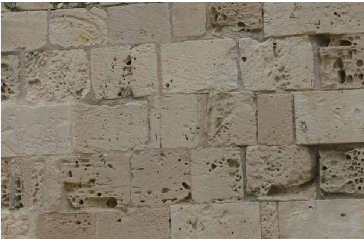
Εικόνα 108: Αντικατάσταση κατεστραμμένων λίθων και εφαρμογή νέων κονιαμάτων σε μέρος του δυτικού τείχους του κάστρου της Λεμεσού. (Προσωπική λήψη 19/3/09).
