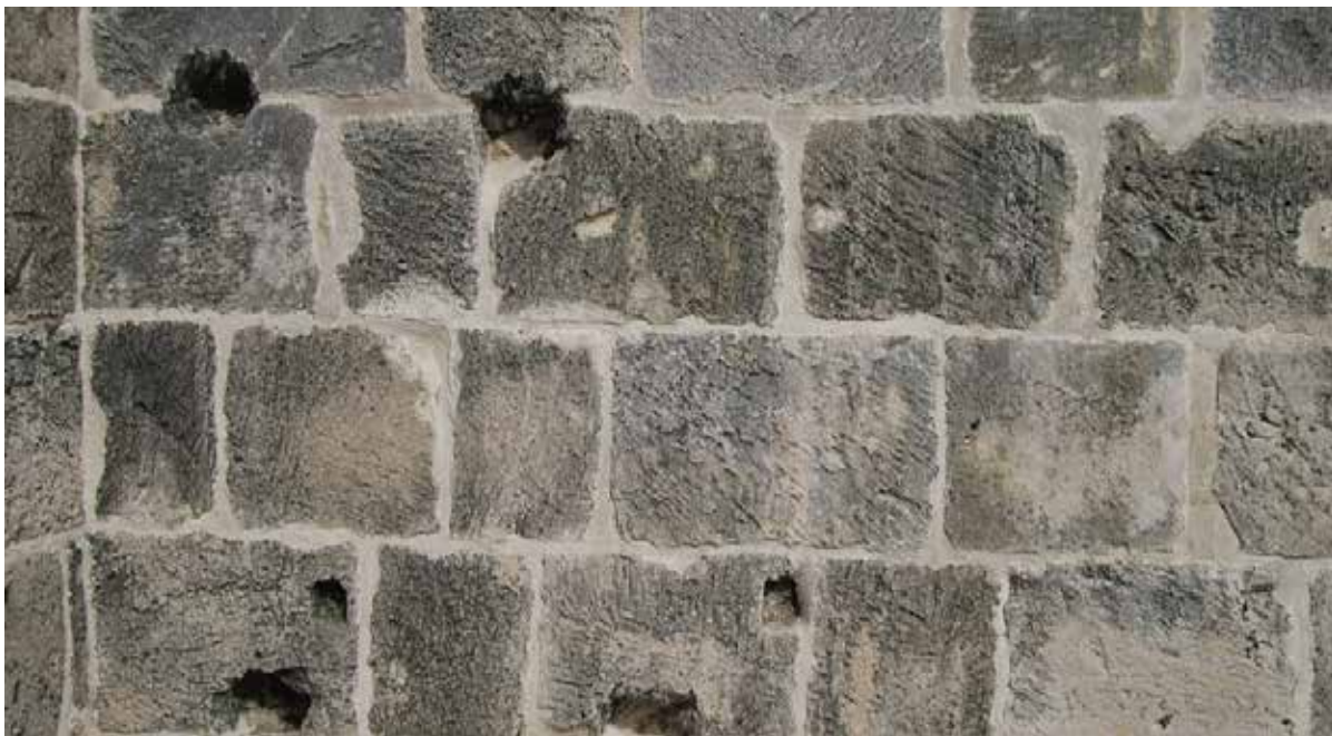
Εικόνα 109: Εφαρμογή νέων κονιαμάτων συγκόλλησης σε μέρος του τείχους στην εσωτερική πλευρά της οροφής του κάστρου του Κολοσσίου. (Προσωπική λήψη 22/3/09).
