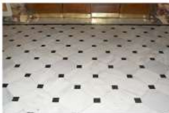
Εικόνα 46. Το δάπεδο στη κύρια είσοδο
