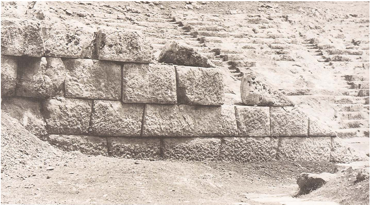
Εικ. 16 : Αναλημματικός τοίχος στο ΝΔ άκρο του κοίλου. Άποψη από τα Νότια.
