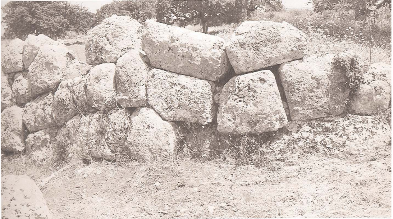
Εικ. 15 : Αναλημματικός τοίχος πολυγωνικής λιθοδομής στο ΝΑ άνω άκρο του κοίλου από τα ΝΑ
