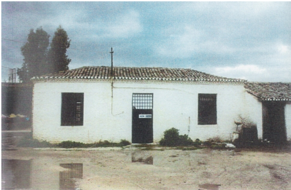
Εσωτερική όψη κτίσματος συνοδείας στην περίμετρο του οικοπέδου, κτιριακή ενότητα 3 (Νότια όψη)
