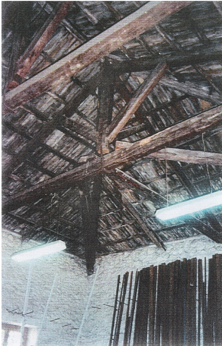
Λεπτομέρεια ξύλινων ζευκτών, απόσπασμα τετράριχτης στέγης, κτιριακή ενότητα 1
