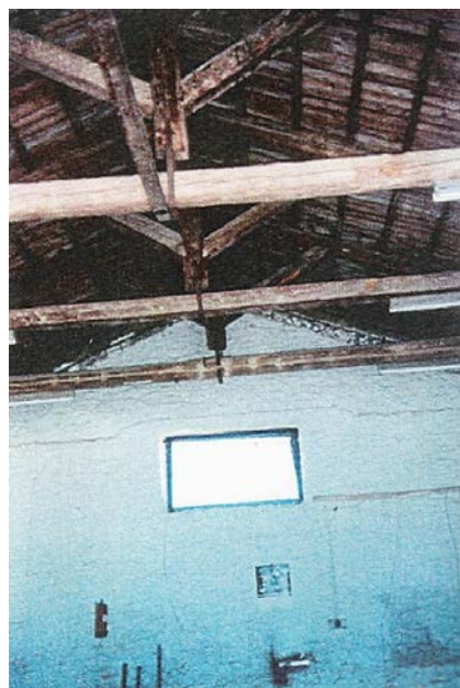
Λεπτομέρεια ξύλινων ζευκτών, απόσπασμα δίριχτης στέγης, κτιριακή ενότητα 1&2 αντίστοιχα
