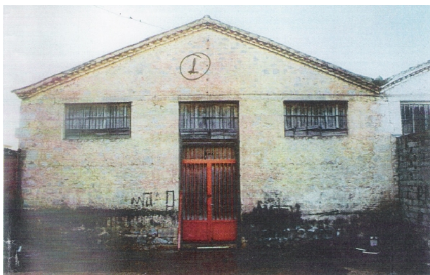
Αδρή υφή λιθοδομής και λιτή οργάνωση ανοιγμάτων, χαρακτηριστική όψη κτιριακής ενότητας 2 (εδώ Ανατολική όψη αριστερού τμήματος)
