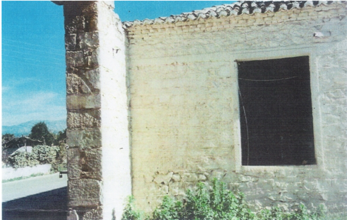
Τυπική λεπτομέρεια λιθοδομής, κτιριακή ενότητα 3 (Δυτική όψη κτιρίου)
