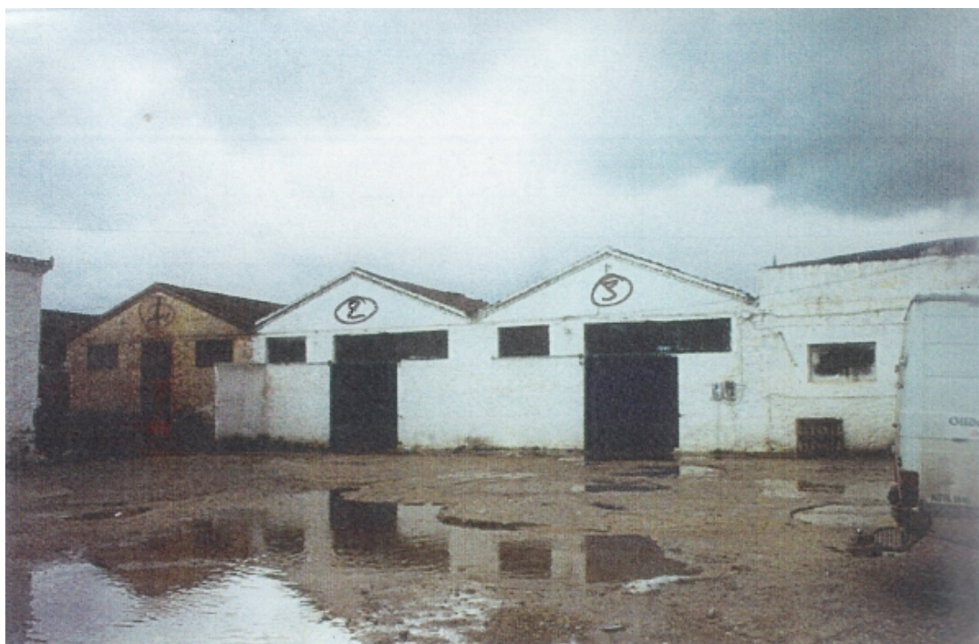
Άποψη των τριών εν σειρά κτισμάτων, κτιριακή ενότητα 2 (Ανατολική όψη)
