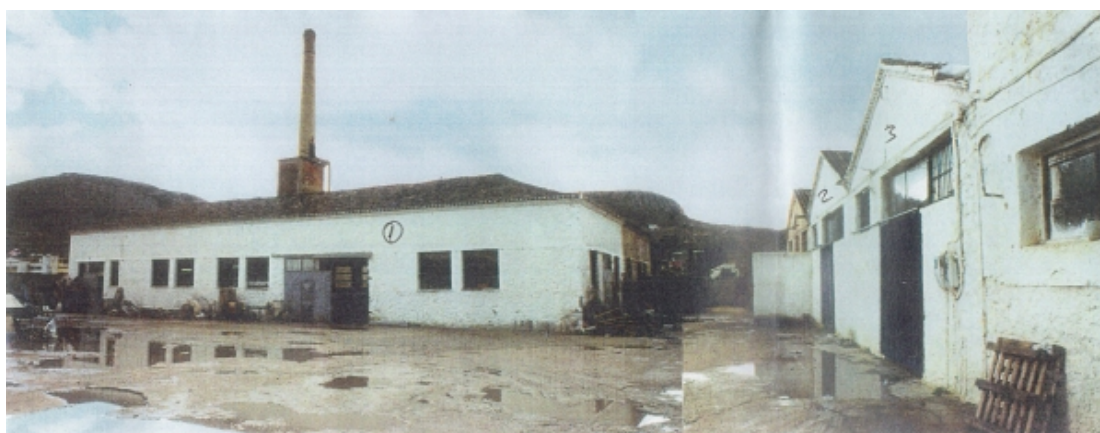
Γενική άποψη του συγκροτήματος, κτιριακή ενότητα 1 (Βόρεια όψη)
