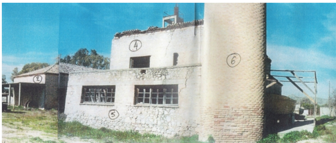
Όψη συνοδευτικού κτίσματος, κτιριακή ενότητα 1 (Νότια όψη)
