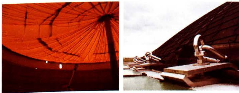
Σχήμα 2.6: Κάλυμμα χωνευτήρα από αεροστεγή μεμβράνη, όπως παρατηρείται στο εσωτερικό της δεξαμενής, αριστερά, εφοδιασμένα εξωτερικά με πλέγμα διαστολής, δεξιά [25]
