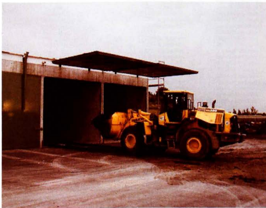
Σχήμα 3.4 Χωνευτήρας «τύπου γκαράζ», τροφοδοτούμενος από φορτωτή [33]
