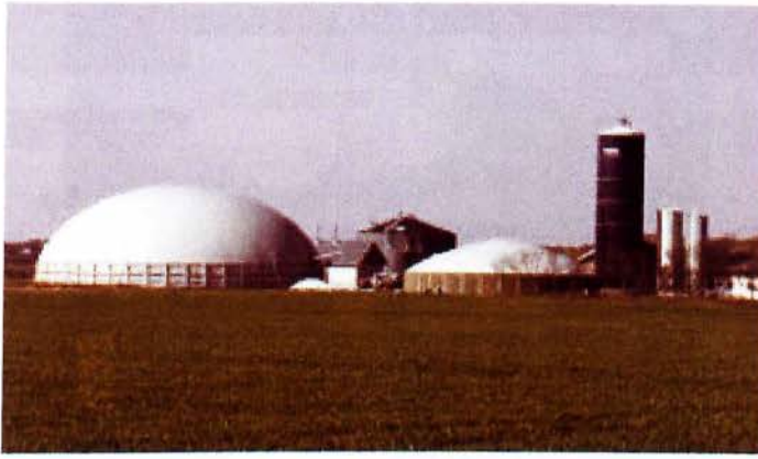
Σχήμα 3.11: Εγκατάσταση βιοαερίου κλίμακας αγροκτήματος στη Δανία, για την συγχώνευση ζωικών πολτών και ενεργειακών καλλιεργειών [33]
