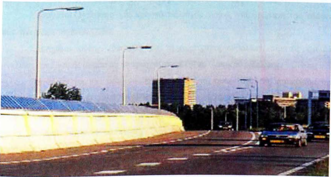
Σχήμα 1.16 Ηχοφράκτης με Φ/Β πλαίσια στο επάνω μισό κατά μήκος του αυτοκινητόδρομου A27 στην Ουτρέχτη (Ολλανδία)
