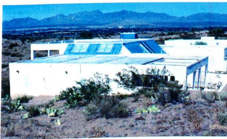
Εικόνα 1.5.3.1 : Υδάτινη θερμαινόμενη οροφή σε κτίριο
