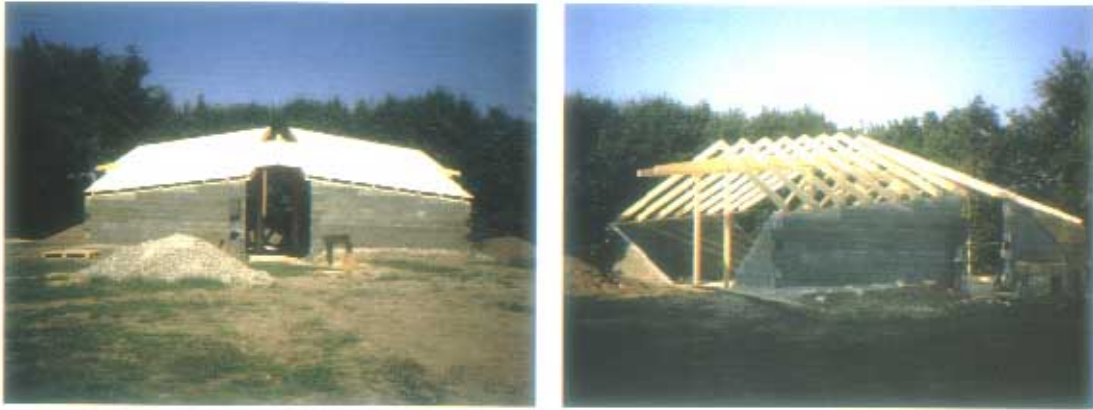
ΕΙΚΟΝΑ 4. ΕΞΩΤΕΡΙΚΗ ΑΠΟΨΗ ΚΑΤΑΣΚΕΥΑΣΤΙΚΩΝ ΣΤΑΔΙΩΝ ΤΟΥ ΚΤΙΣΜΑΤΟΣ. (4)
