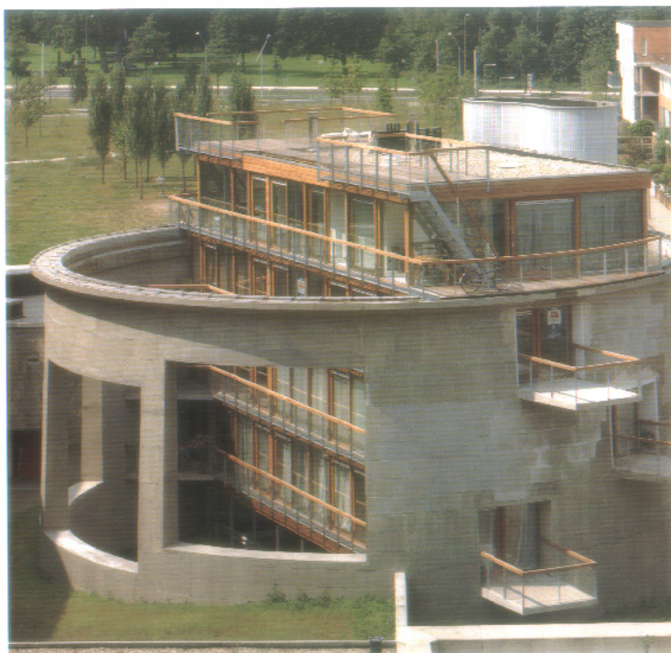
ΕΙΚΟΝΑ 6. ΕΞΩΤΕΡΙΚΗ ΑΠΟΨΗ PETIPE SEWAGE PLANT. (6)
