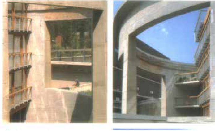
ΕΙΚΟΝΑ 4. ΕΞΩΤΕΡΙΚΗ ΑΠΟΨΗ ΛΕΠΤΟΜΕΡΕΙΩΝ ΚΤΙΣΜΑΤΩΝ SEWAGE PLANT. (4)
