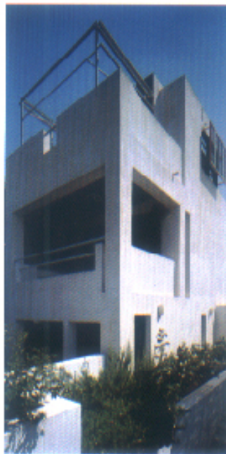
ΕΙΚΟΝΑ 5. ΕΞΩΤΕΡΙΚΗ ΑΠΟΨΗ ΚΑΤΟΙΚΙΑΣ. (5) (1),(2),(3),(4),(5) Πηγή : «Σύγχρονη Αρχιτεκτονική στην Ελλάδα»
