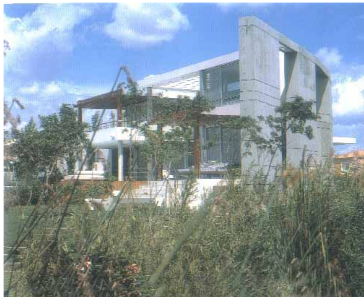
ΕΙΚΟΝΑ 2. ΠΑΝΟΡΑΜΙΚΗ ΑΠΟΨΗ ΤΟΥ ΚΤΙΣΜΑΤΟΣ. (10)
