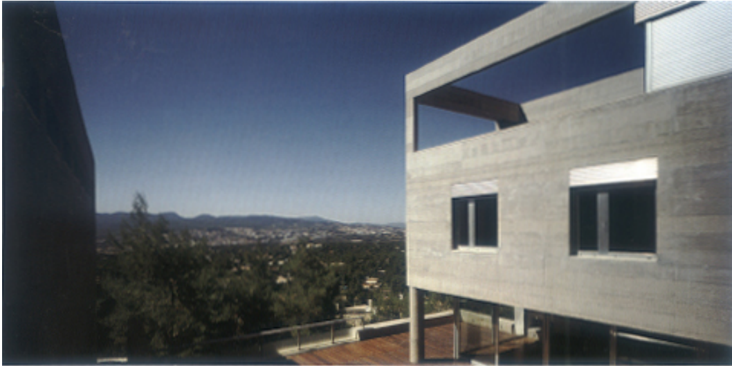
ΕΙΚΟΝΑ 1. ΕΞΩΤΕΡΙΚΗ ΑΠΟΨΗ ΤΥΠΙΚΗΣ ΚΑΤΟΙΚΙΑΣ. (10)
