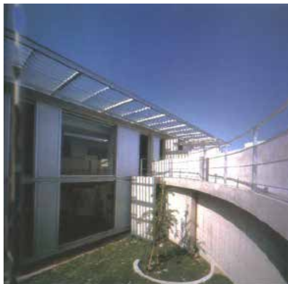
ΕΙΚΟΝΑ 2. ΕΞΩΤΕΡΙΚΗ ΑΠΟΨΗ ΤΟΥ ΚΑΜΠΥΛΟΥ ΜΕΡΟΥΣ ΤΟΥ ΚΤΙΣΜΑΤΟΣ.
