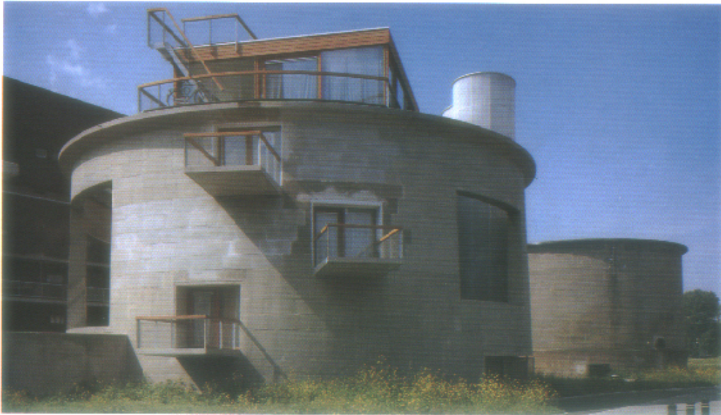
ΕΙΚΟΝΑ 1. ΠΑΝΟΡΑΜΙΚΗ ΑΠΟΨΗ ΣΥΓΚΡΟΤΗΜΑΤΟΣ ΚΑΤΟΙΚΙΩΝ SEWAGE PLANT. (1)
