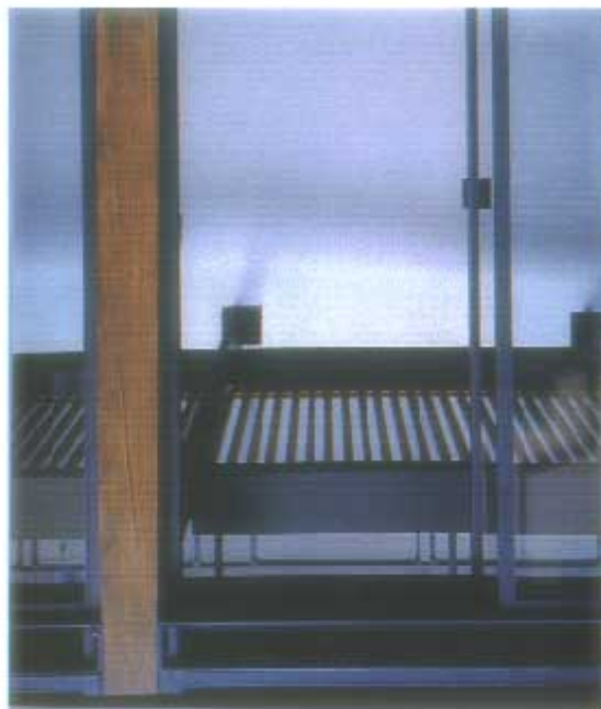
ΕΙΚΟΝΑ 7. ΑΠΟΨΗ ΕΣΩΤΕΡΙΚΩΝ ΧΩΡΩΝ ΚΤΙΣΜΑΤΟΣ. (7)
