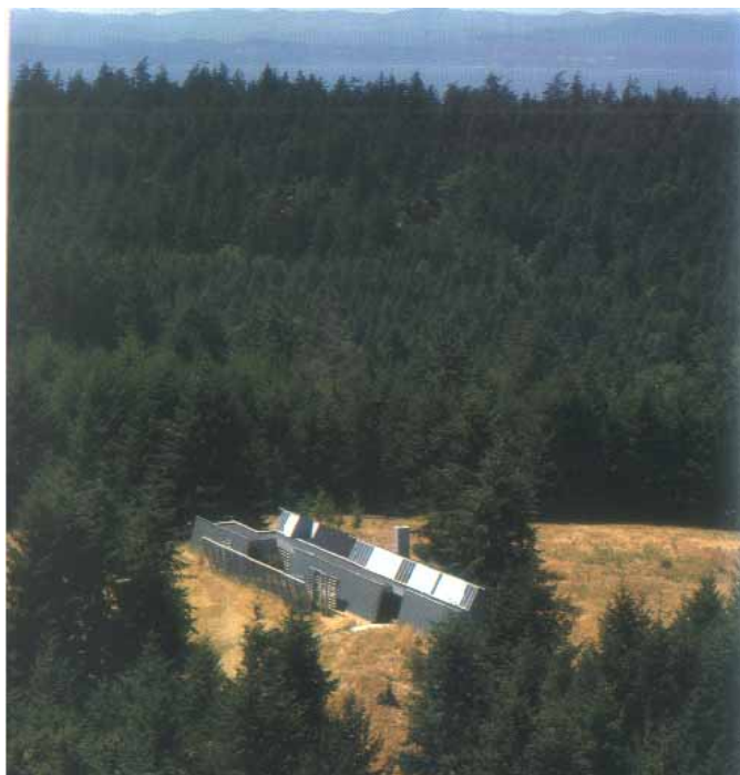
ΕΙΚΟΝΑ 1. ΠΑΝΟΡΑΜΙΚΗ ΑΠΟΨΗ ΤΟΥ ΚΤΙΣΜΑΤΟΣ. (6)
