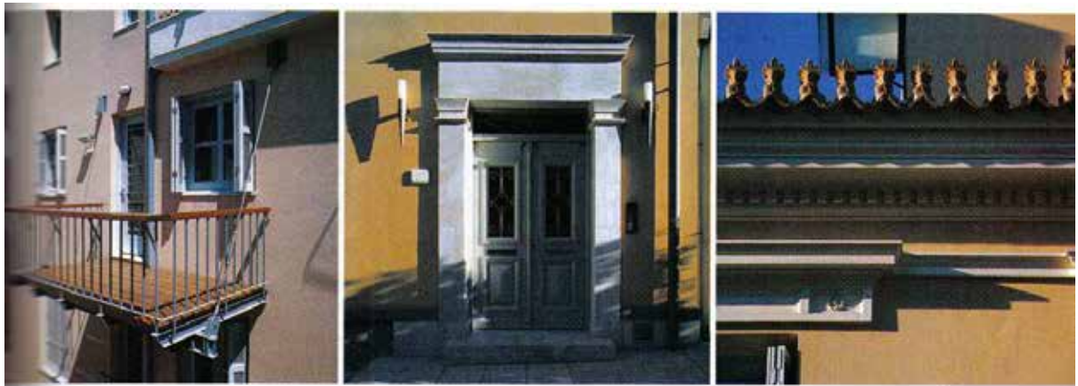
ΕΙΚΟΝΑ 3. ΕΞΩΤΕΡΙΚΕΣ ΑΠΟΨΕΙΣ ΤΟΥ ΚΤΙΣΜΑΤΟΣ. (3)
