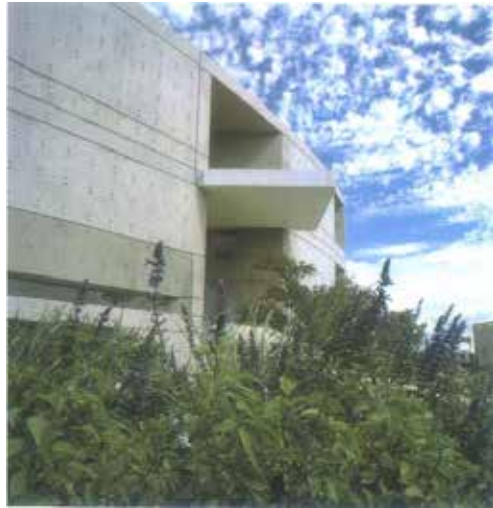
ΕΙΚΟΝΑ 3. ΠΑΝΟΡΑΜΙΚΗ ΑΠΟΨΗ ΤΟΥ ΚΤΙΣΜΑΤΟΣ. (11)
