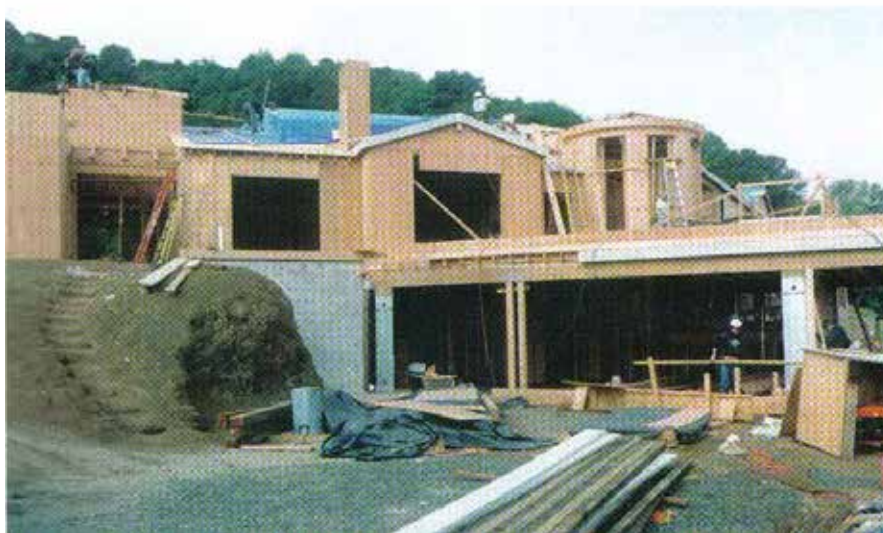
ΕΙΚΟΝΑ 3. ΣΤΑΔΙΑ ΚΑΤΑΣΚΕΥΗΣ ΠΡΟΚΑΤΑΣΚΕΥΑΣΜΕΝΟΥ ΚΤΙΣΜΑΤΟΣ. (3) (1),(2),(3), Πηγή : « Δόμηση και κατασκευές, Μάιος 2004 ».
