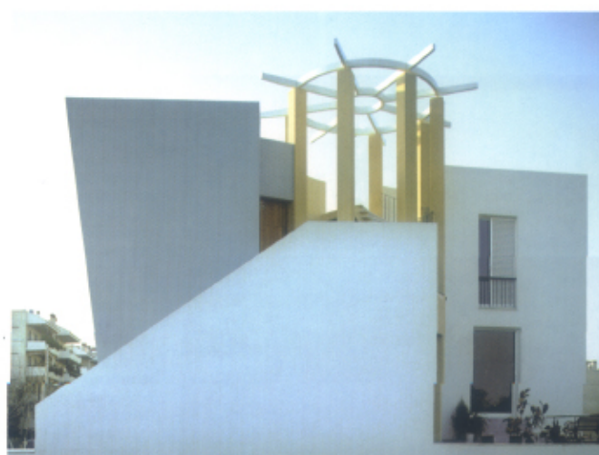
ΕΙΚΟΝΑ 5. ΕΞΩΤΕΡΙΚΗ ΑΠΟΨΗ ΚΑΤΟΙΚΙΑΣ. (5) (1),(2),(3),(4),(5), Πηγή : « Σύγχρονη Αρχιτεκτονική στην Ελλάδα ».
