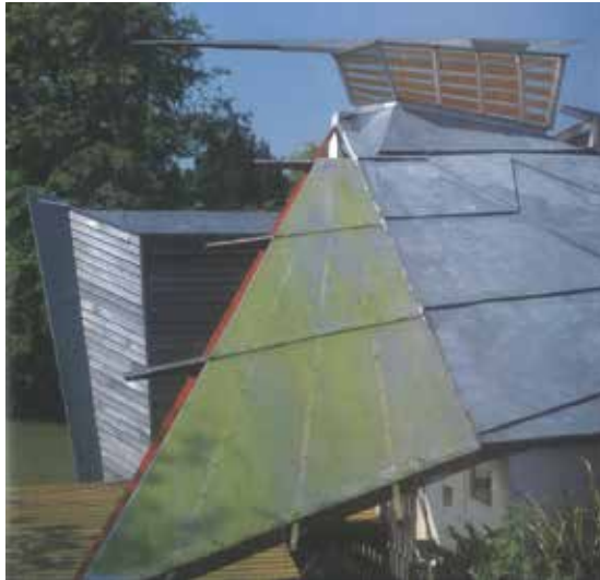
ΕΙΚΟΝΑ 7. ΕΞΩΤΕΡΙΚΗ ΑΠΟΨΗ ΚΑΤΑΣΚΕΥΑΣΤΙΚΩΝ ΛΕΠΤΟΜΕΡΕΙΩΝ ΤΟΥ ΚΤΙΣΜΑΤΟΣ. (5)
