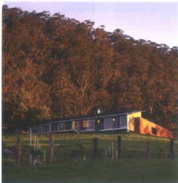
ΣΧΗΜΑ 2. ΠΑΝΟΡΑΜΙΚΗ ΑΠΟΨΗ ΤΟΥ ΚΤΙΣΜΑΤΟΣ. (2)
