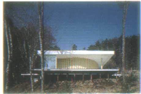
ΕΙΚΟΝΑ 2. ΕΣΩΤΕΡΙΚΗ ΔΙΑΤΑΞΗ ΤΟΥ ΚΤΙΣΜΑΤΟΣ – ΕΝΣΩΜΑΤΩΣΗ ΣΤΗΝ ΤΟΠΙΑΚΗ ΕΝΟΤΗΤΑ. (2)
