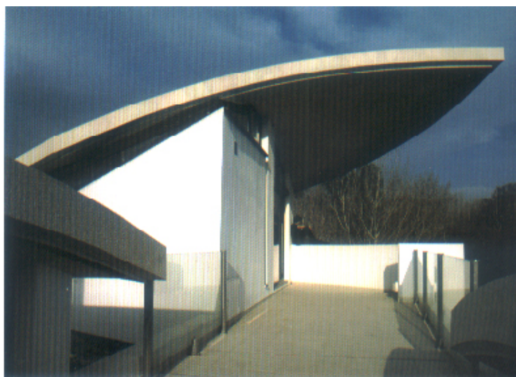
ΕΙΚΟΝΑ 4. ΕΞΩΤΕΡΙΚΗ ΑΠΟΨΗ ΚΑΤΟΙΚΙΑΣ. (4) (1),(2),(3),(4), Πηγή : «Σύγχρονη Αρχιτεκτονική στην Ελλάδα»
