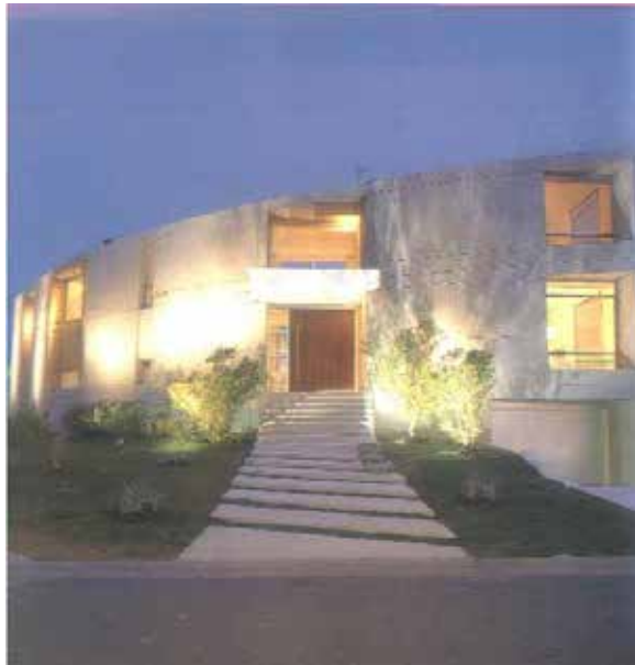
ΕΙΚΟΝΑ 1. ΔΙΑΤΑΞΗ ΕΙΣΟΔΟΥ ΤΟΥ ΚΤΙΣΜΑΤΟΣ. (9)
