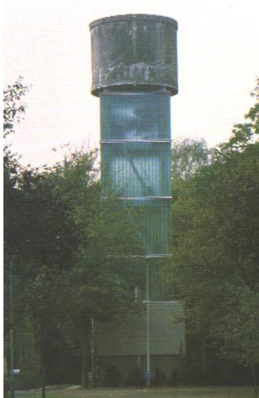
ΕΙΚΟΝΑ 1. ΠΑΝΟΡΑΜΙΚΗ ΑΠΟΨΗ ΚΤΙΣΜΑΤΟΣ ΥΔΑΤΟΠΥΡΓΟΥ. (1)
