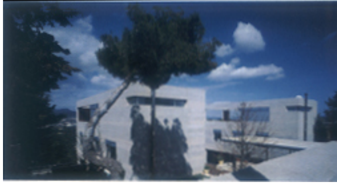
ΕΙΚΟΝΑ 4. ΕΞΩΤΕΡΙΚΗ ΑΠΟΨΗ ΚΑΤΟΙΚΙΑΣ. (14) (10),(11),(12),(13),(14), Πηγή : « Σύγχρονη Αρχιτεκτονική στην Ελλάδα».
