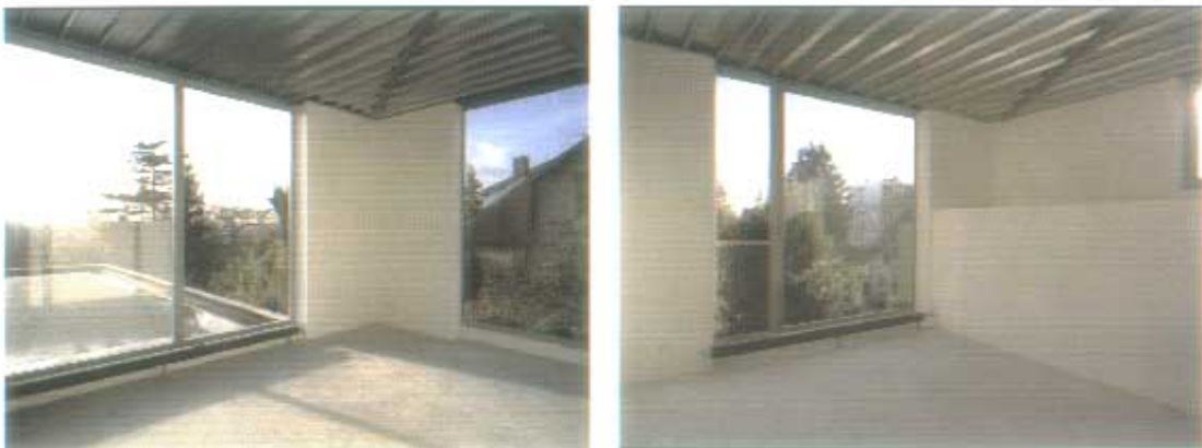
ΕΙΚΟΝΑ 4. ΕΣΩΤΕΡΙΚΗ ΑΠΟΨΗ ΤΟΥ ΚΤΙΣΜΑΤΟΣ. (8)
