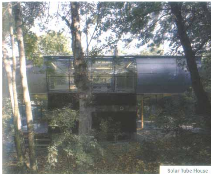
ΕΙΚΟΝΑ 2. ΟΨΗ ΤΟΥ ΚΤΙΣΜΑΤΟΣ. (2)
