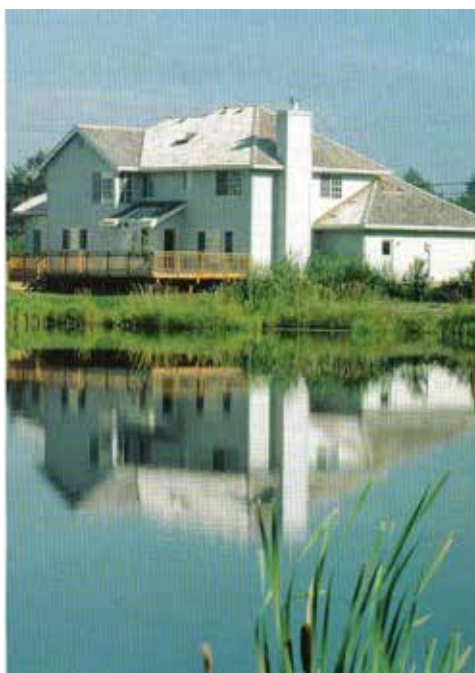
ΕΙΚΟΝΑ 2. ΕΞΩΤΕΡΙΚΗ ΠΡΟΚΑΤΑΣΚΕΥΑΣΜΕΝΟΥ ΑΠΟΨΗ ΚΤΙΣΜΑΤΟΣ. (2)
