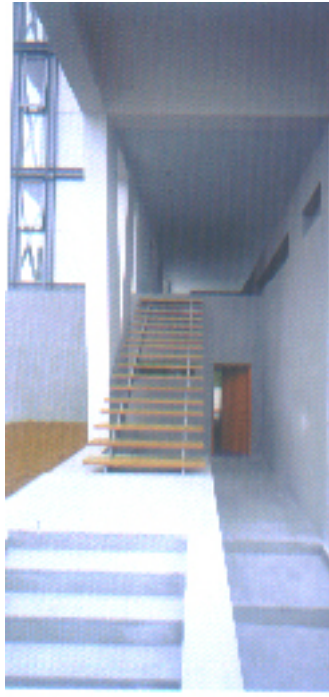
ΕΙΚΟΝΑ 4. ΕΞΩΤΕΡΙΚΗ ΑΠΟΨΗ ΚΑΤΟΙΚΙΑΣ. (8) (5),(6),(7),(8), Πηγή : «Σύγχρονη Αρχιτεκτονική στην Ελλάδα ».
