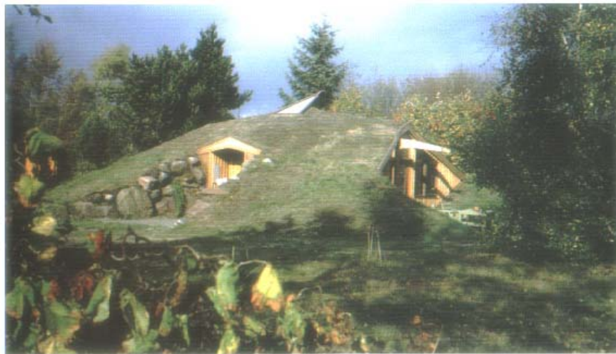
ΕΙΚΟΝΑ 5. ΕΞΩΤΕΡΙΚΗ ΑΠΟΨΗ ΤΜΗΜΑΤΩΝ ΤΟΥ ΚΤΙΣΜΑΤΟΣ. (5)
