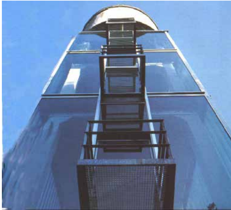
ΕΙΚΟΝΑ 2. ΕΞΩΤΕΡΙΚΗ ΕΙΚΟΝΑ ΜΕΤΑ ΤΗΝ ΑΝΑΚΑΤΑΣΚΕΥΗ. (2)
