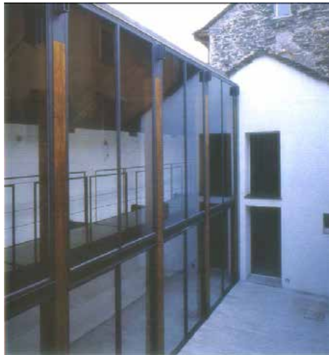
ΕΙΚΟΝΑ 5. ΑΠΟΨΗ ΕΣΩΤΕΡΙΚΩΝ ΑΣΚΕΠΩΝ ΧΩΡΩΝ ΚΤΙΣΜΑΤΟΣ. (5)
