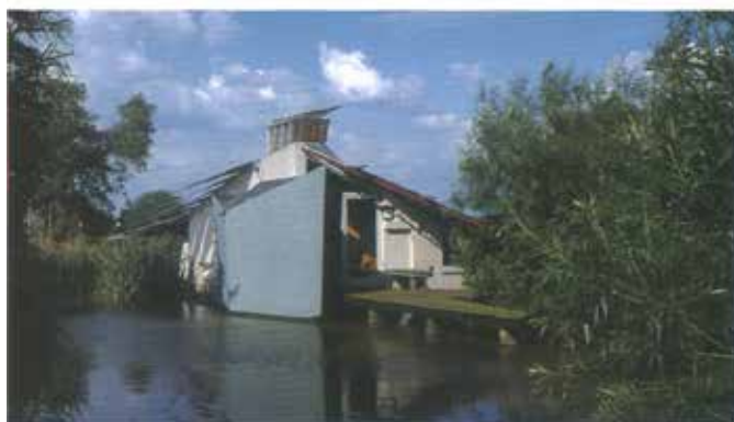
ΕΙΚΟΝΑ 3 – 4 . ΤΟΠΙΑΚΗ ΕΝΟΤΗΤΑ ΠΟΥ ΚΑΤΑΣΚΕΥΑΣΤΗΚΕ ΤΟ ΚΤΙΣΜΑ. (2)
