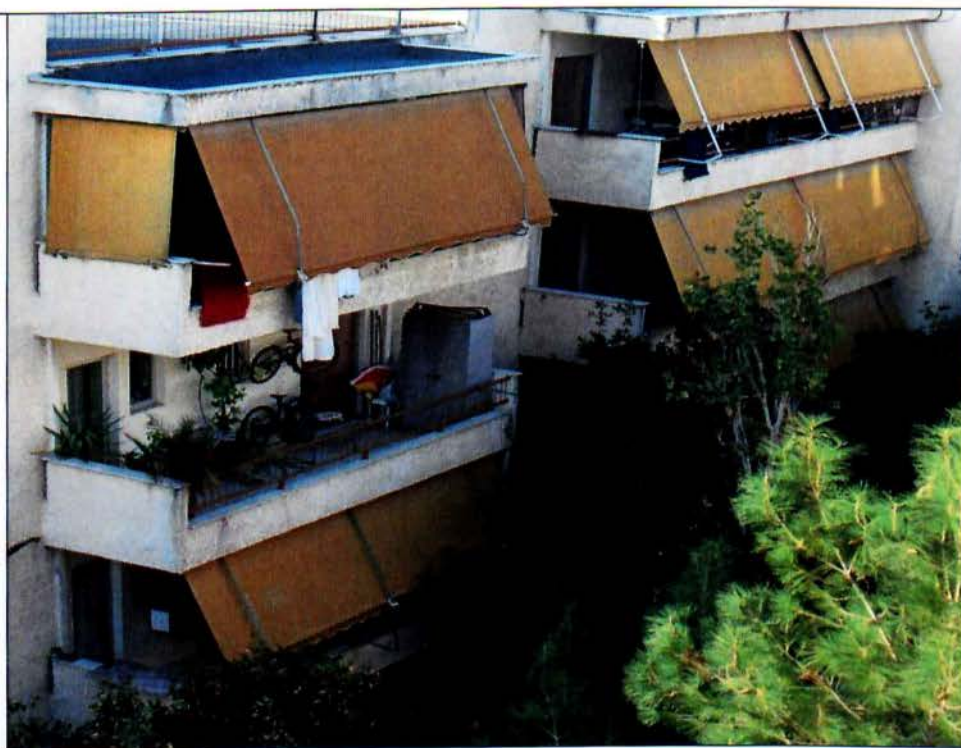
Φωτογραφία 4.1 Φωτογραφία κτιρίου, πλευρά ΑΒ
