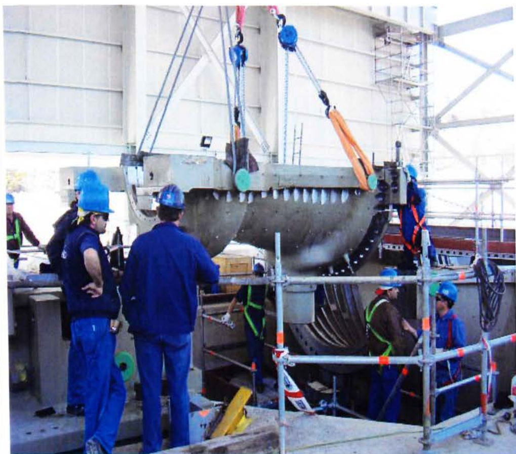
Εικ. 30. Συναρμολόγηση, τοποθέτηση κάτω μισού κελύφους τουρμπίνας αναθέρμανσης
