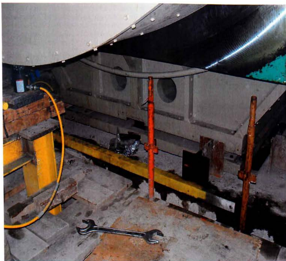
Εικ. 23. Διάταξη βάσης θεμελίωσης ΧΠ
