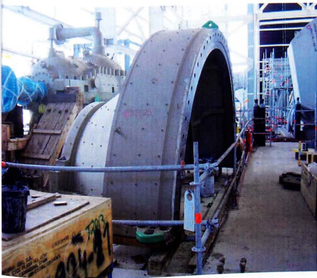
Εικ. 38. Άνω μισό κέλυφος κυλίνδρου ΧΠ
