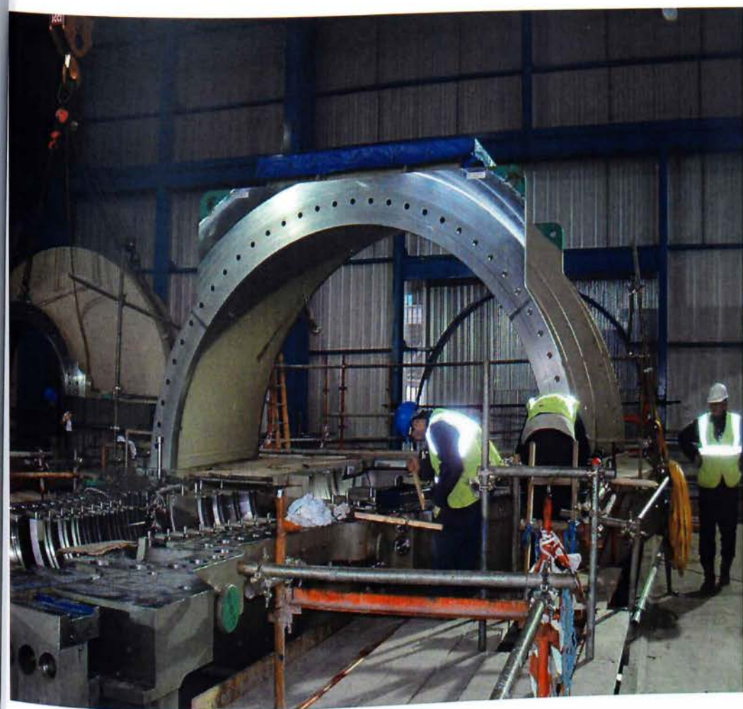
Εικ. 37. Τοποθέτηση άνω μισού κελύφους ΧΠ και κατασκευή οριζόντιων κοχλιωτών συνδέσεων
