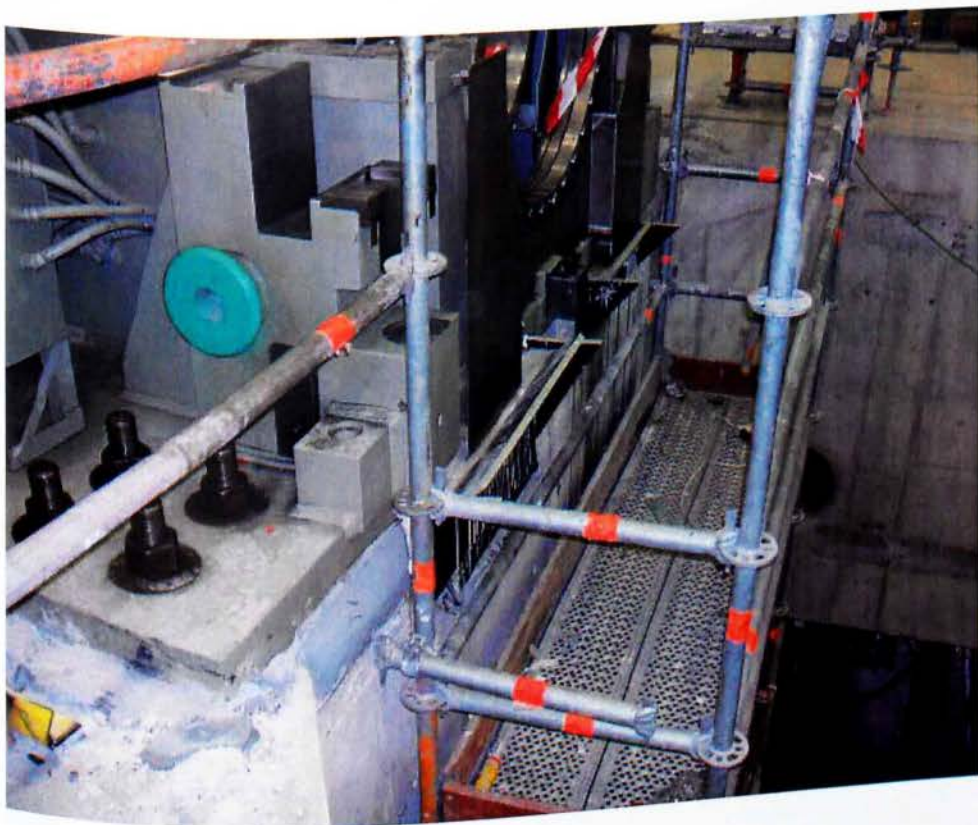
Εικ. 51. Τσιμεντένεση του μεσαίου εδράνου στη θεμελίωση
