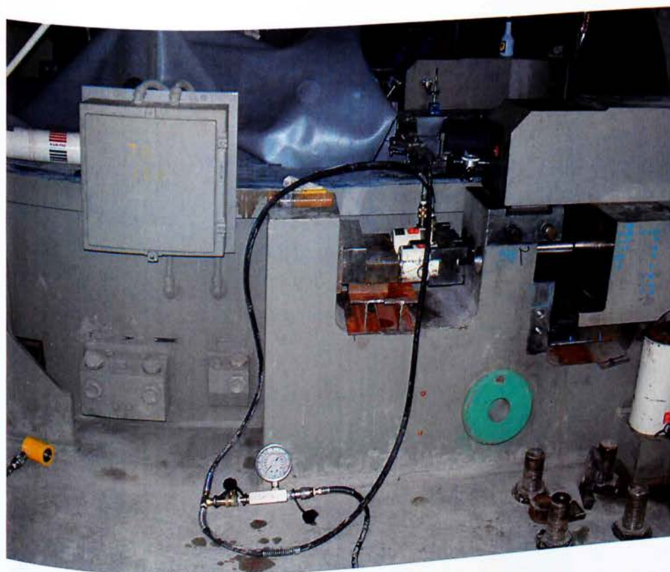
Εικ. 53. Υδραυλικοί γρύλοι τοποθετημένοι στο μεσαίο έδρανο για έλεγχο τριβής
