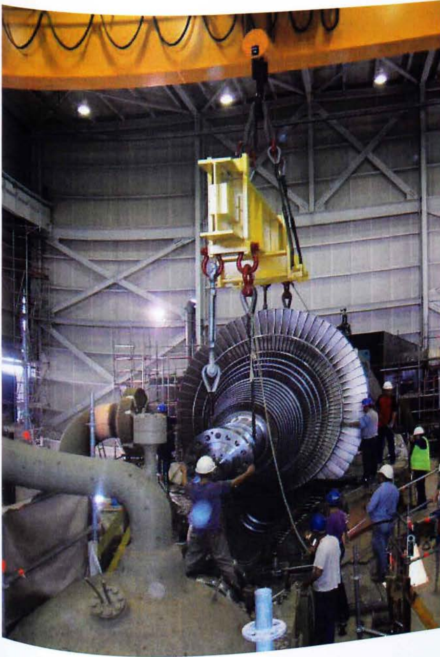
Εικ. 64. Τοποθέτηση ρότορα ΜΠ/ΧΠ στα κάτω μισά κελύφη
