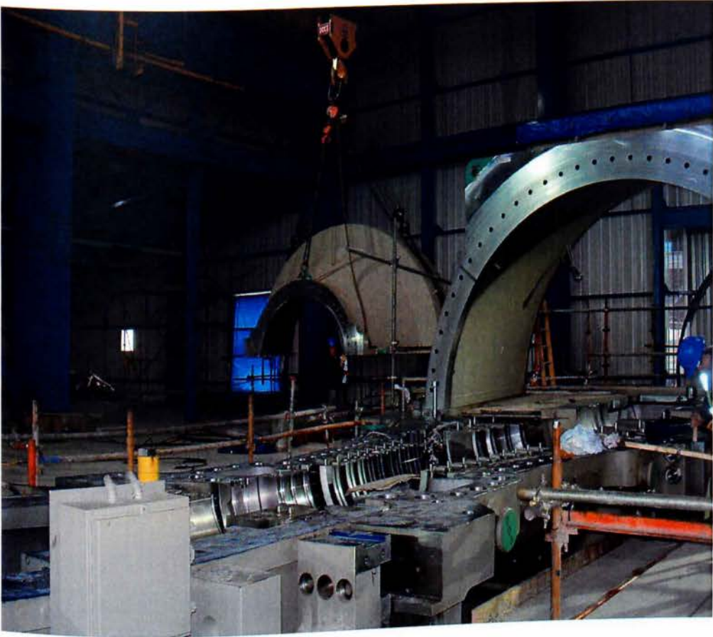
Εικ. 39. Συναρμολόγηση, ανύψωση και τοποθέτηση άνω μισού κυλίνδρου ΧΠ
