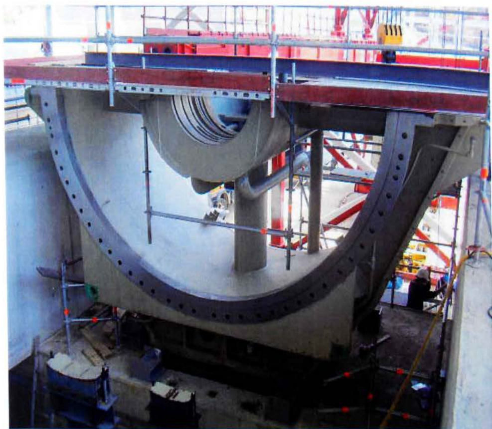
Εικ. 22. Κάτω μισό καλύμματος ΧΠ τοποθετημένο πάνω σε πλάκα θεμελίωσης
