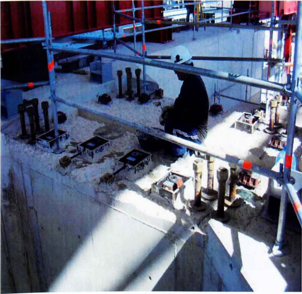
Εικ. 2. Σταθεροποιητής μεσαίου εδράνου
