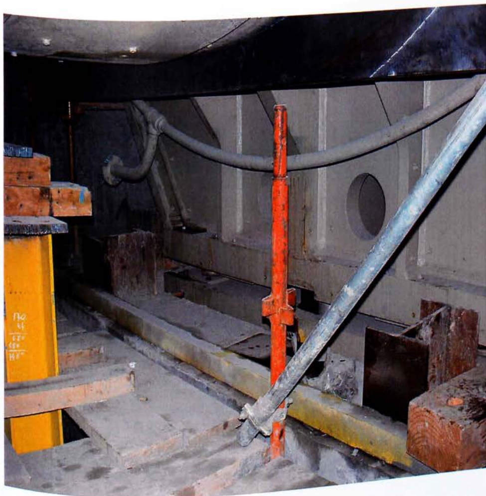
Εικ. 52. Τσιμεντένεση πλάκας βάσης ΧΠ στη θεμελίωση
