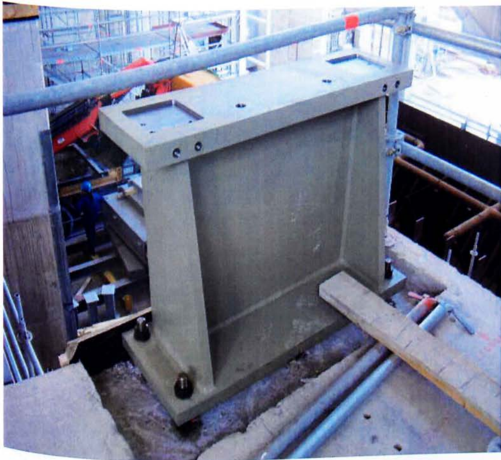
Εικ. 44. Τοποθέτηση στηριγμάτων διαχύτη εξάτμισης στη θεμελίωση
