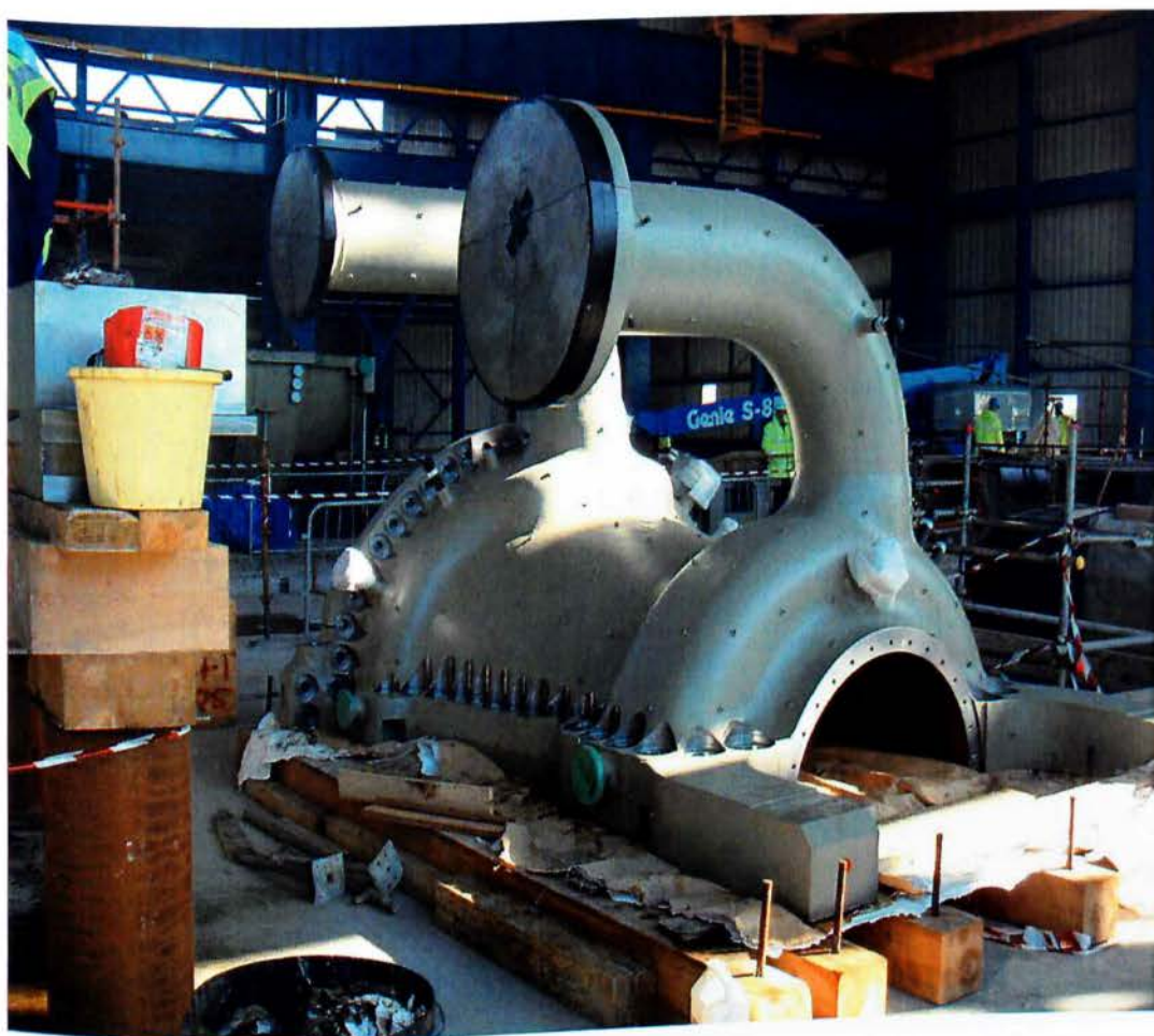
Εικ. 40. Αφαίρεση προστατευτικού περιβλήματος από το άνω κέλυφος αναθέρμανσης
