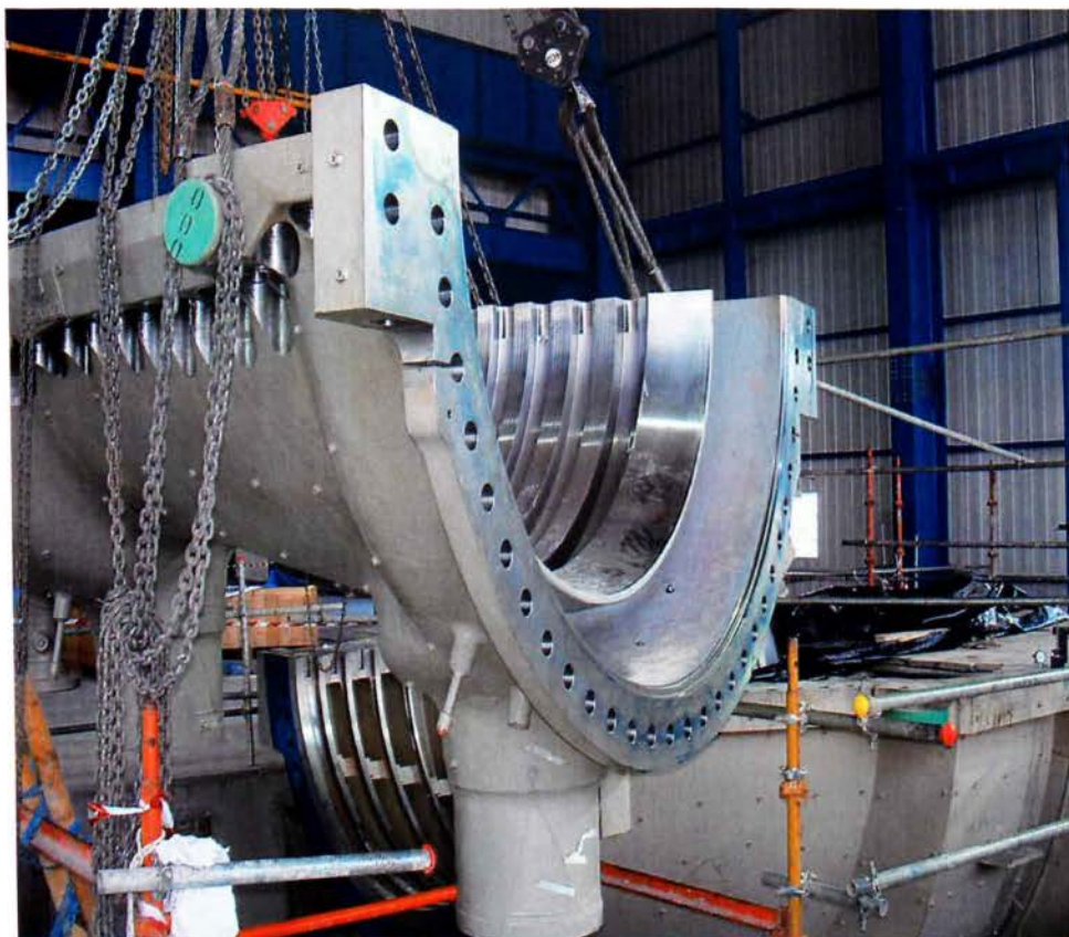
Εικ. 29. Καθαρισμός προστατευτικού περιβλήματος κάθετου αρμού αναθέρμανσης/άκρου κυλίνδρου ΧΠ
