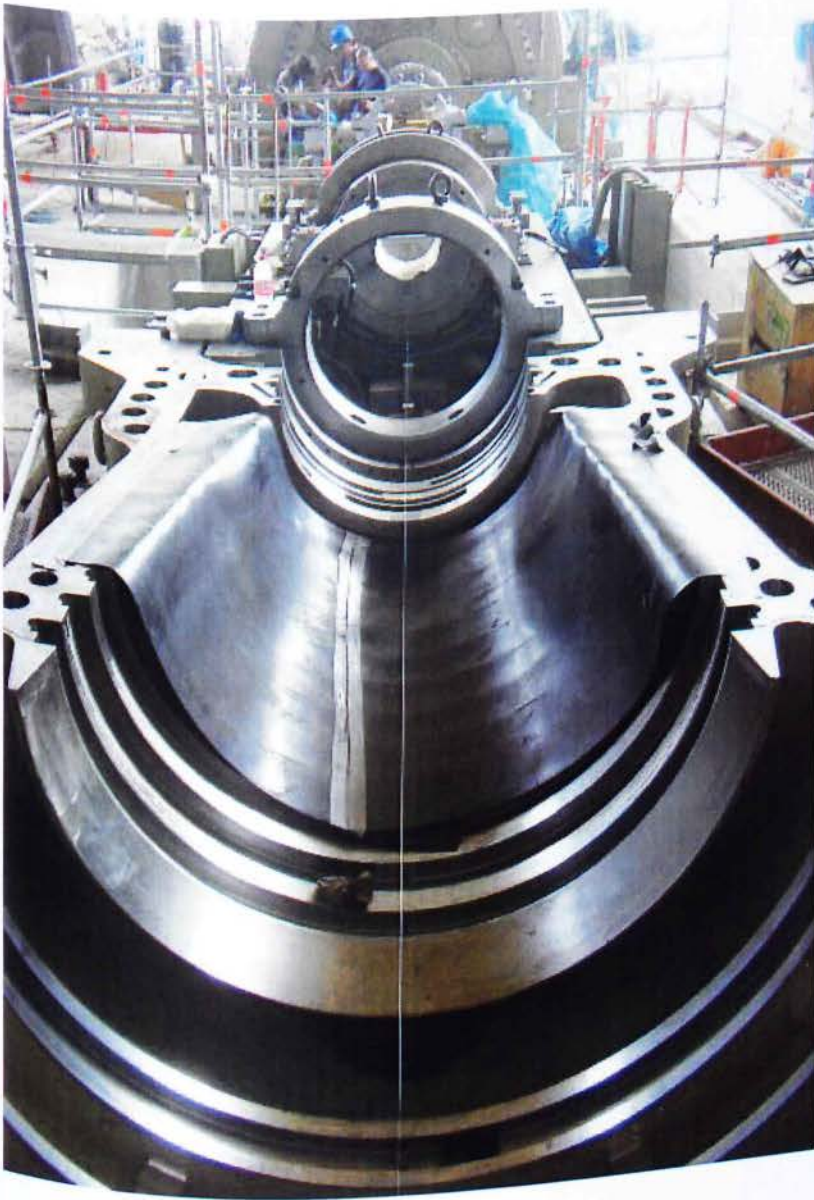
Εικ. 54. Λήψη ενδείξεων τετνωμένου σύρματος κατά μήκος του κεντρικού άξονα
