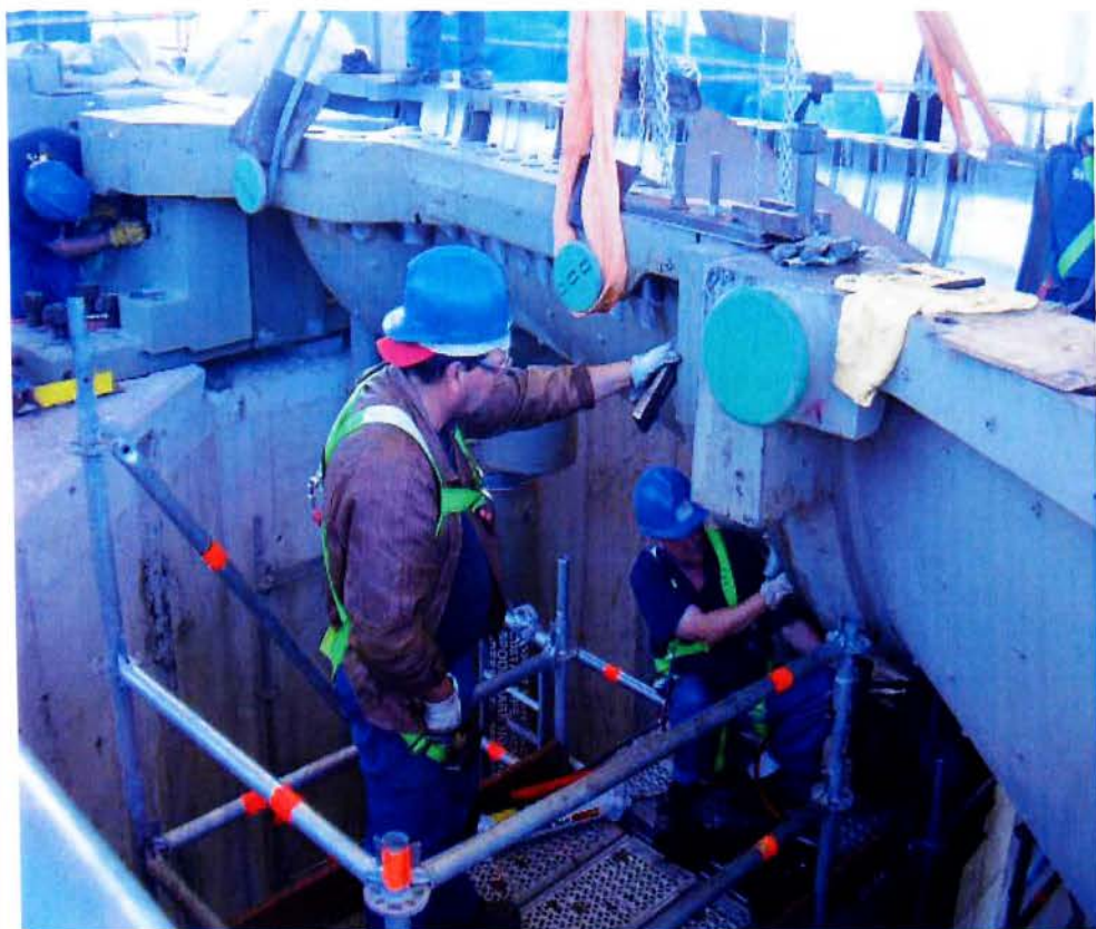
Εικ. 31. Κατασκευή κάθετου αρμού για σύνδεση του κελύφους ΑΘ στον κύλινδρο ΧΠ
