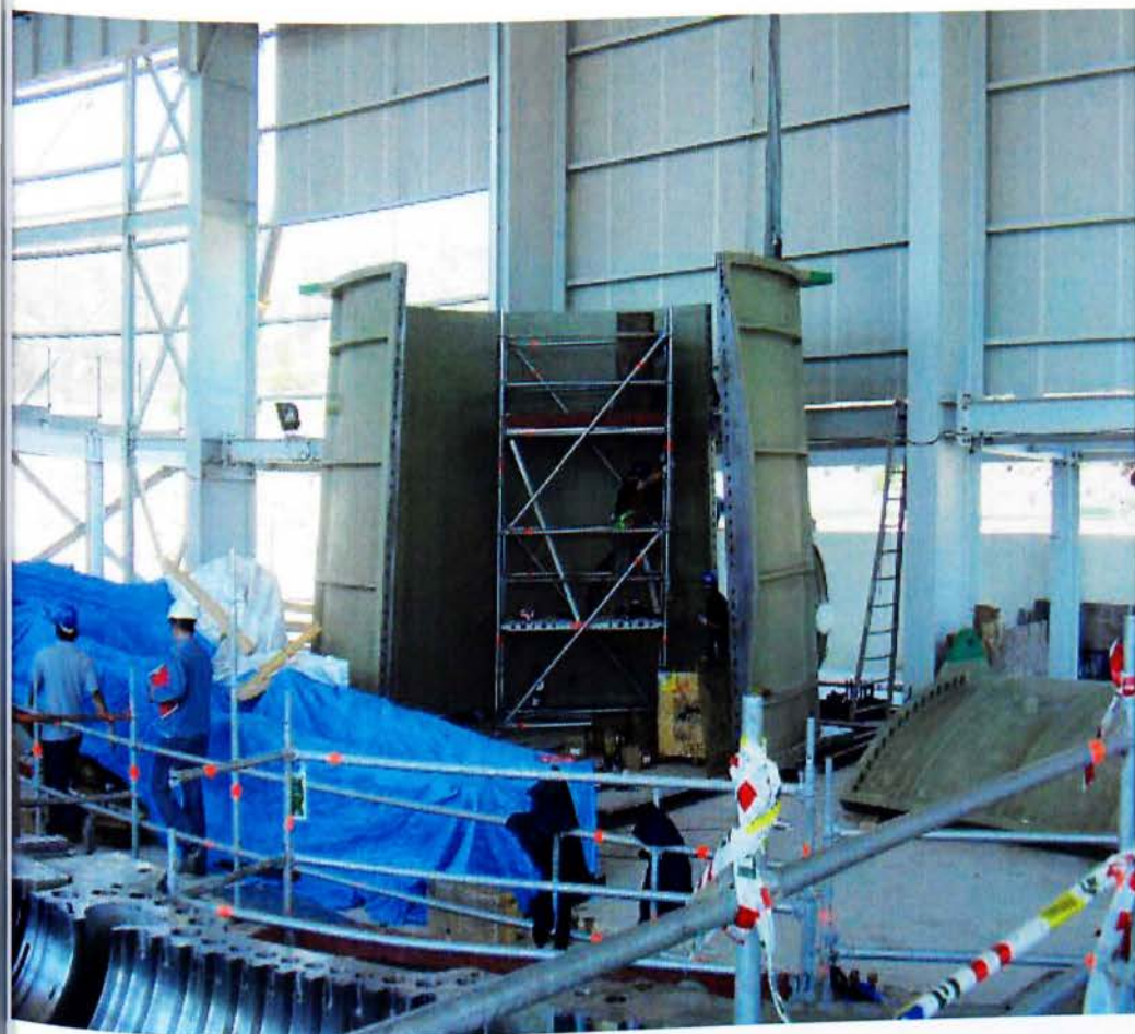
Εικ. 46. Συναρμολόγηση τεσσάρων μερών του αγωγού διάχυσης εξάτμισης
