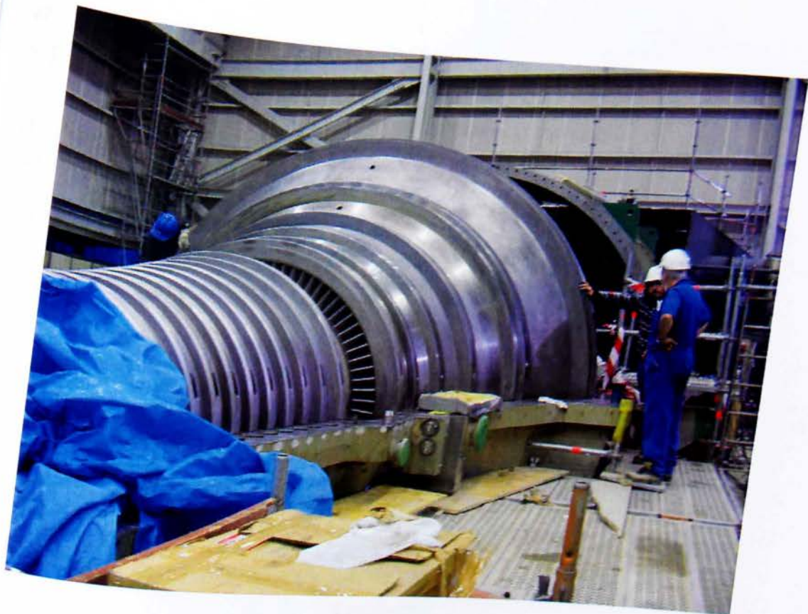
Εικ. 70. Συναρμολόγηση άνω διαφραγμάτων ΜΠ/ΧΠ
