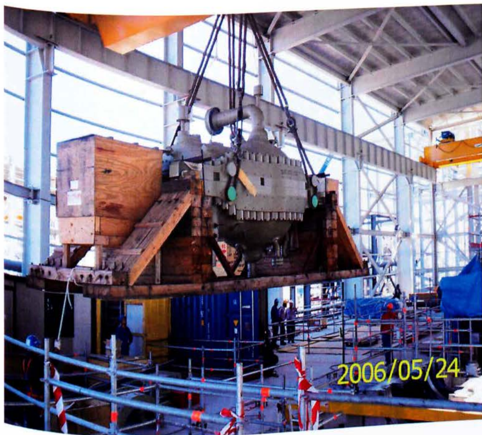
Εικ. 55. Τουρμπίνα υψηλής πίεσης η οποία μεταφέρεται (συναρμολογημένη) στο σημείο
