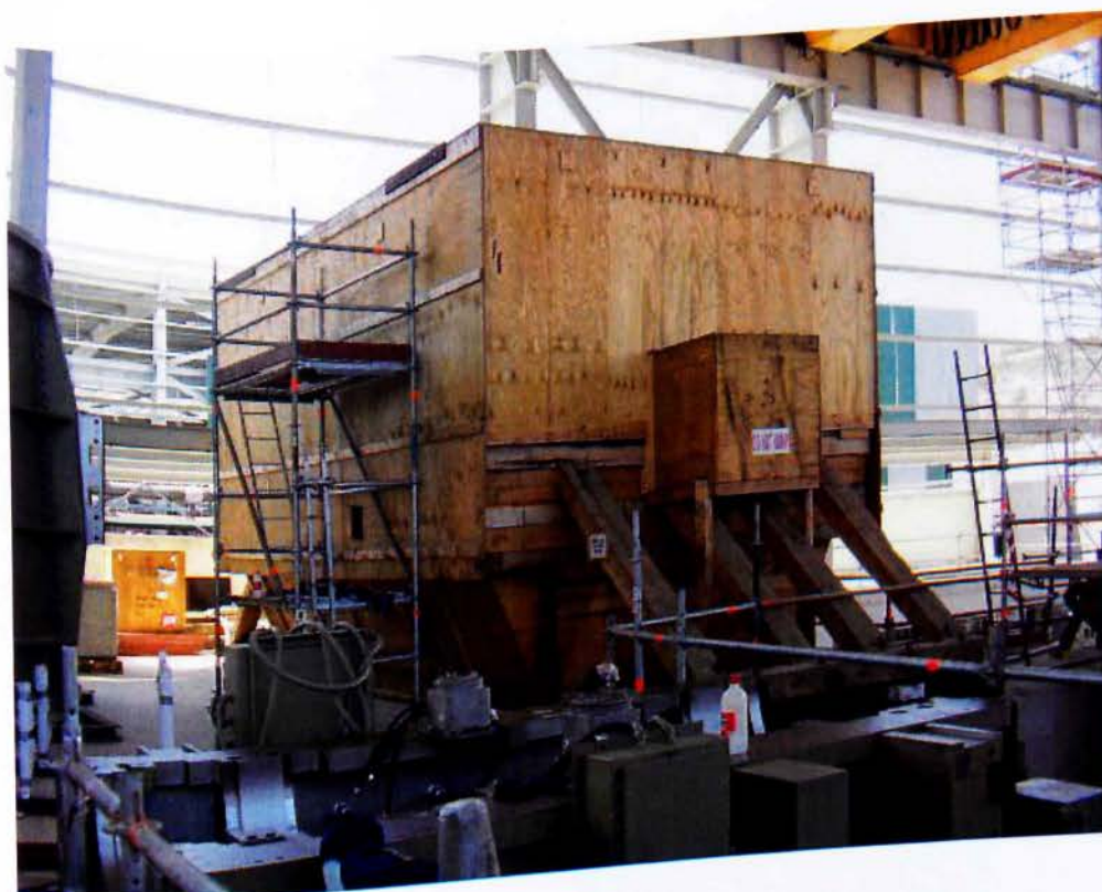
Εικ. 60. Παραλαβή και ξεφόρτωση ρότορα ΜΠ/ΧΠ στο σημείο
