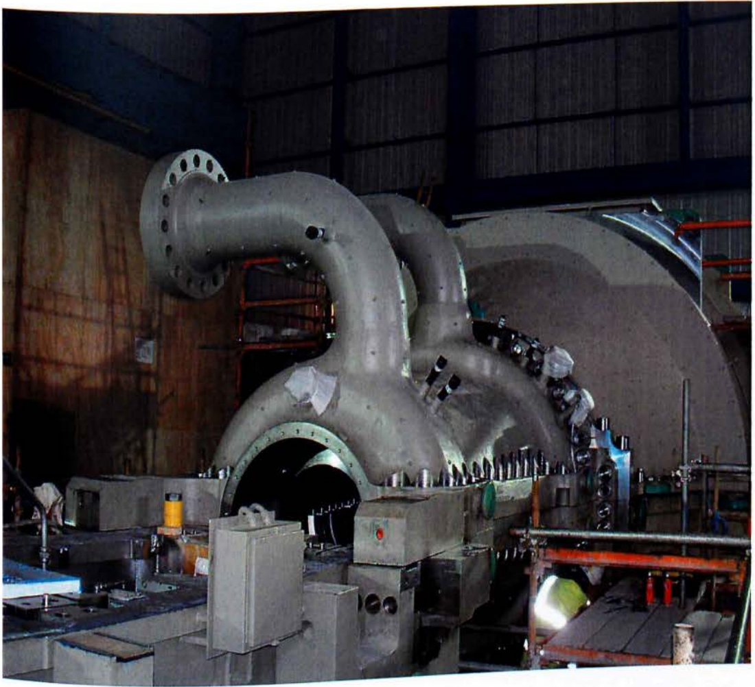
Εικ. 41. Συναρμολόγηση, ανύψωση και τοποθέτηση άνω κελύφους αναθέρμανσης και κατασκευή συνδέσεων
