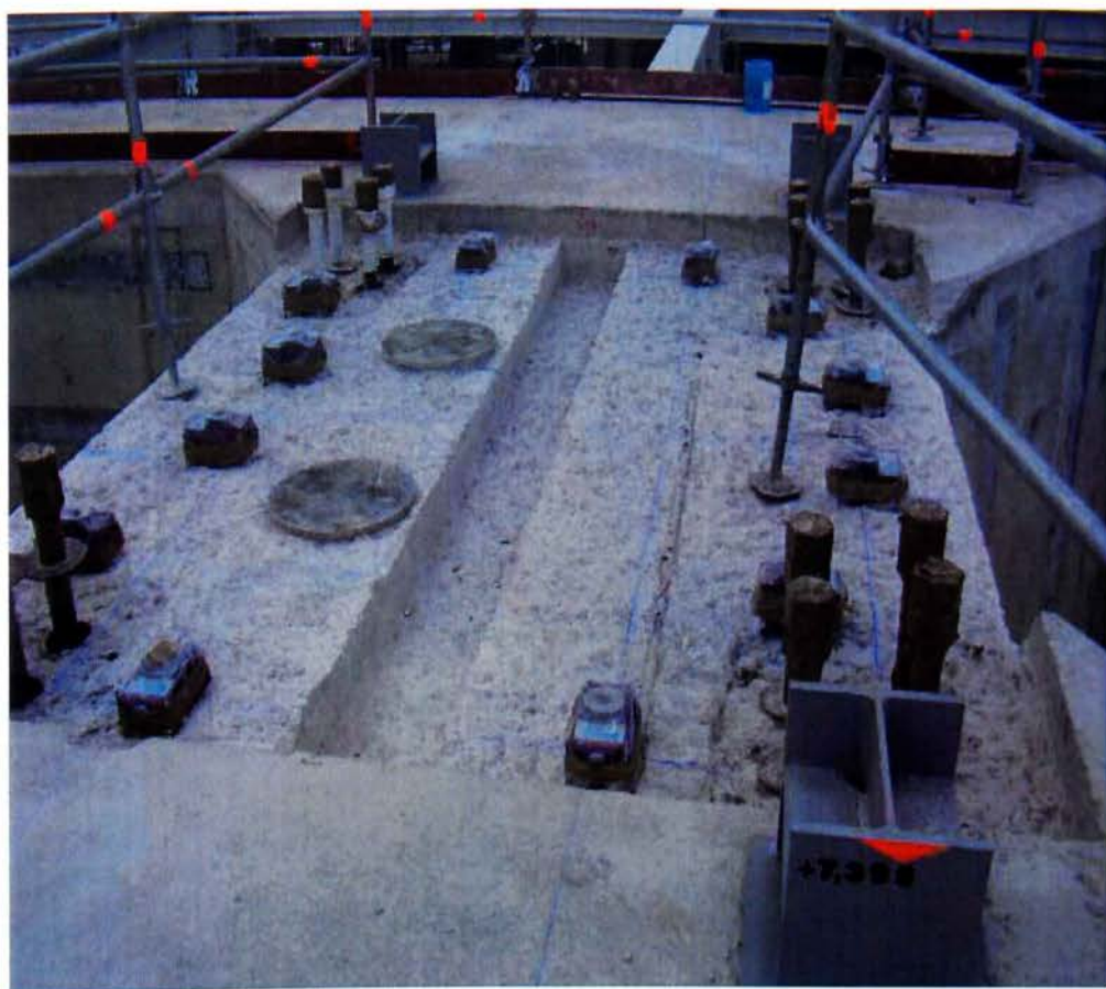
Εικ. 3. Σταθεροποιητής/θεμελίωση μεσαίου εδράνου
