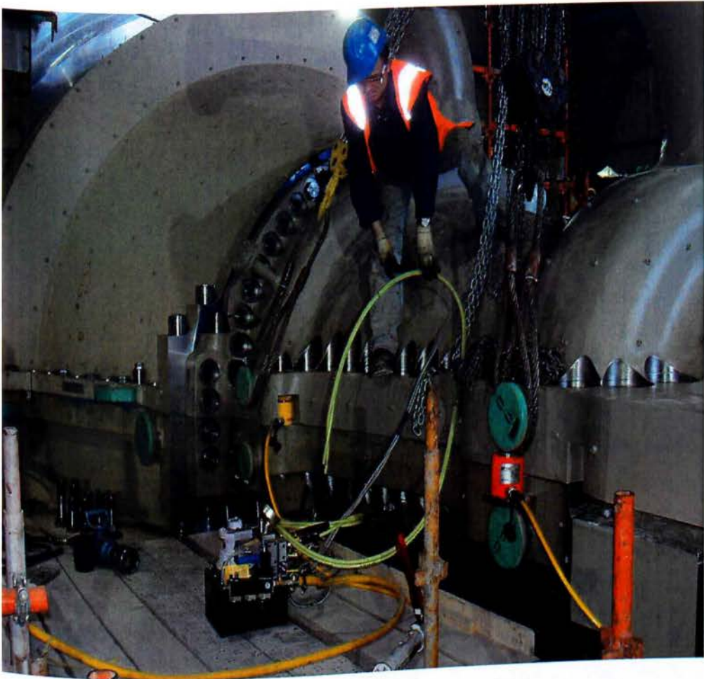
Εικ.43. Κατασκευή βιδών/ντιζών σε ένωση τεσσάρων σημείων
