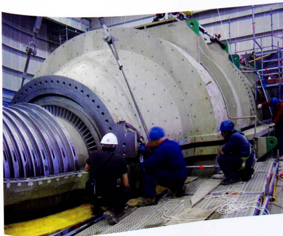
Εικ. 72. Τοποθέτηση άνω μισού (συναρμολογημένου) ΧΠ/ κελύφους κυλίνδρου ΧΠ
