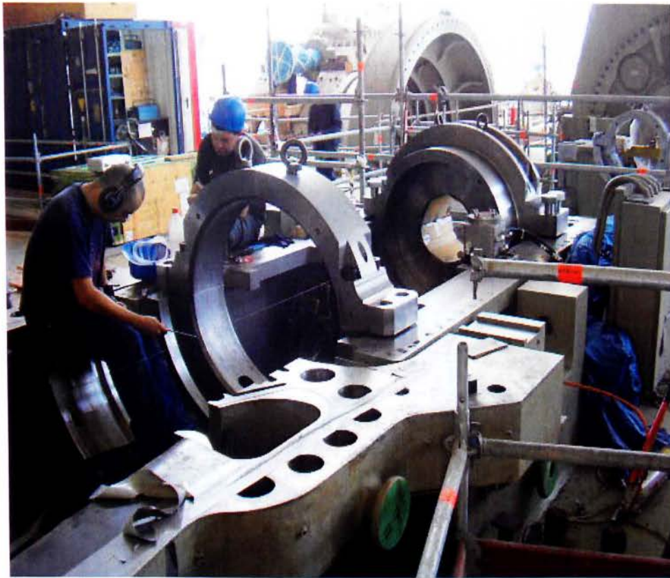
Εικ. 33. Τοποθέτηση των κουζινέτων T2 & T3 στο μεσαίο έδρανο
