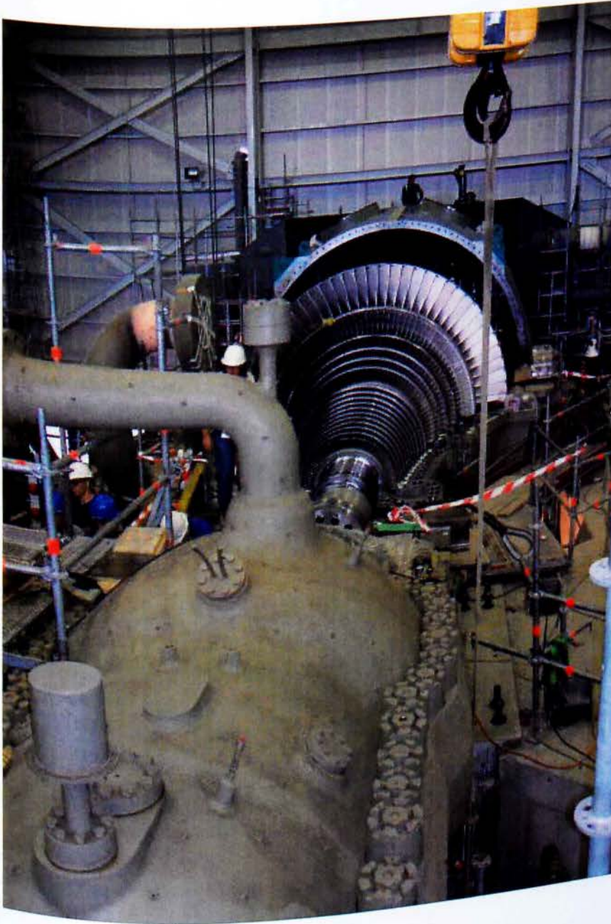
Εικ. 65. Ρότορας ΜΠ/ΧΠ τοποθετημένος στα κάτω μισά κελύφη
