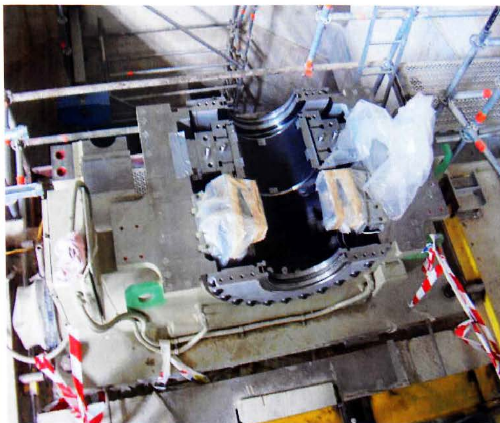
Εικ. 34. Εγκατάσταση του κουζινέτου T4 στο μπροστινό έδρανο
