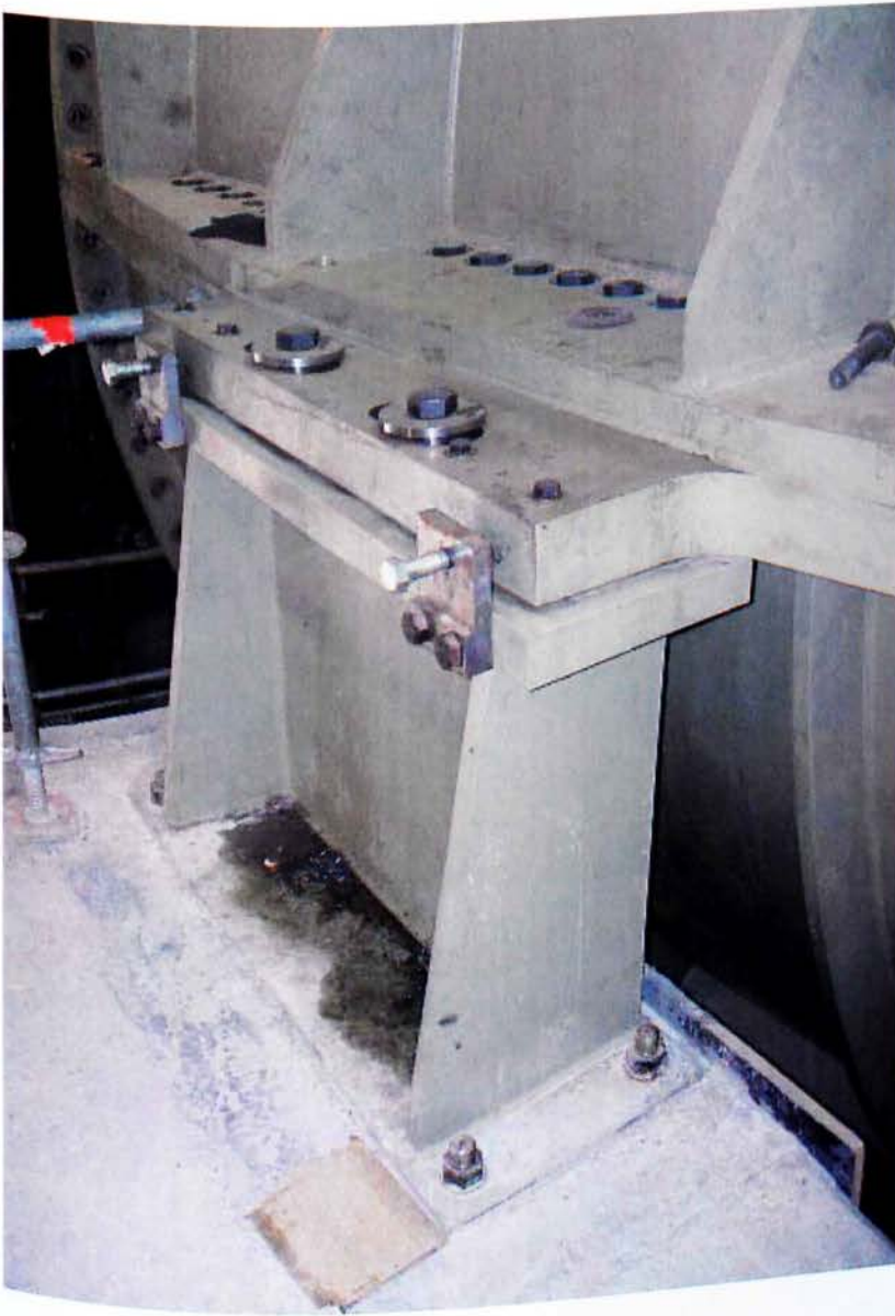
Εικ. 50. Διαχύτης συναρμολογημένος στα στηρίγματα
