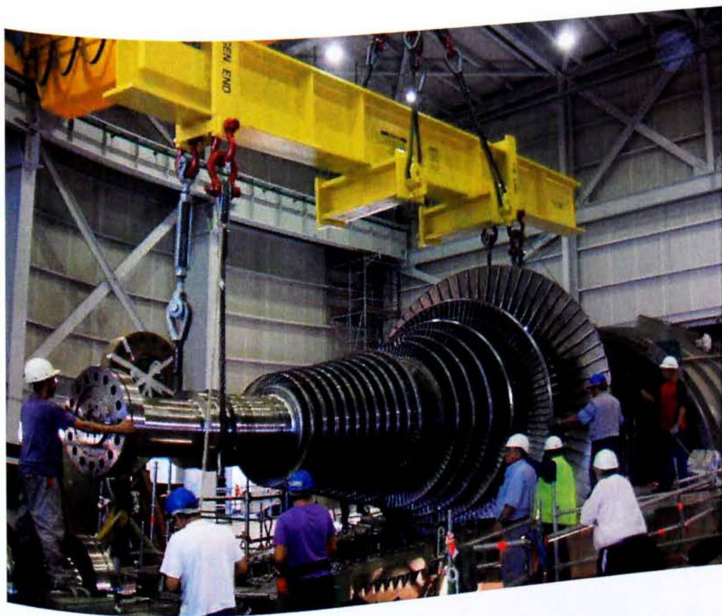
Εικ. 63. Συναρμολόγηση και μετακίνηση ρότορα ΜΠ/ΧΠ
