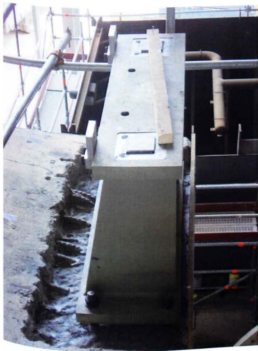
Εικ. 45. Συναρμολόγηση βάσεων από τεφλόν του διαχύτη εξάτμισης
