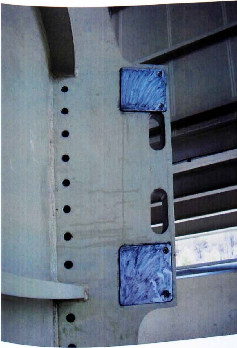
Εικ. 49. Βάσεις από τεφλόν συναρμολογημένες στον άνω διαχύτη
