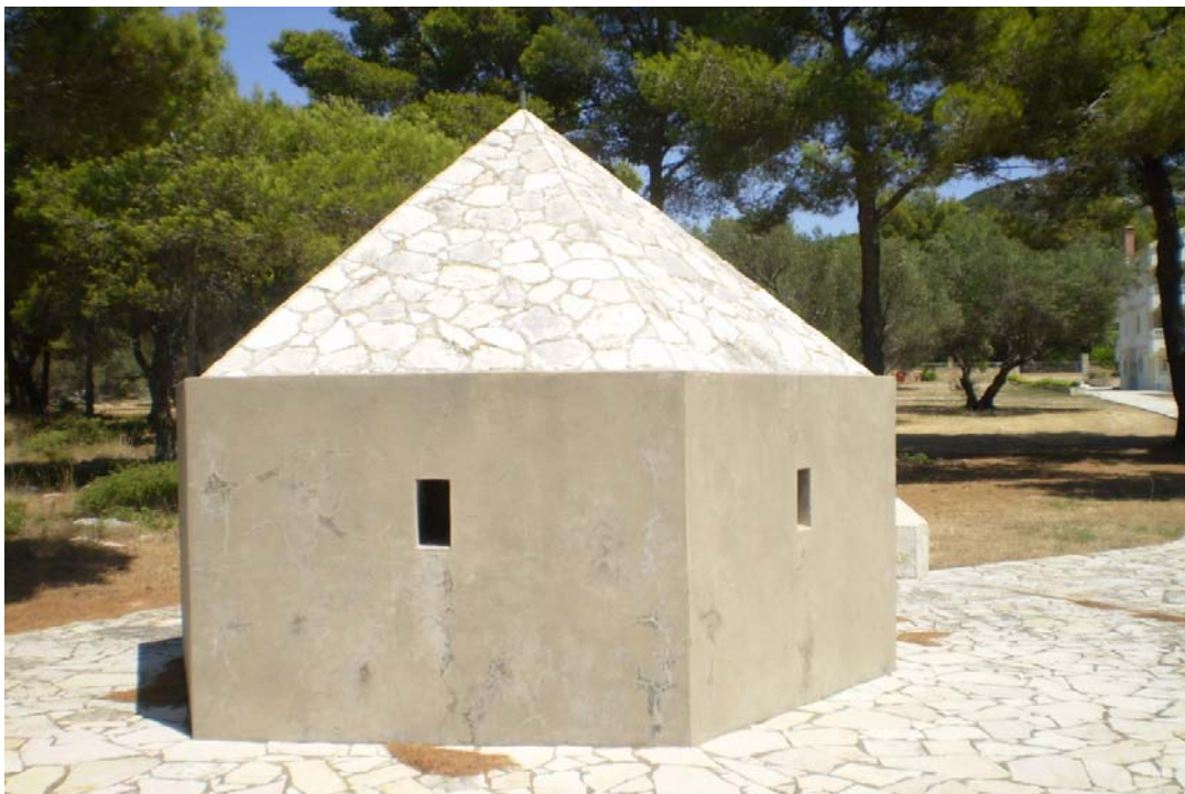
Εικ. 25: Πλαινή όψη της ίδιας βαρδιόλας. Η κάτοψη της έχει σχήμα εξάγωνου και η οροφή της είναι εξάγωνη πθραμίδα.
