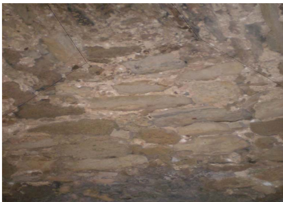
Εικ. 14: Αποψη στέγης, όπως φαίνεται από το εσωτερικό της βίγλας.
