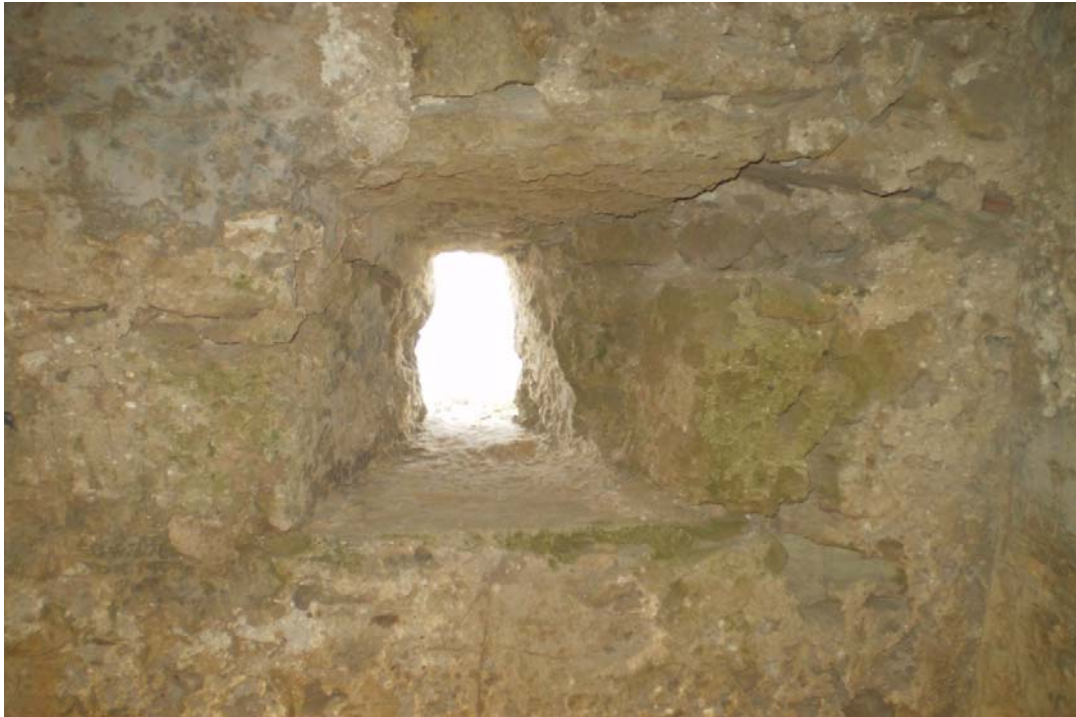
Εικ. 11: Εσωτερική άποψη τυφεκιοθρίδας
