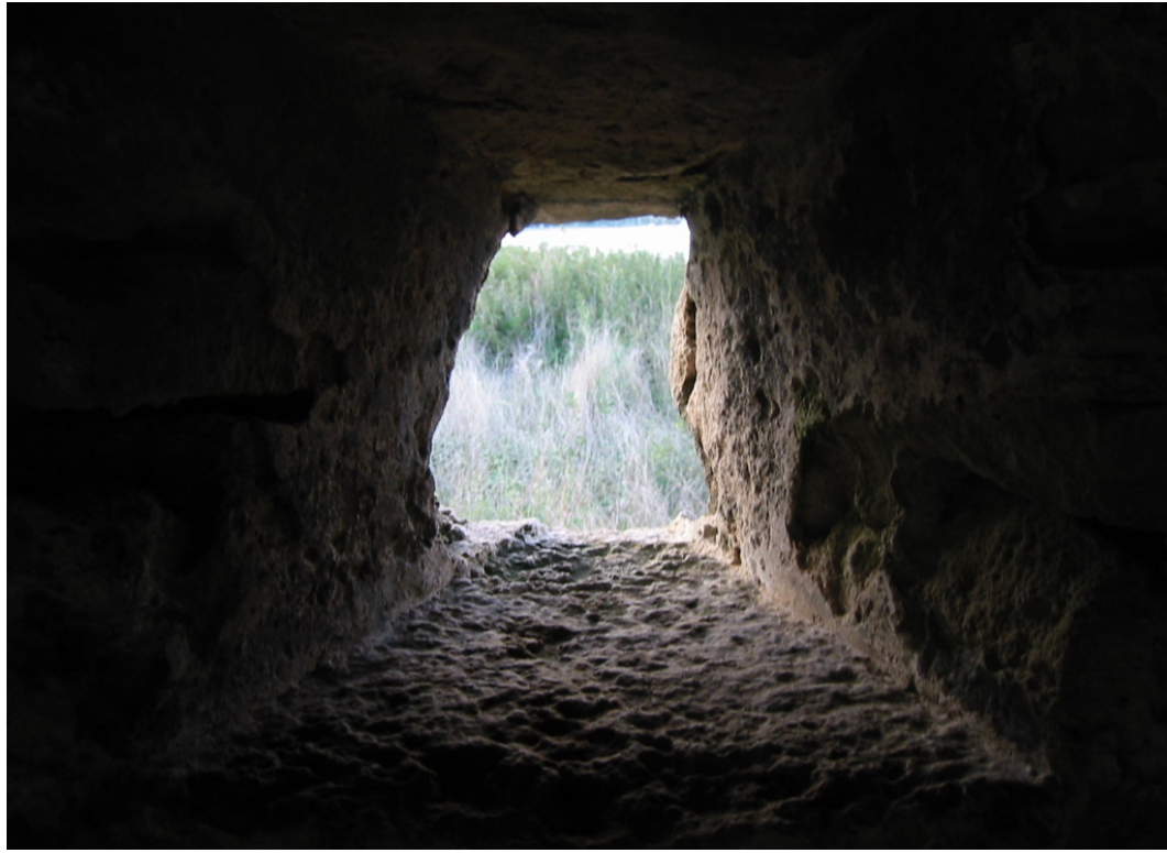
Εικ. 19: Εσωτερική άποψη τυφειοθυρίδας
