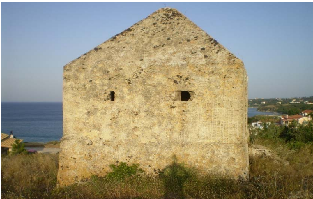
Εικ. 6: Βόρεια όψη βαρδιόλας.
