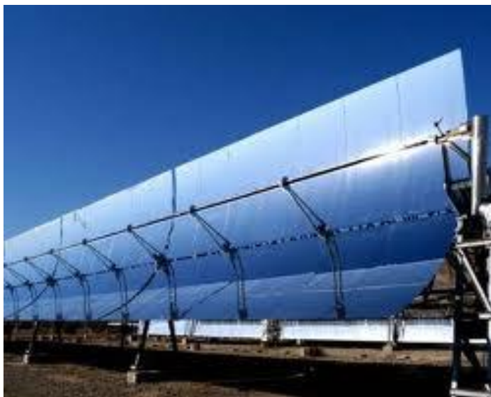
Σχήμα 3.9 - Ένας τυπικός συγκεντρωτικός συλλέκτης παραβολικού σχήματος.
