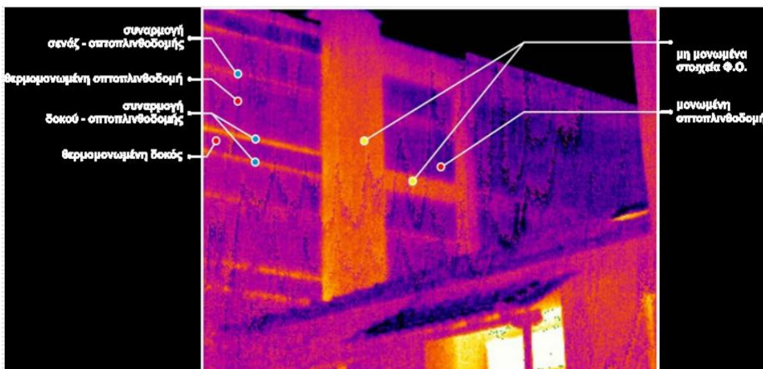
Σχήμα 1.1 - Απώλειες λόγω θερμογέφυρων
