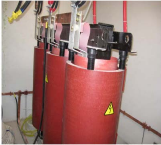
Εικόνα μετασχηματιστή από την εγκατάσταση
