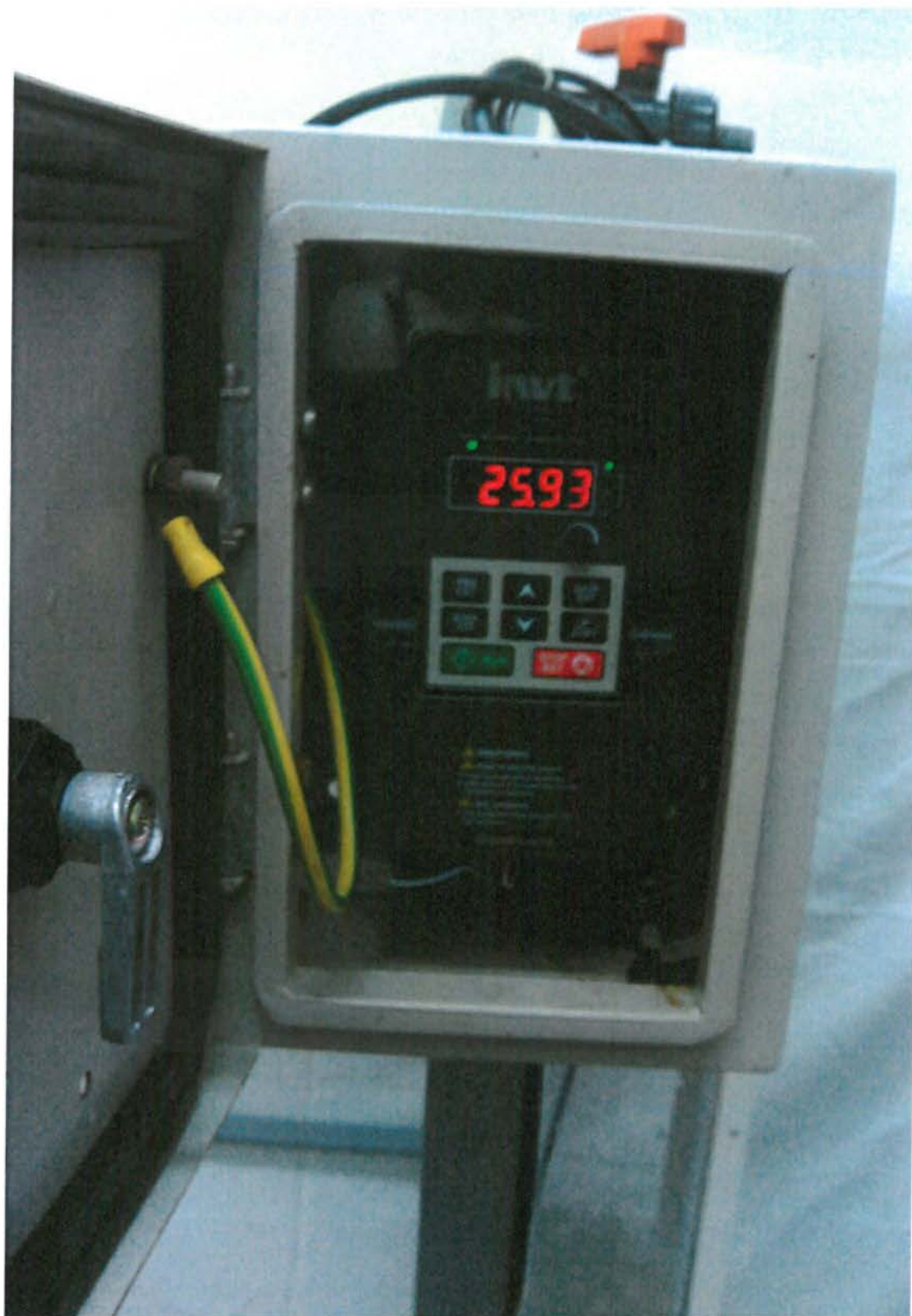
Εικόνα: Inverter σε ώρα λειτουργίας
