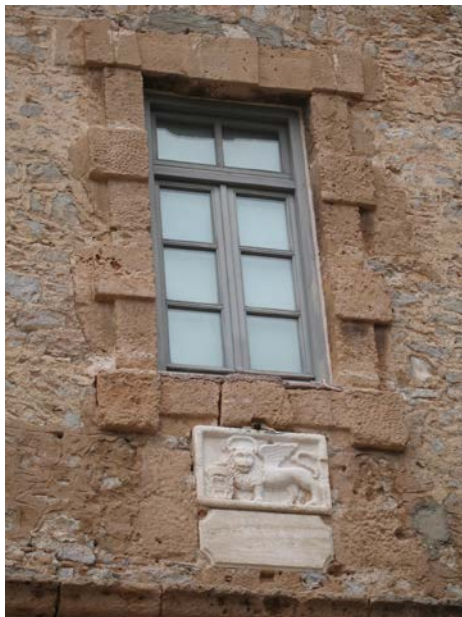
Φωτ. Νο. 2.14 Λεπτομέρεια κτιρίου(στυλ ρούστικας)
