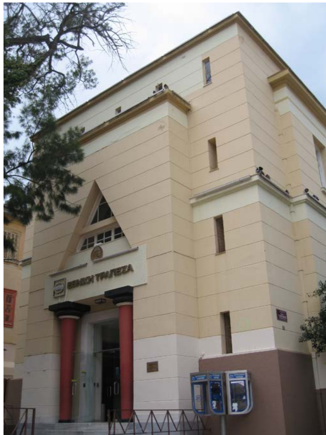
Φωτ. Νο. 3.2 Κεντρική είσοδος κτιρίου
