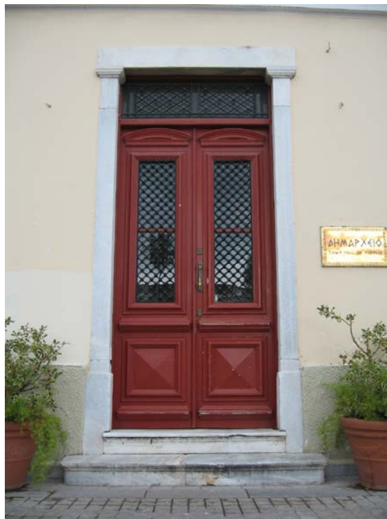
Φωτ. Νο. 2.22 Μαρμάρινα πλαίσια στα ανοίγματα
