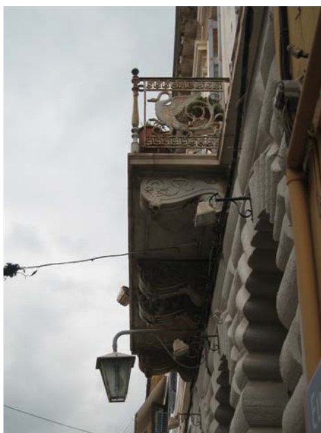
Φωτ. Νο. 2.20 Μαρμάρινος εξώστης του κτιρίου
