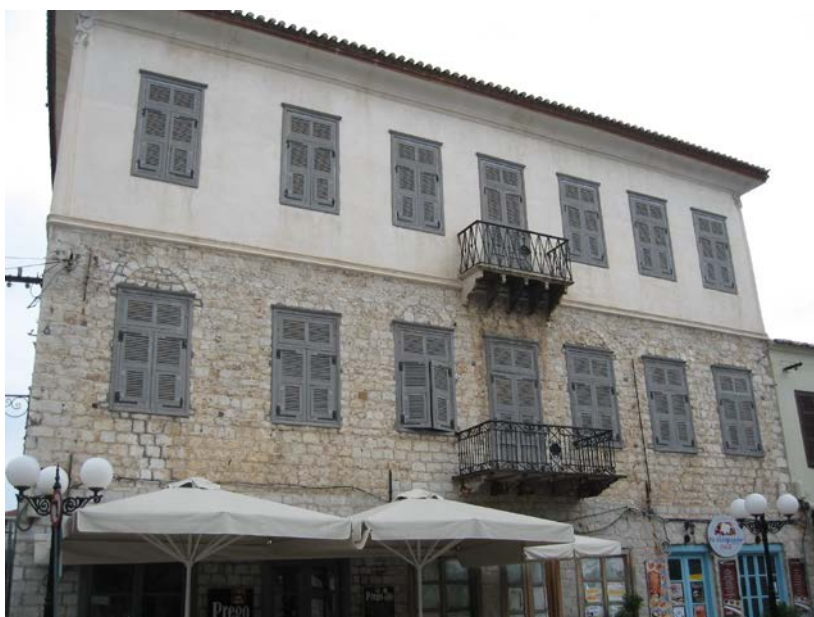
Φωτ. Νο. 2.16 Πρώιμο Νεοκλασικό κτίριο(οικία Μάουερ)
