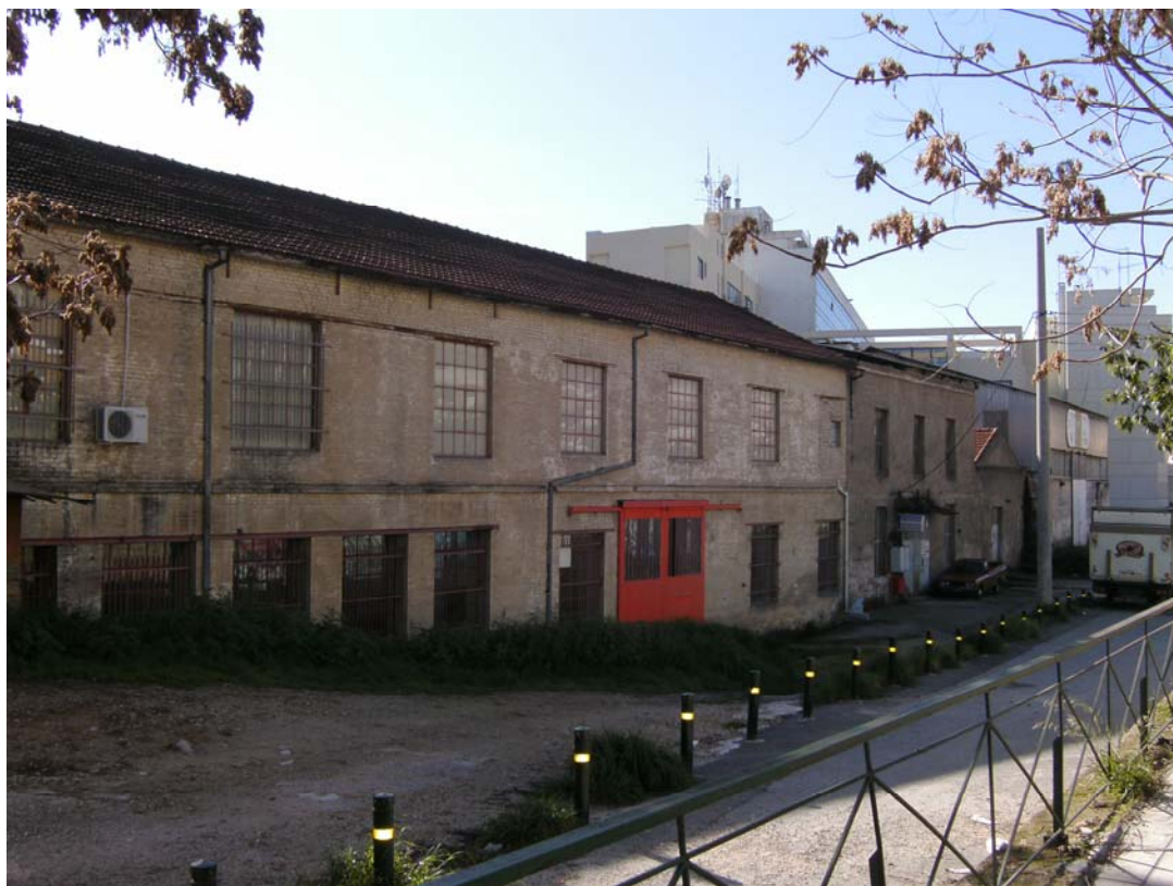
Εικόνες 34: Πίσω όψη του πλυντηρίου της Εριουργίας.
