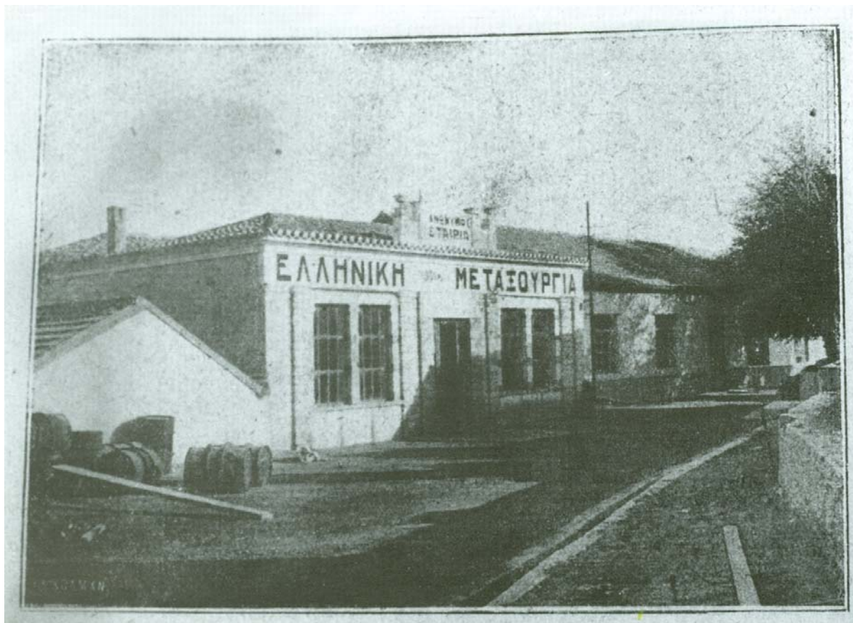
Εικόνα 31: Το παλαιότερο εργοστάσιο της Μεταξουργίας, τμήμα του κτιρίου γνωστό ως «Γραφεία της Μεταξουργίας». Σήμερα, δεν διασώζεται τίποτα από αυτά.
