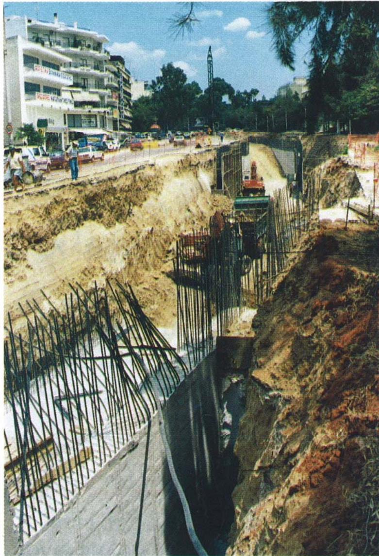
Εικόνα 60: Κατασκευή λεκάνης ηρεμίας κατά την γ' φάση.
