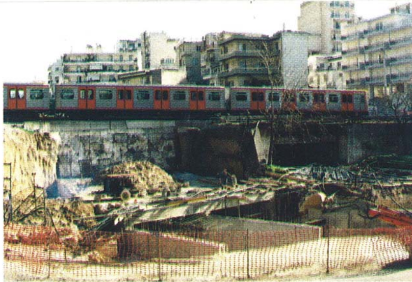
Εικόνα 58 (επάνω): Έργα στον Ποδονίφτη κατά την β' φάση.
