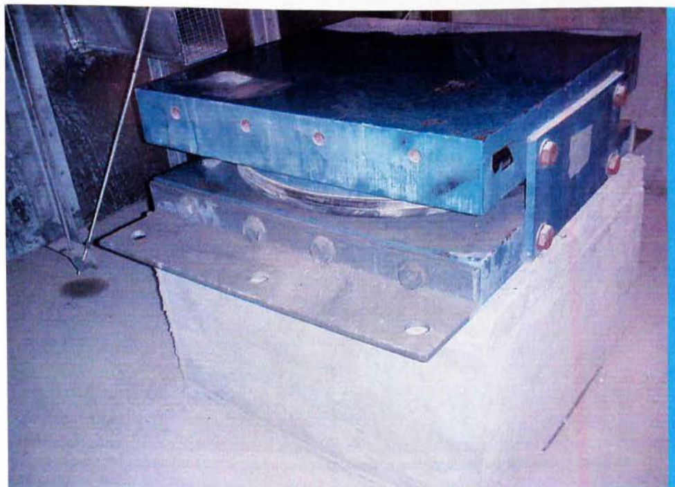
Λεπτομερής φωτογραφία εδράνου στήριξης δεξαμενής στην Ρεβουόσα.
