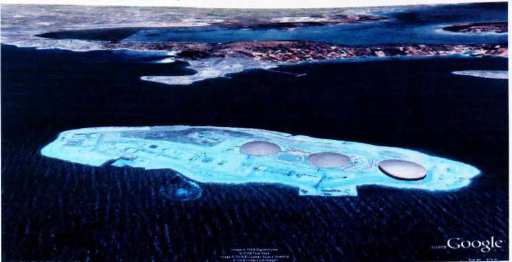
Εικόνα προσομοίωσης από το Google Earth για τη προτεινόμενη θέση της 3 ης δεξαμενής
