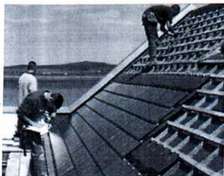
Εικόνα 1.6: Ενσωμάτωση φ/β σε κεκλιμένη στέγη.
