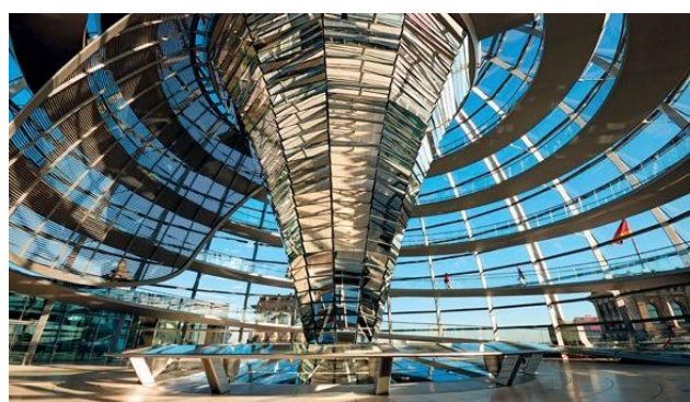
Σχ. 1.3.4.3_5 : Σχηματική διάταξη μοντέλου λειτουργίας φυσικού αερισμού και χρήση νερού στο Γερμανικό Κοινοβούλιο. Εικόνες ηλιακής καμινάδας Γερμανικού Κοινοβουλίου (4)
