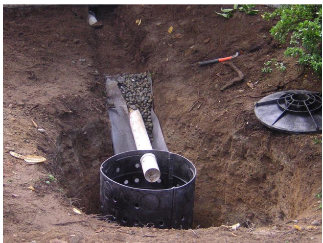
Σχ. 3.2.1.1_2-3 : Επιφανειακοί αυλάκες περιβάλλοντος χώρο για τη συλλογή των όμβριων υδάτων (4) Στη δεξιά εικόνα διακρίνεται η δεξαμενή υδροσυλλογής.
