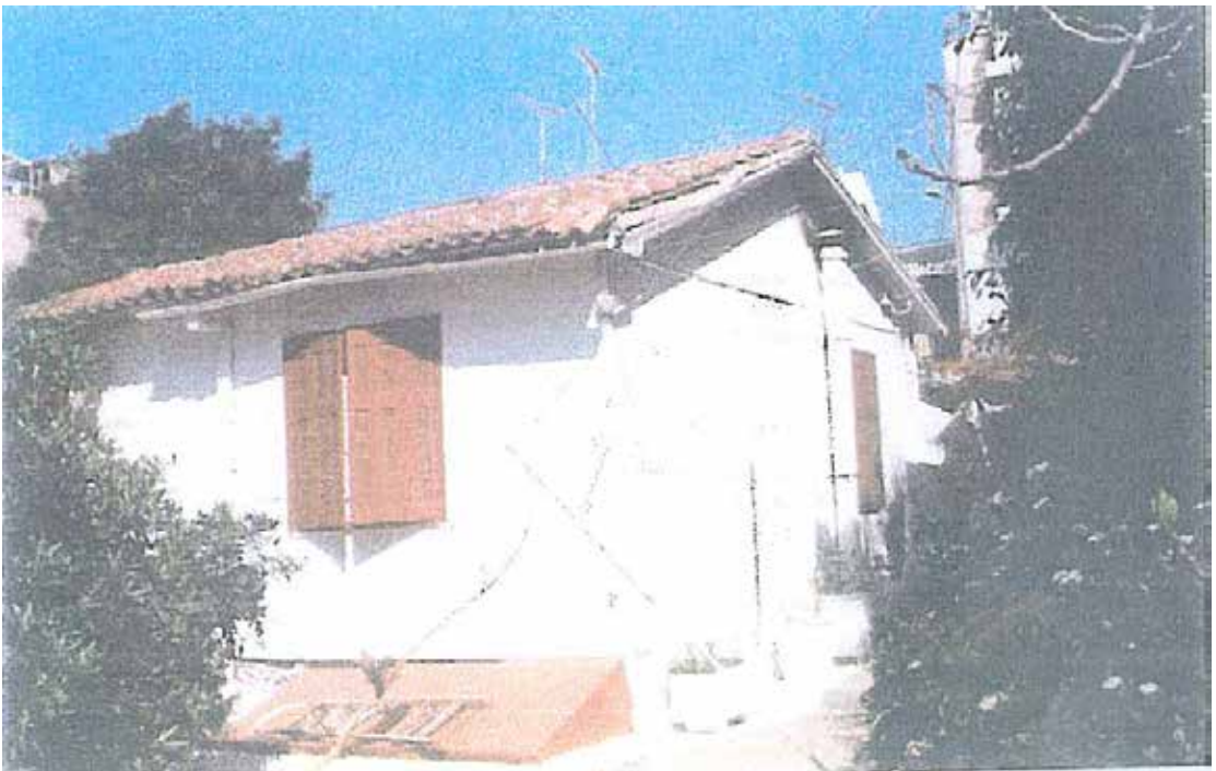
Εικόνα 31: Κτίσμα τύπου Α΄ σε καλή κατάσταση
