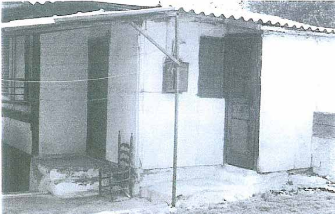
Εικόνα 26: Τύπος Α' όπου διακρίνεται το υλικό κατασκευής
