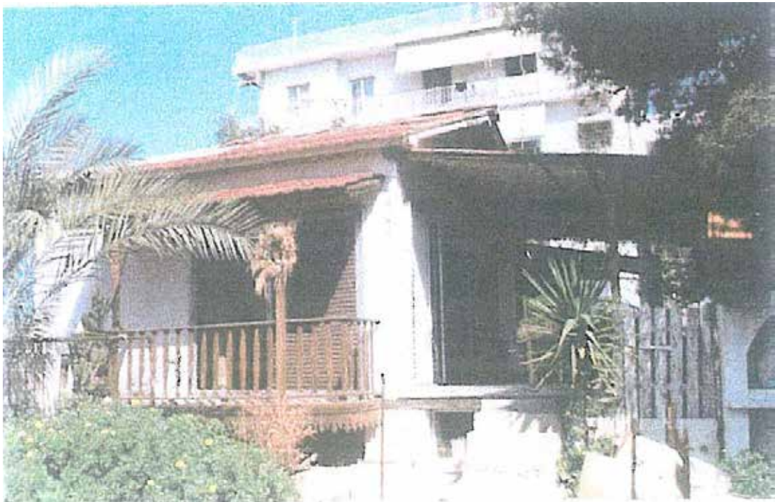
Εικόνα 25: Χαρακτηριστικός τύπος ανακαινισμένου κτίσματος τύπου Α΄
