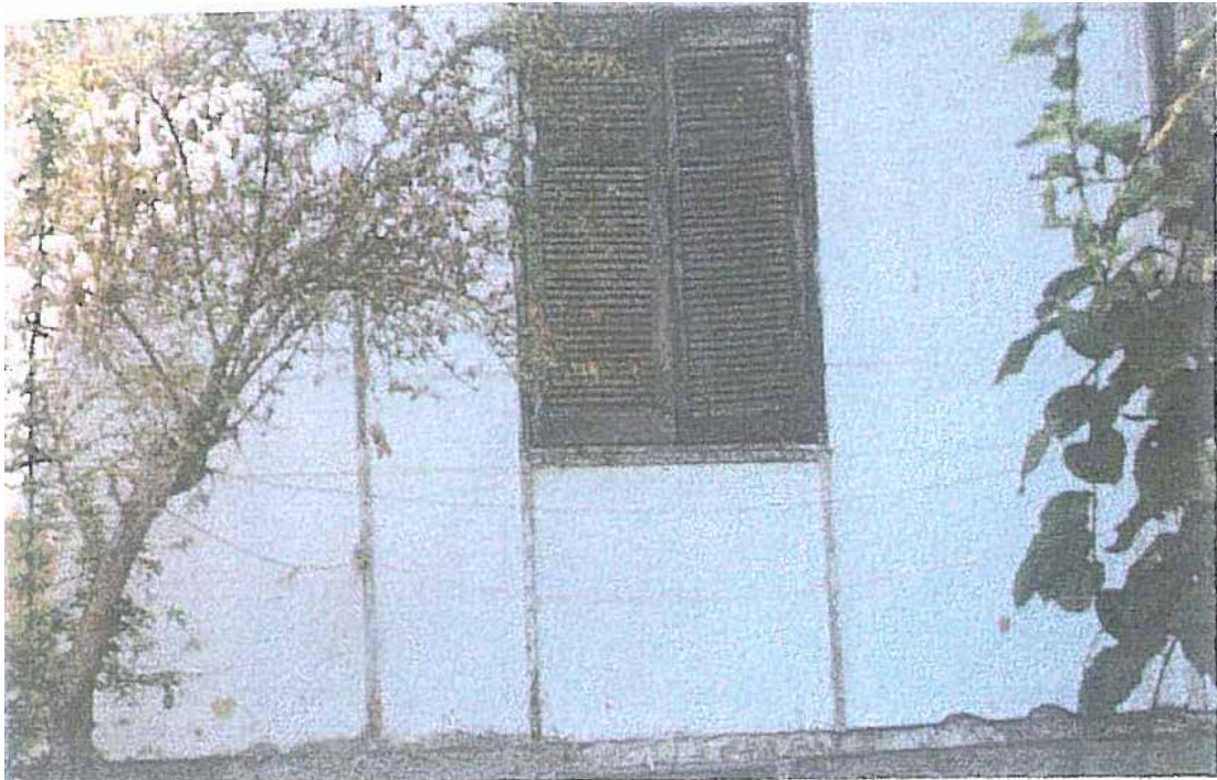
Εικόνα 27: Διακρίνονται οι σανίδες από αμιαντοτσιμέντο καθώς και οι αρμοί σύνδεσης
