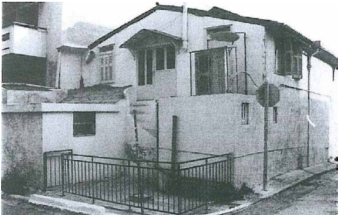
Εικόνα 35: Διαφορετικές φάσεις κατασκευής και συνεχείς προσθήκες
