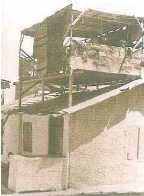
Εικόνα 5: Σπίτι του Συνοικισμού της Δραπετσώνας 1931-1932
