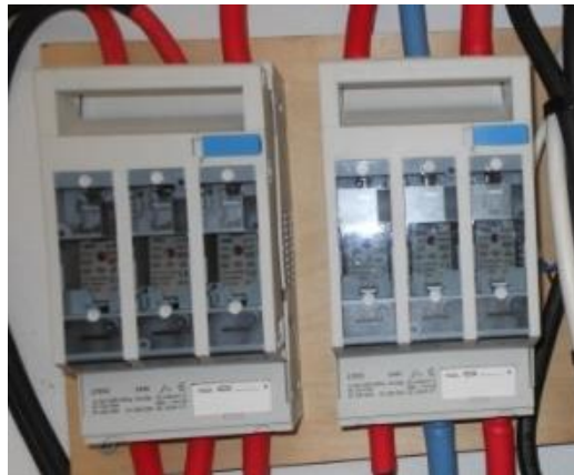
Σχήμα 4.14.: Ασφαλειοαποζεύκτες Hager
