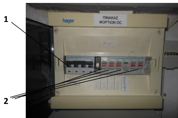
Σχήμα 2.10.: Πίνακας φορτίων DC
