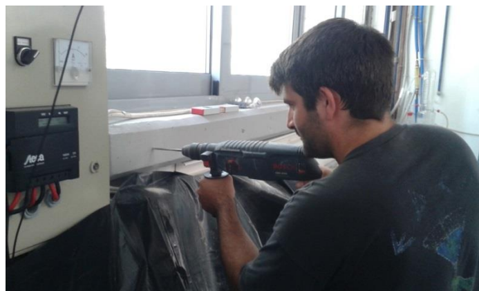
Σχήμα 4.6.: Εγκατάσταση ηλεκτρολογικών καναλιών
