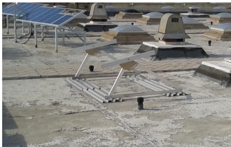
Σχήμα 4.2.: Ρυθμιζόμενες βάσεις Φ/Β πάνελ Vario Top
