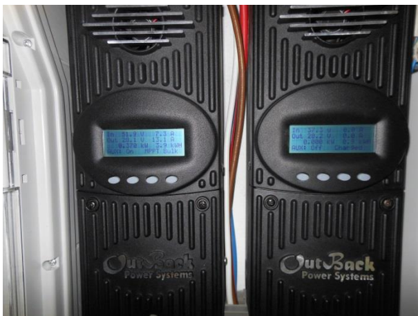
Σχήμα 4.9: Ρυθμιστές Φόρτισης Flexmax 60
