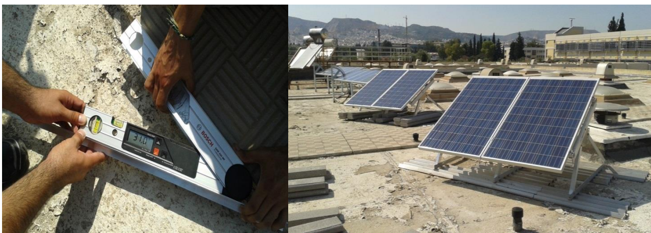
Σχήμα 4.3.: Χρήση κλισιόμετρου για ρύθμιση προσανατολισμού Τελική-θέση των Φ/Β πάνελ
