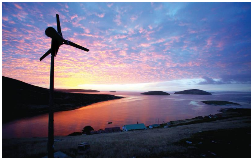
Σχήμα 1.3.: Ανεμογεννήτρια μικρής Ισχύος
