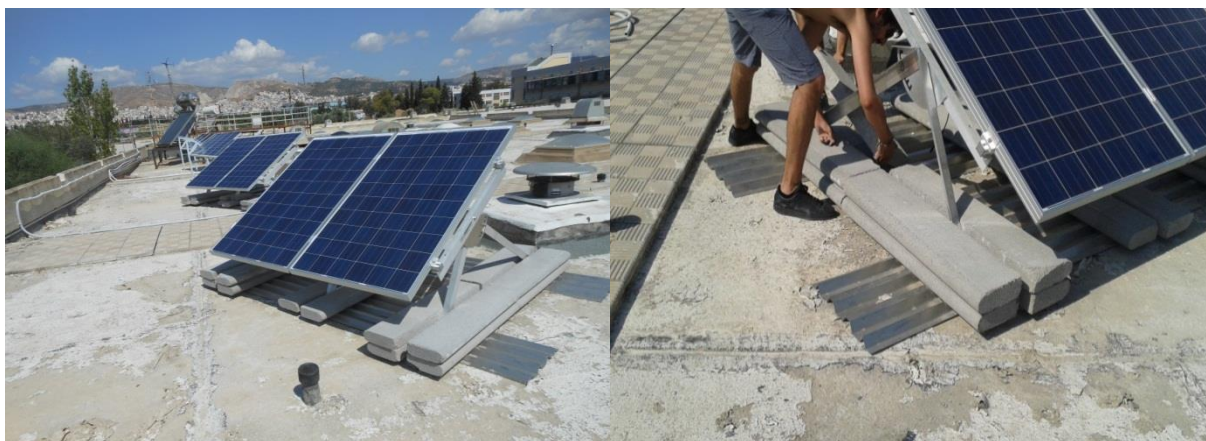
Σχήμα 4.4.: Τελική θέση των Φ/Β πάνελ με αντιστήριξη – Τοποθέτηση αντιστήριξης
