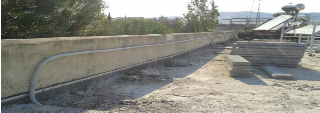
Σχήμα 4.5.: Οδευση καλωδίων
