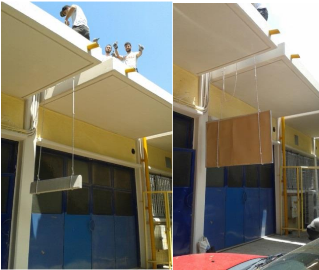
Σχήμα 4.1.: Ανύψωση εξοπλισμού
