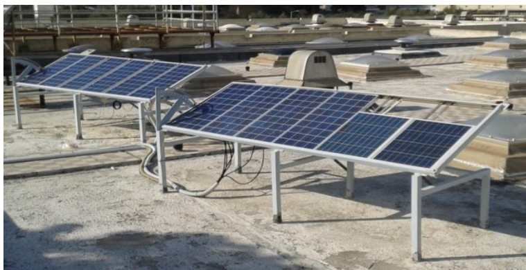
Σχήμα 2.3.: Φωτοβολταϊκή μονάδα 600Wp
